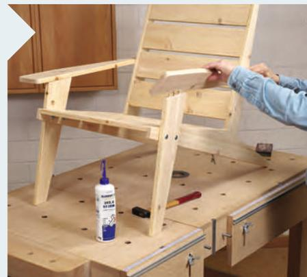
**21** | Erst jetzt leimen Sie zuerst die Runddübel in den Fuß ein und stecken anschließend die Armlehne auf die Dübel. Das Ganze fixieren Sie dann für zwei Stunden mit einer Zwinde.
