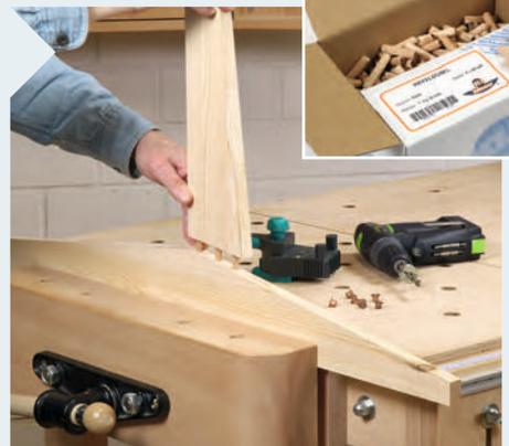
9 Legen Sie die Runddübel aus Eiche bereit. Überprüfen Sie die Passgenauigkeit beider Bauteile aber zunächst einmal ohne Leim.
