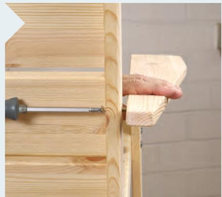
**22** | Hat der Leim abgebunden, drehen Sie zum Schluss noch die M6-Senkkopfschraube in die Gewindemuffe der Armlehne. Zum besseren Transport lassen sich so Sitz und Rückenlehne problemlos von Fuß samt Armlehne trennen.
