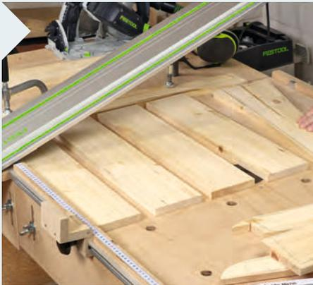
3 Danach sind alle schrägen Bauteile an der Reihe. Unterfüttern Sie dazu die Führungsschiene mit ein paar Sitzbrettern, damit sie beim Auflegen der Tauchsäge nicht nachgibt.
