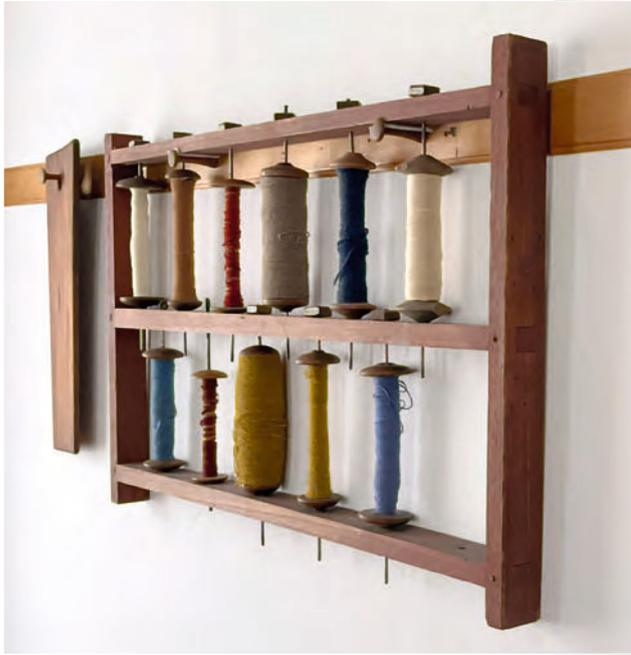
Ein sehr bekanntes Detail sind die umlaufenden „Peg Rails“. An diesen Leisten lassen sich die leichten Stühle ebenso schnell weghängen wie Arbeitsgeräte.
