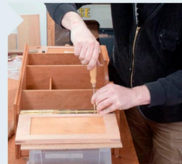
**28** Kleben Sie etwas doppelseitiges Klebeband auf die Kanten der Seite und richten Sie die Tür dann im geschlossenen Zustand aus. Ist das Klavierband aufs Klebeband gedrückt, schrauben Sie die Türen ebenfalls fest.
