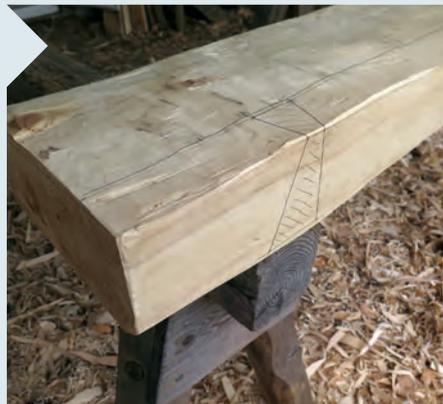
**5** Längen Sie das Kantholz für das Bett der Drehbank auf 1,40 m ab und reißen Sie im Abstand von 25 cm vom Ende die vier Schwalben an. Die Schwalben werden nun eingesägt. In der Draufsicht beträgt die Tiefe 42 mm, in der Vorderansicht 90 mm.
