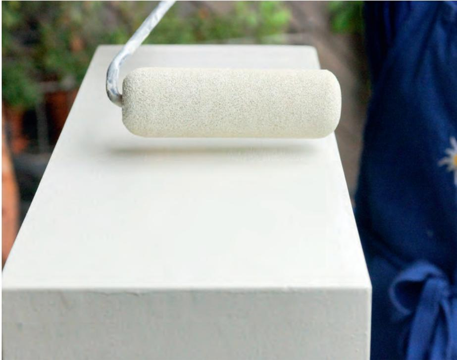
Sollten beim Farbauftrag feine Bläschen entstehen, platzen diese auch wieder, wenn man den Druck beim Rollen so verringert, dass die Walze fast schwebt. Tauchen Sie mit der Walze fliegend in die Bahn ein.
