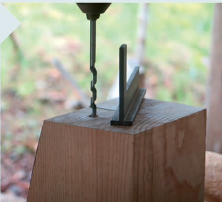
**13** | Als nächstes wird am rechten Reitstock das Loch für die gekröpfte Spitze eingebohrt. Da die Spitze einen spitz zulaufenden Vierkant hat, bohren Sie abgestuft jeweils 20 mm tief – erst mit 14 mm, dann mit 12, mit 10 und zum Schluss mit 8 mm Schlangenbohrern.
