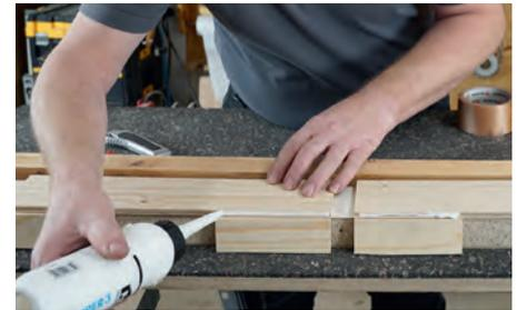
Die beiden vorderen Teile sind die Haltestreifen. Liegt die Grundplatte erhöht, können Sie zum leichteren Auftragen des Leims die mit Klebestreifen an die Grundplatte geklebten Haltestreifen herunterklappen.
