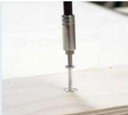
**1** Ein Multiplex-Abschnitt unter der Oberfräse und fertig ist die Kreisschablone für die Tischplatte. Zur Fixierung wird die Schablone am Kreismittelpunkt der Platte durch eine Schraube mit Teilgewinde fixiert.
