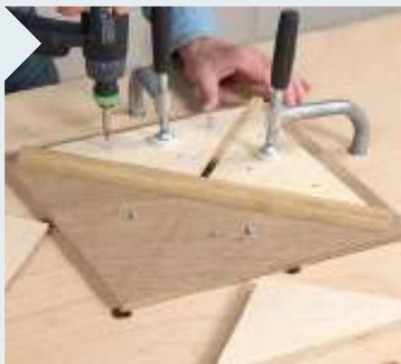
**3** Schrauben Sie zunächst nur zwei Dreiecke auf die Deckelplatte. Nutzen Sie als Abstandshalter die zuvor gefräste Gleitleiste. Erst danach schrittweise auch die anderen beiden Dreiecke aufschrauben.
