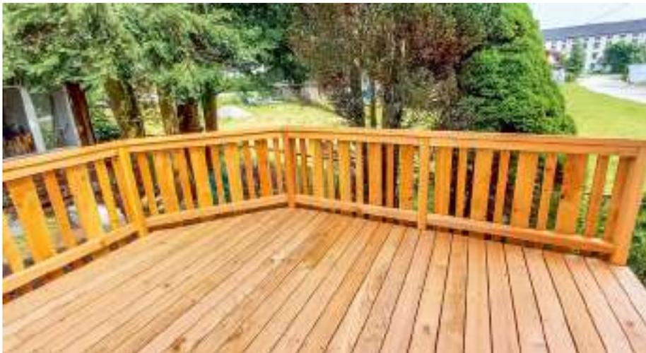
**Eine neue Terrasse musste her!** Die ganze Terrasse ist aus heimischen Lärchenholz gebaut worden. Für die Unterkonstruktion habe ich Balken (120 x 160 mm) verwendet und knapp einen Meter über Boden montiert. In den Ecken des umlaufenden Rahmens wurden Überblattungen mit Kapp- und Tauchsäge angefertigt. Die inneren Träger sind mit Balkenschuhen montiert. Es gibt zwei Treppen
