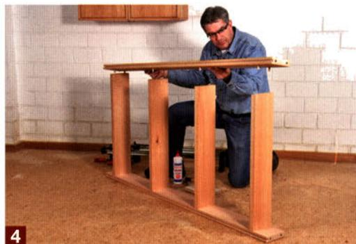
Die passenden Gegenlöcher in den Schwingen markieren Sie sich am besten mit Dübelmarkierern (Dübelfixe) und bohren diese Löcher auf dem Bohrständler. Zum Schluss das gesamte Schwingengerüst endgültig verleimen.
