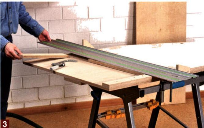
3 Anschließend legen Sie das Werkstück unter die Führungsschiene und dicht an die Anschlagleiste. Die Schiene an den Enden mit den passenden Zwingen fixieren (falls nötig hinten noch ein Restholz in Werkstückdicke unterlegen).
