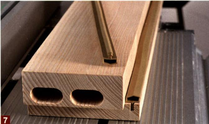
Hohlkammerdichtungen für Zimmertüren gibt es in unterschiedlichen Formen und Farben. Die hier eingesetzte Profilform wird unter Fachleuten auch „Häuschendichtung“ genannt.
