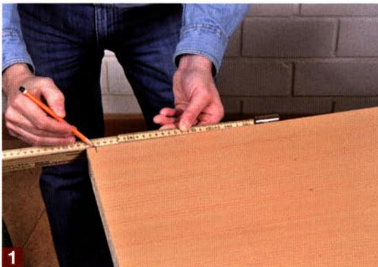
Messen Sie zunächst am Türfutter den Abstand vom Laminatboden bis zum unteren Türscharnier aus (dort wo beide Scharnierteile nach dem Einhängen zusammenstoßen). Legen Sie den Meterstab am unteren Türscharnier an und übertragen Sie dieses Maß abzüglich 3 mm Luft auf die Türfläche.
