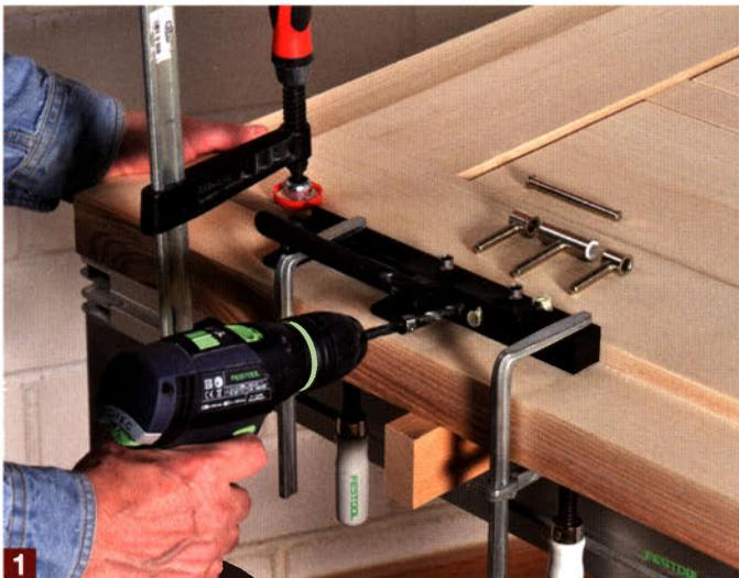
Benutzen Sie in jedem Fall die zum Einbohrband passende Bohrlehre und versuchen Sie auf keinen Fall durch bloßes Anzeichnen die Löcher zu bohren. Das geht garantiert schief!
