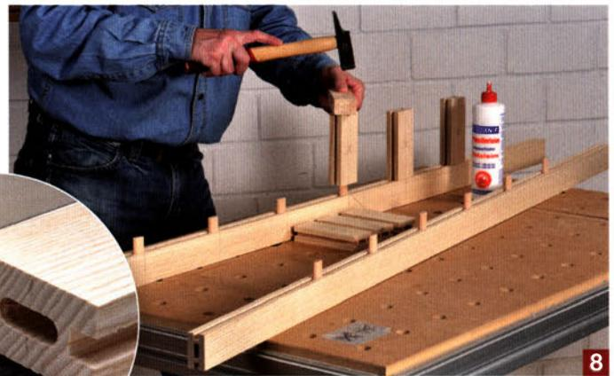
Verleimen Sie anschließend die 6 Quersprossen mit Dominos an die beiden aufrechten Sprossen und spannen Sie das Ganze für mindestens zwei Stunden mit Zwingen zusammen.
