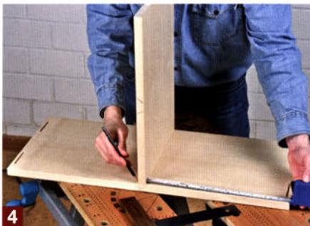
Die Position des Zwischenbodens mit einem Bleistift markieren, anschließend den Boden zur Seite klappen und an der Markierung rechtwinklig zur Seitenwand ausrichten ...
