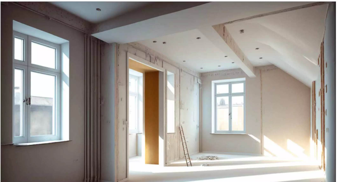
Hier sind die Flächen schon in großen Teilen abgezogen. Die verbliebenen Löcher sind für die Elektrik, Schalter, Lampen, etc.
