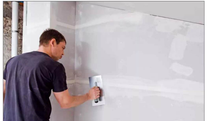
6 Beim Verspachteln zum Beispiel mit Knauf Uniflott ohne Fugendeckstreifen ist zu beachten, dass Kanten an beanspruchten Flächen und in Bereichen, die Bewegungen ausgesetzt sind, mit einem Fugendeckstreifen verspachtelt werden müssen, um nachträgliche Rissbildung zu vermeiden. Nur so viel Knauf Uniflott anmischen, wie in der Verarbeitungszeit verbraucht werden kann. Für Feuchträume den wasserabweisenden Uniflott imprägniert verwenden
