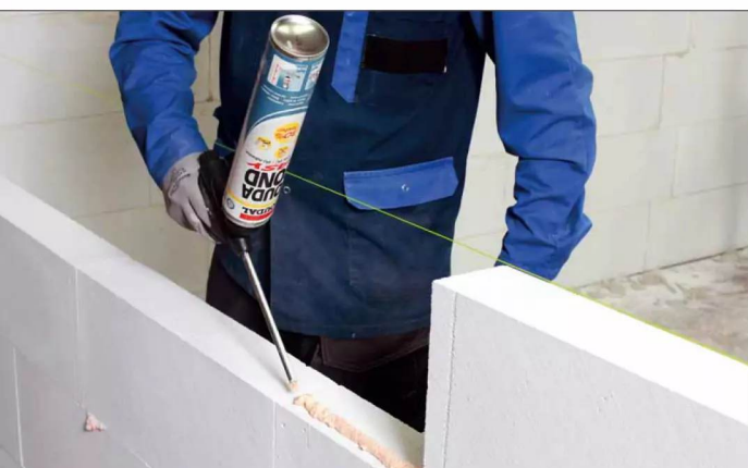
Die einzelnen Steine werden mit Klebschaum aus der Sprühdose verklebt
