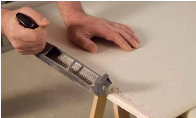
5 Jede geschnittene bzw. nicht kartonummantelte Kante ist vor dem Verspachteln anzufassen und mit Tiefengrund zu grundieren, um das Einfallen der Spachtelmasse zu verhindern. Die Gipsplatten mit dem Kantenhobel oder Cuttermesser schräg anfasen. Anschließend mit Raspelhobel glätten und die Kante von Staubresten befreien
