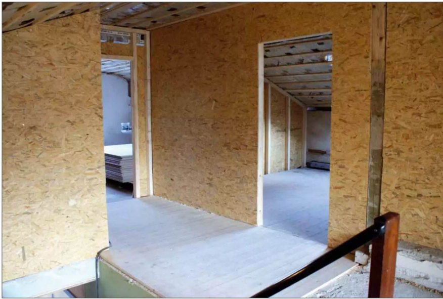
Man kann auch Holzplatten statt des Gipskartons verwenden. Allerdings müssen auch hier die Übergänge gespachtelt werden
