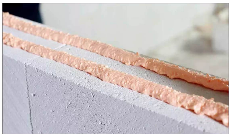
Zwei gleichmäßige Stränge des Klebers genügen für eine stabile Verbindung
