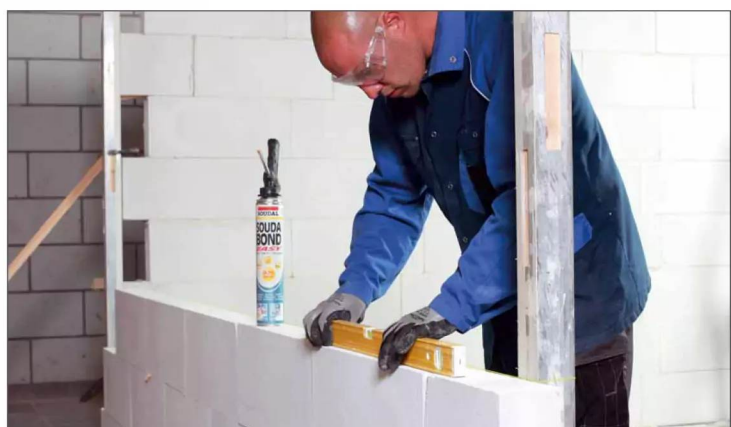
Kleber zum Anrühren war gestern. Heute kommt der Klebstoff für Porenbeton bequem und sauber aus der Sprühdose
