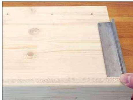
**20** Dann bringt man die anzuleimende Strebe in Position. Ist die gefunden, wird die Strebe ange-drückt. Die herausragenden Schraubenspitzen verhindern, dass die Strebe auf dem glitschigen Leimfilm verrutscht.
