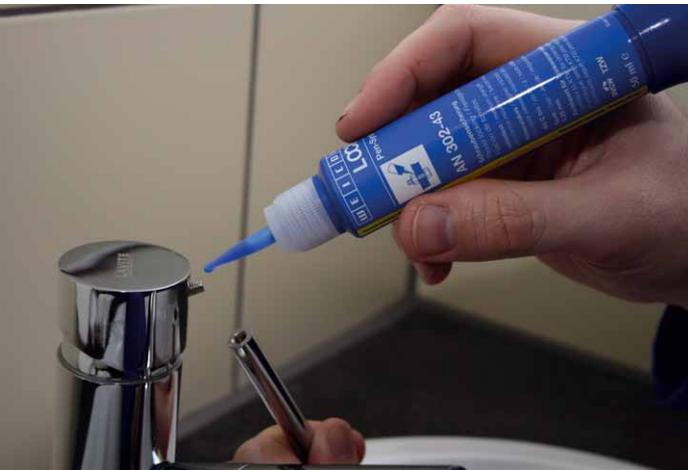
Bei Weiconlock handelt es sich um flüssige Kunststoffe, die als anaerob bezeichnet werden, weil sie unter Luftabschluss aushärten
