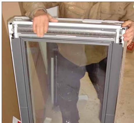
**9** Danach kann das eigentliche Fenster ausgepackt und für den Einbau vorbereitet werden
