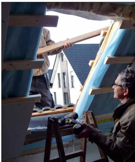
**6** Von außen werden anschließend die restlichen Dachpfannen abgeräumt und der Einbau des Einbaurahmens wird vorbereitet
