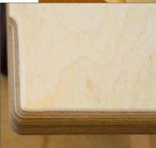
Die Kanten der Sockelplatte und der Tischplatte sollten abgerundet werden. Am besten mit einer Oberfräse und Viertelstabfräser. Grobes Schmirgelpapier leistet aber auch gute Dienste
