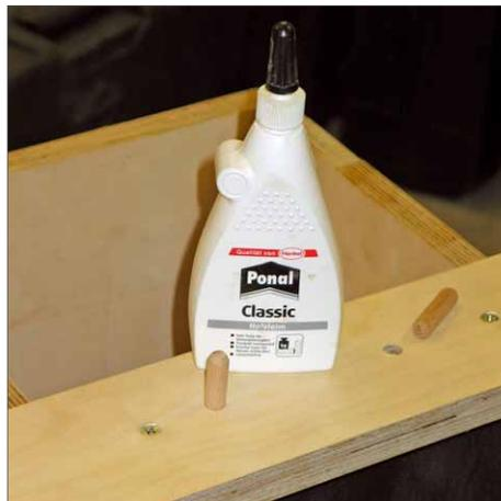
Für eine auch langfristig wackelfreie Verbindung sollte man zusätzlich zu den Schrauben auch Holzdübel verwenden
