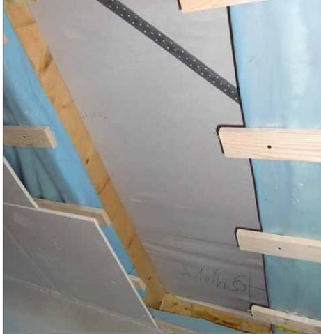
**3** ... anschließend wird die Stützverlattung der Isolierung herausgesägt
