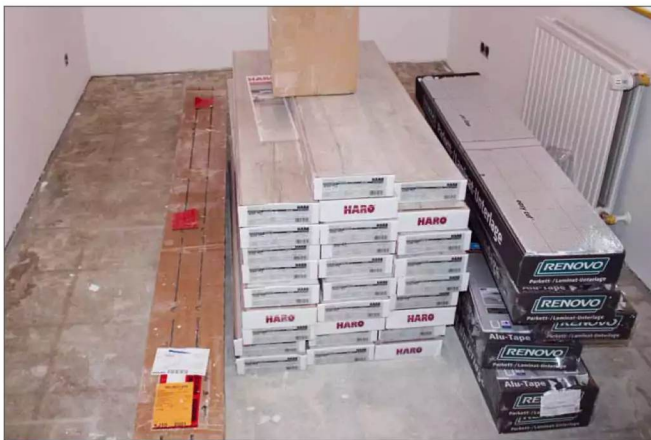
3 Anschließend wird das Laminat ca. 24 bis 48 Stunden zur Akklimatisierung in den Räumen gelagert
