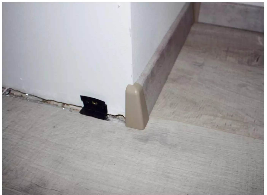
14 Durch Eckstücke aus Kunststoff wird dem Heimwerker der Gehrungsschnitt erspart
