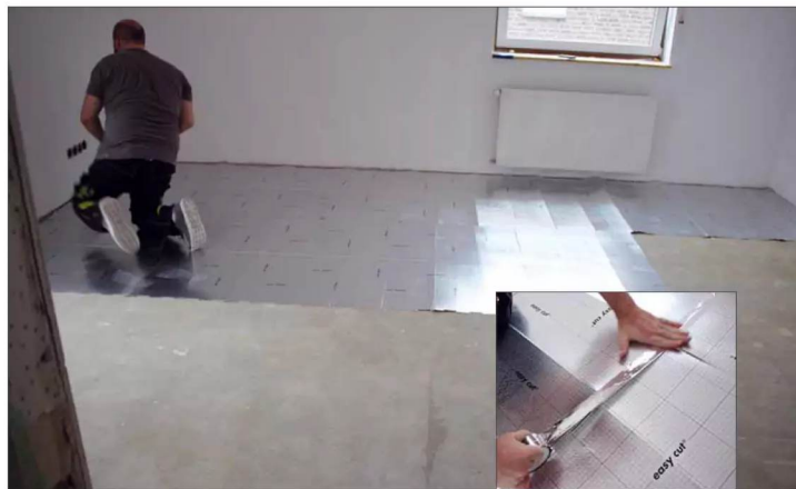
4 Als Erstes wird die Trittschalldämmung verlegt und die einzelnen Bahnen der Trittschalldämmung werden mit Isolierklebeband verbunden
