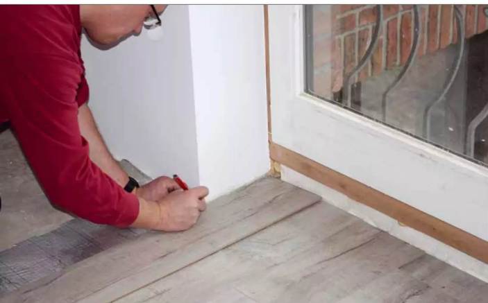
9 An Hindernissen wie Balkontüren und Kaminen werden die Paneele einzeln angepasst, sodass der Boden um die Hindernisse „herumfließt“
