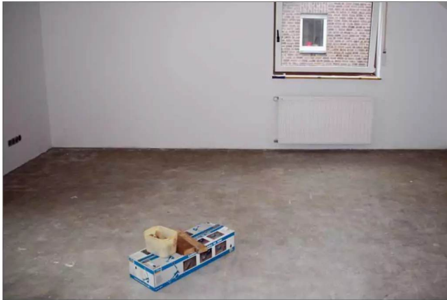
1 Die Vorbereitung ist einfach: Die Räume sind besenrein, ...
