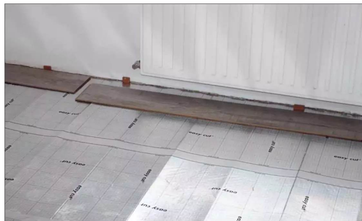
6 Die Verlegung und Ausrichtung der ersten Reihe nimmt am meisten Zeit in Anspruch
