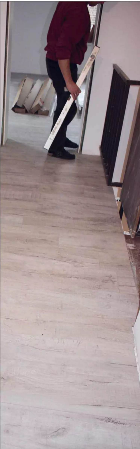
12 Eine ordentliche Überlappung der Paneele muss auch im schmalen Flur sichergestellt werden
