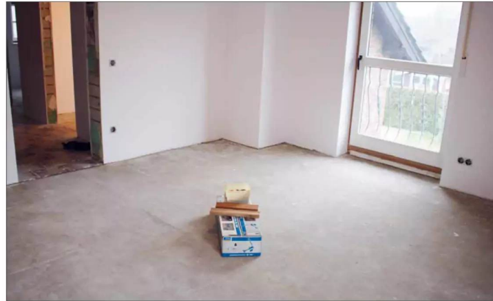
2 ... danach wird der Raum besichtigt, verschiedene bauliche Hindernisse wie Balkontüren, Zimmertüren und vorstehende Schornsteine müssen bei der Verlegung berücksichtigt werden.
