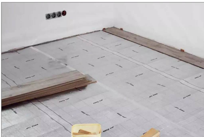
5 Jetzt kann die erste Reihe Laminat darauf verlegt und mit Abstandhaltern ausgerichtet werden. Hier wird von den Herstellern meist ein Wandabstand des Bodens von 5 bis 10 Millimetern empfohlen
