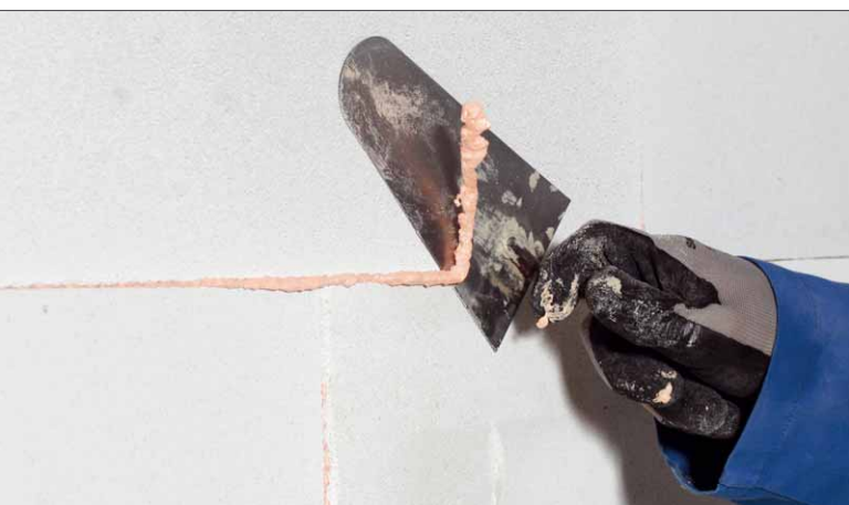
Überschüssiger Klebstoff kann einfach mit einem Spachtel entfernt werden
