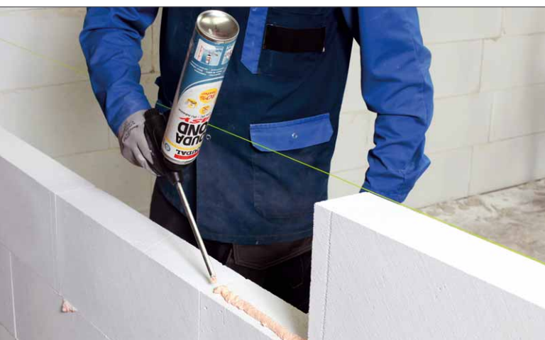
Die einzelnen Steine werden mit Klebeschaum aus der Sprühdose verklebt
