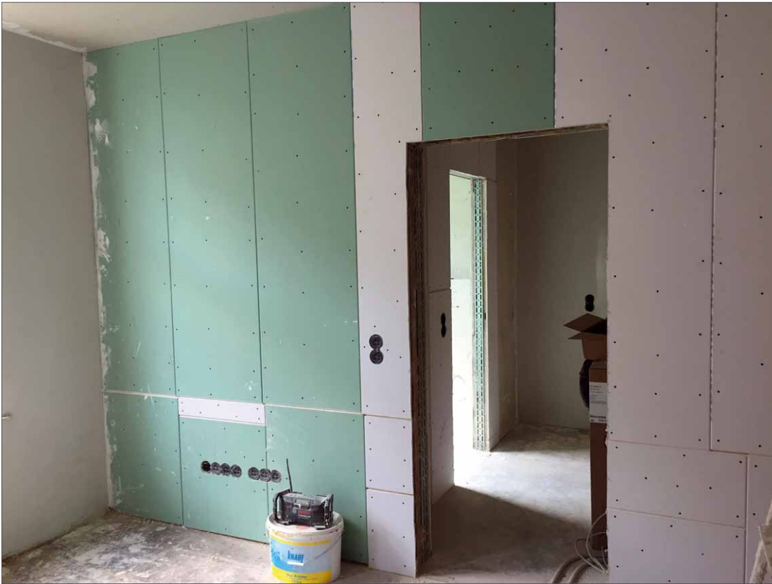
Die Verkleidung steht, aber die Flächen müssen noch verspachtelt werden. Gut sind die Schraublöcher an den Platten zu erkennen
