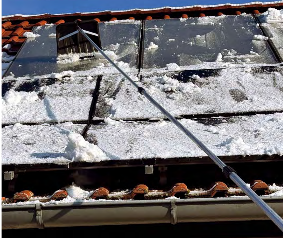
Durch die Auskehlung des Räumschildes wird der Schnee sauber von der Fläche gezogen
