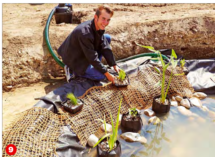
Zur Bepflanzung ebener Bereiche werden Kokosmatten ausgelegt. Sie ermöglichen den Pflanzen, mit ihren Wurzeln optimal Halt zu fassen.
