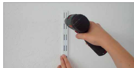
... dann folgt die Befestigung der ersten Schiene
