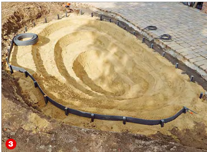
Nach dem Aushub wird erst der Grund mit Füllsand beschichtet und anschließend können die Teichränder eingesetzt werden.
