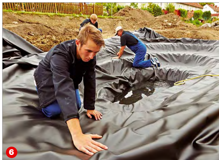
Anschließend wird die Teichfolie sorgfältig verlegt. Durch Befüllen des tiefen Teils wird die Folie vorfixiert.
