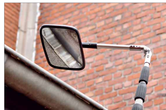
Mit dem Spiegel können Dachrinnen bzw. der Erfolg der Reinigung überprüft werden
