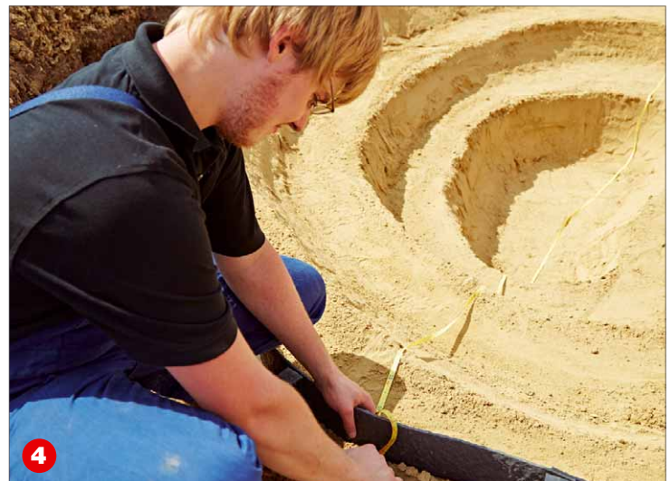
Mit einer Messschnur wird die Foliengröße bestimmt. Hierbei sollte großzügig gemessen werden.
