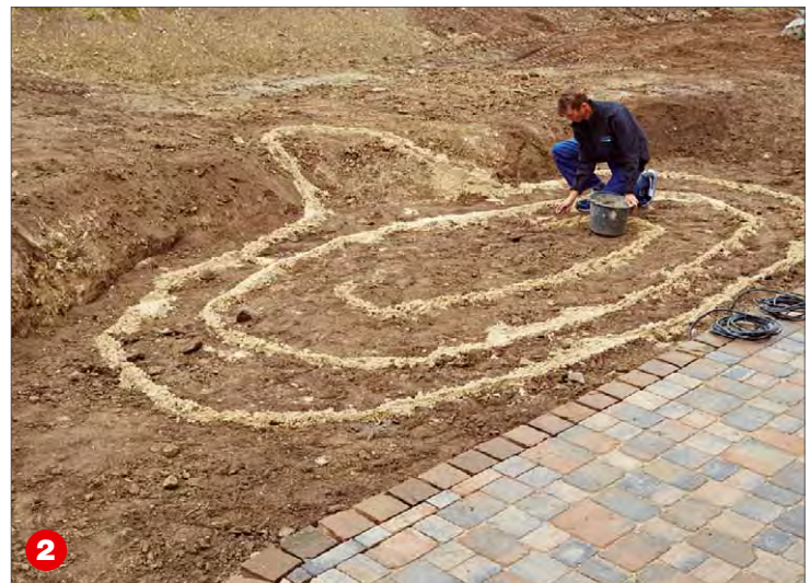
Zuerst wird mit Sand die grobe Form des Teichs und seines Bachlaufs festgelegt.
