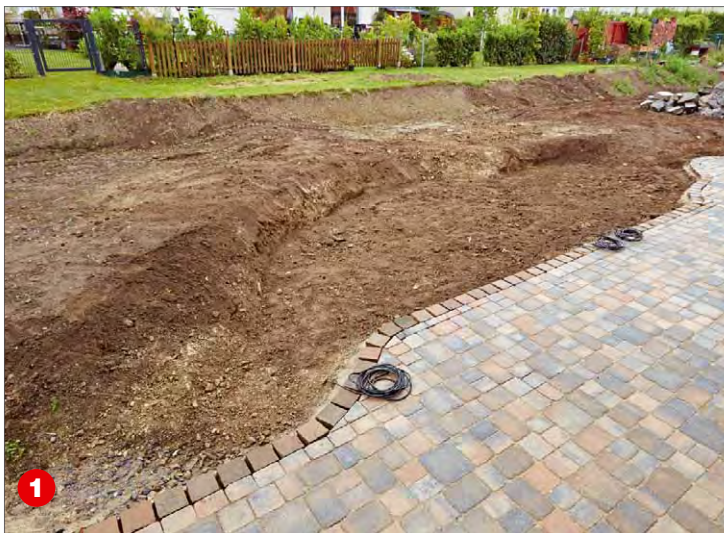
Hier am Rand der Terrasse soll der Teich entstehen.
