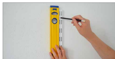
Als erstes wird die Schiene gerade ausgerichtet und die Bohrungen angezeichnet ...
