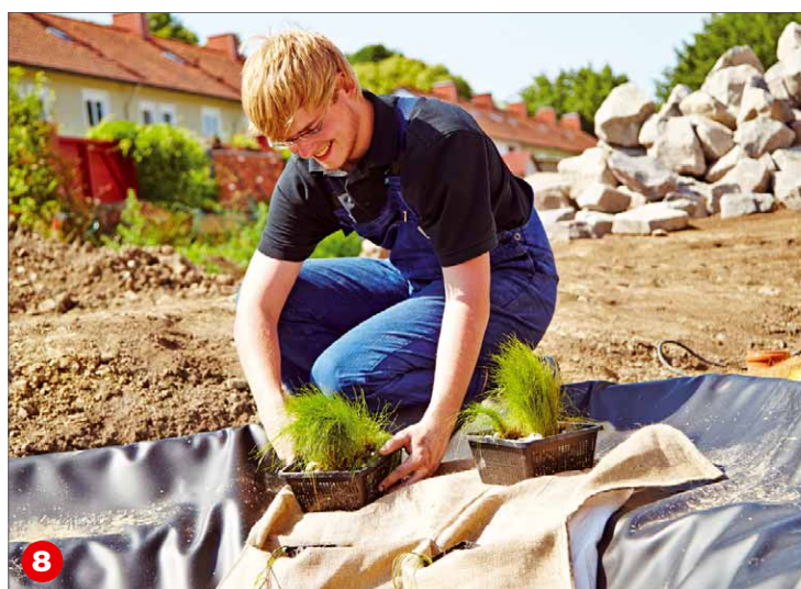
Steile Abschnitte des Ufers werden mithilfe von Böschungstaschen bepflanzt. Beschweren Sie diese zunächst z.B. mit großen Steinen, um die Pflanzen einzusetzen.
