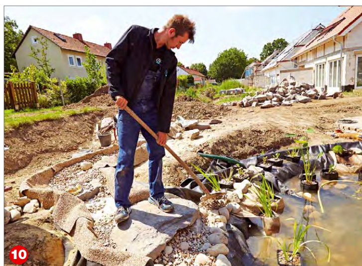
Nach den Kieselsteinen kommt endlich das Wasser in den Teich: zunächst zur Hälfte, und erst, wenn sich die Folie vollständig gesetzt hat, wird ganz aufgefüllt.
