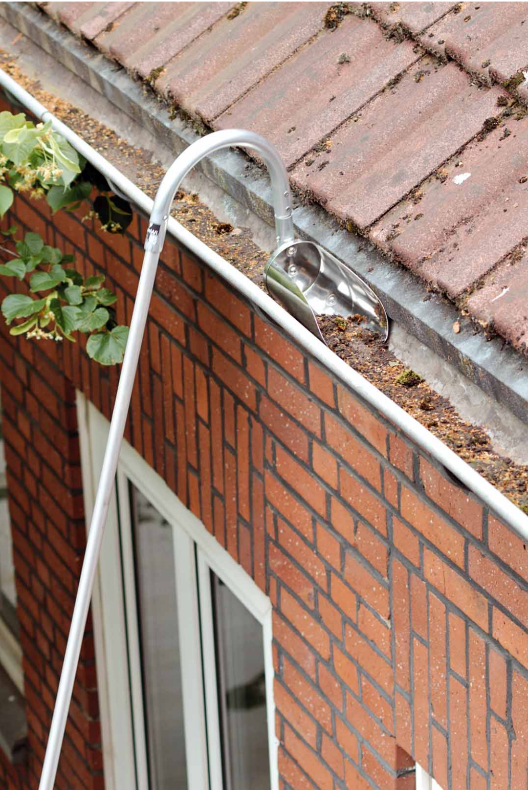
Der Besen kann durch händisches Formen an die Dachrinne angepasst werden
