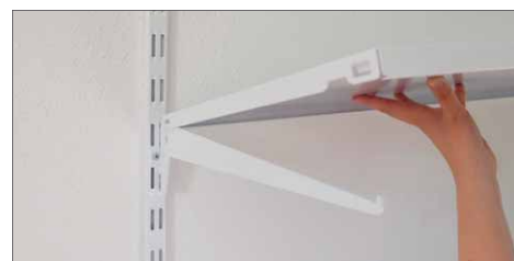
Zum Schluss werden die Bodenträger eingehängt und der Boden aufgelegt
