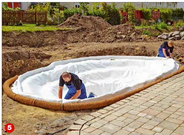
Anschließend wird ein Schutzvlies gegen Wurzeln und Steine eingebracht, um die eigentliche Teichfolie zu schützen.
