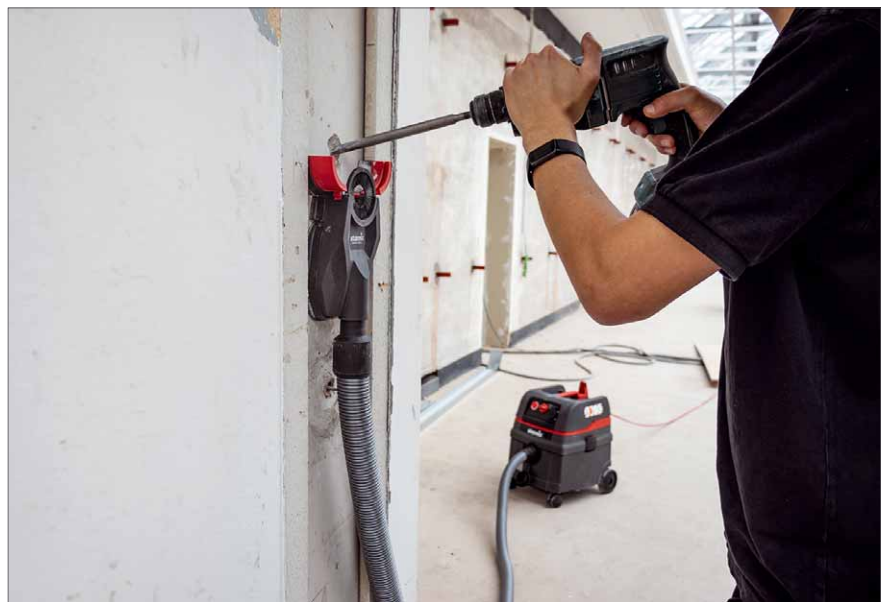
Ausklappbare Seitenflügel vergrößern den Absaugbereich
