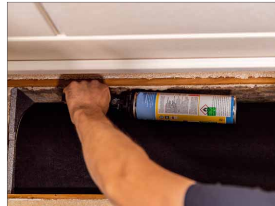
Bevor der Rollladenkasten wieder verschlossen wird, werden klein Undichtigkeiten mit nicht quellender Dichtmasse verschlossen
