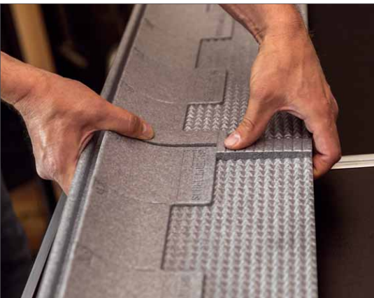
Bei breiteren Rollläden lassen sich die Bodenplatten mehrerer Sets miteinander verbinden
