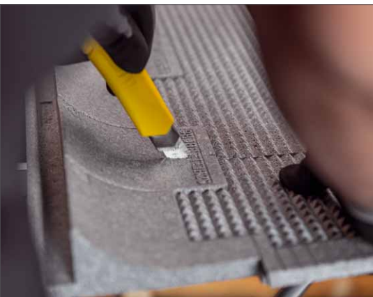
Die Boden- und die Dämmplatte können mit einem Cutter auf Maß geschnitten werden
