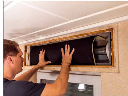
Jetzt wird die Dämmplatte eingesetzt und geprüft ob der Rollladen freigängig ist
