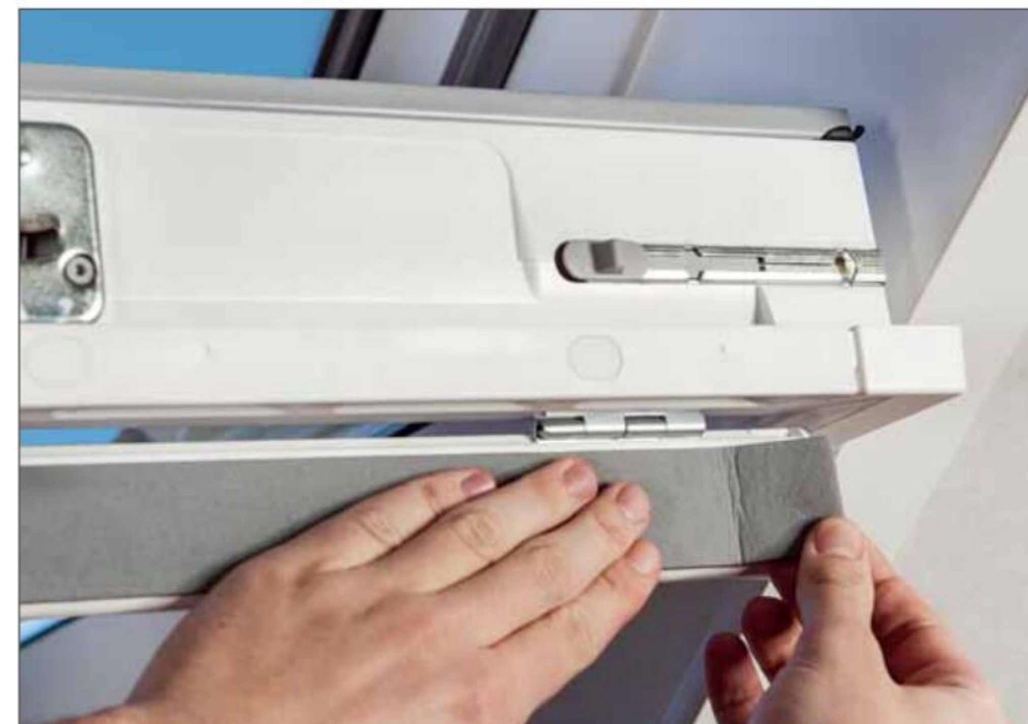
Auch die Dichtungen von Dachfenstern sollten geprüft und gegebenenfalls ausgetauscht werden (Foto: Velux Deutschland GmbH)
