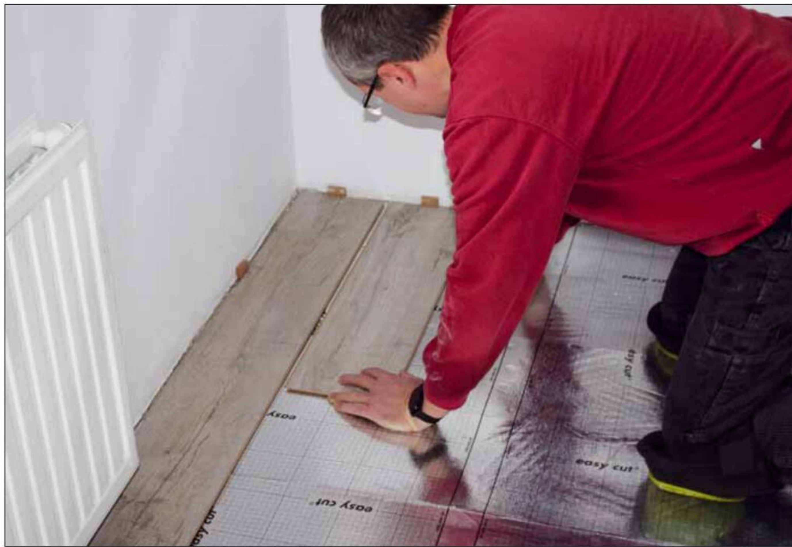
7 Anschließend kann die zweite Reihe angeschlossen werden, dabei sollte eine Überlappung der Kopffugen von Rund 500 mm eingehalten werden, um dem Boden die nötige Stabilität zu geben
