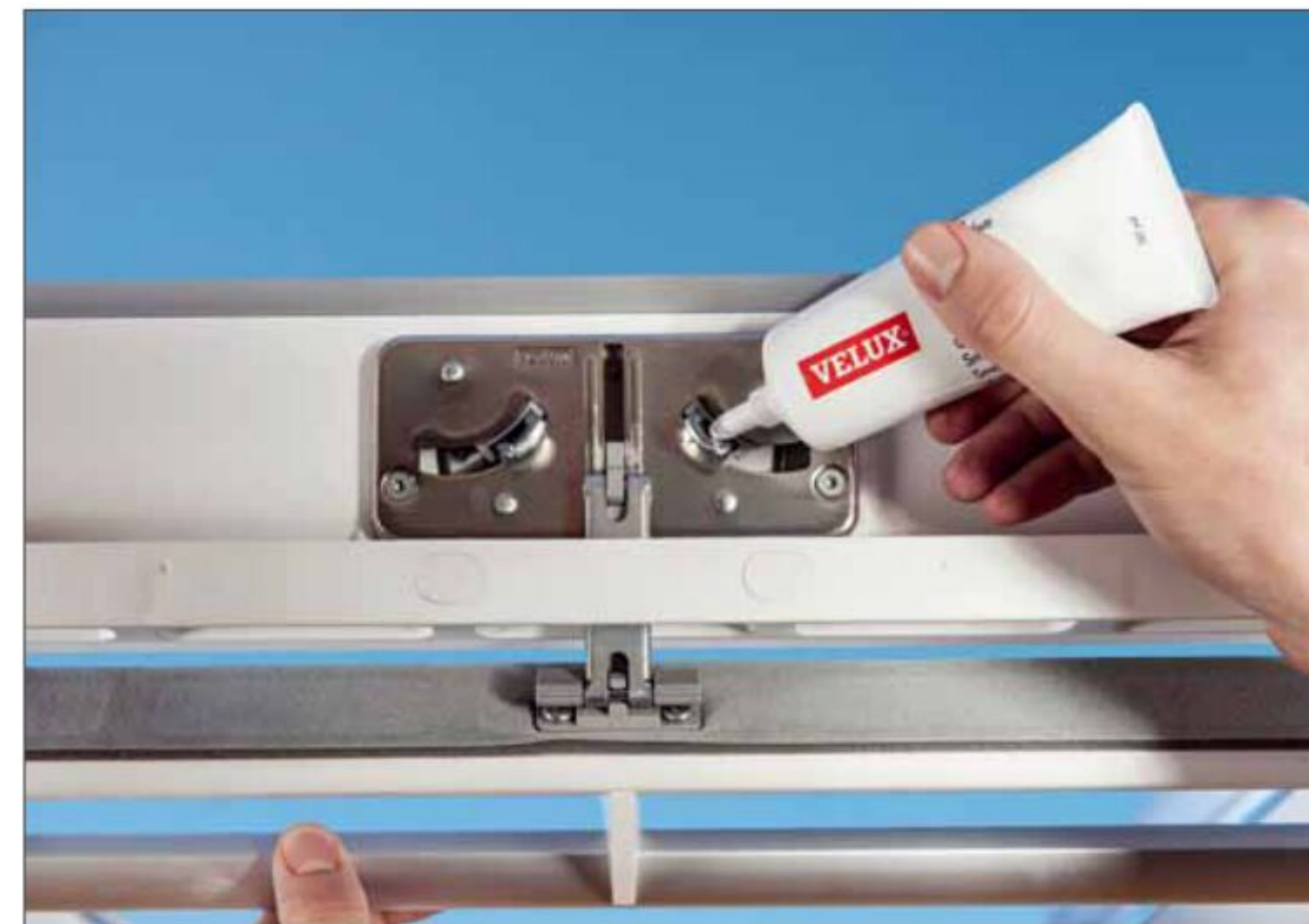
Die Pflege der beweglichen Beschlagsteile und Scharniere von Dachfenstern wird am geöffneten Fenster erledigt. Am Verschluss und dem Gegenstück am Rahmen sowie den Scharnieren wird dazu Scharnierfett aufgetragen (Foto: Velux Deutschland GmbH)
