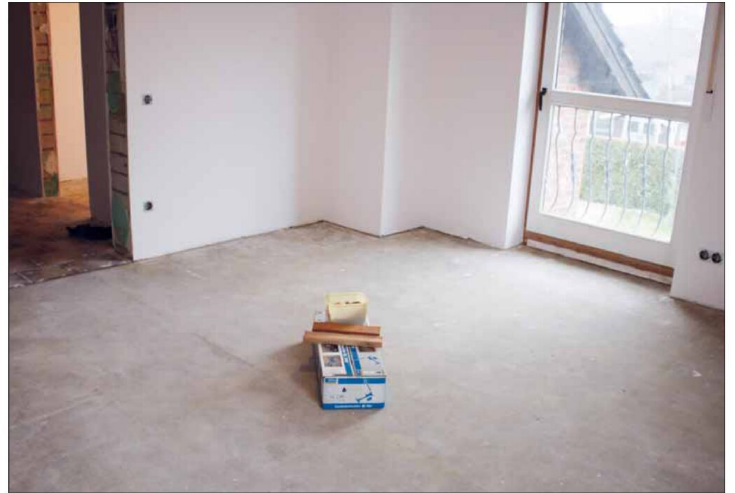
2 ... danach wird der Raum besichtigt, verschiedene bauliche Hindernisse wie Balkontüren, Zimmertüren und vorstehende Schornsteine müssen bei der Verlegung berücksichtigt werden.
