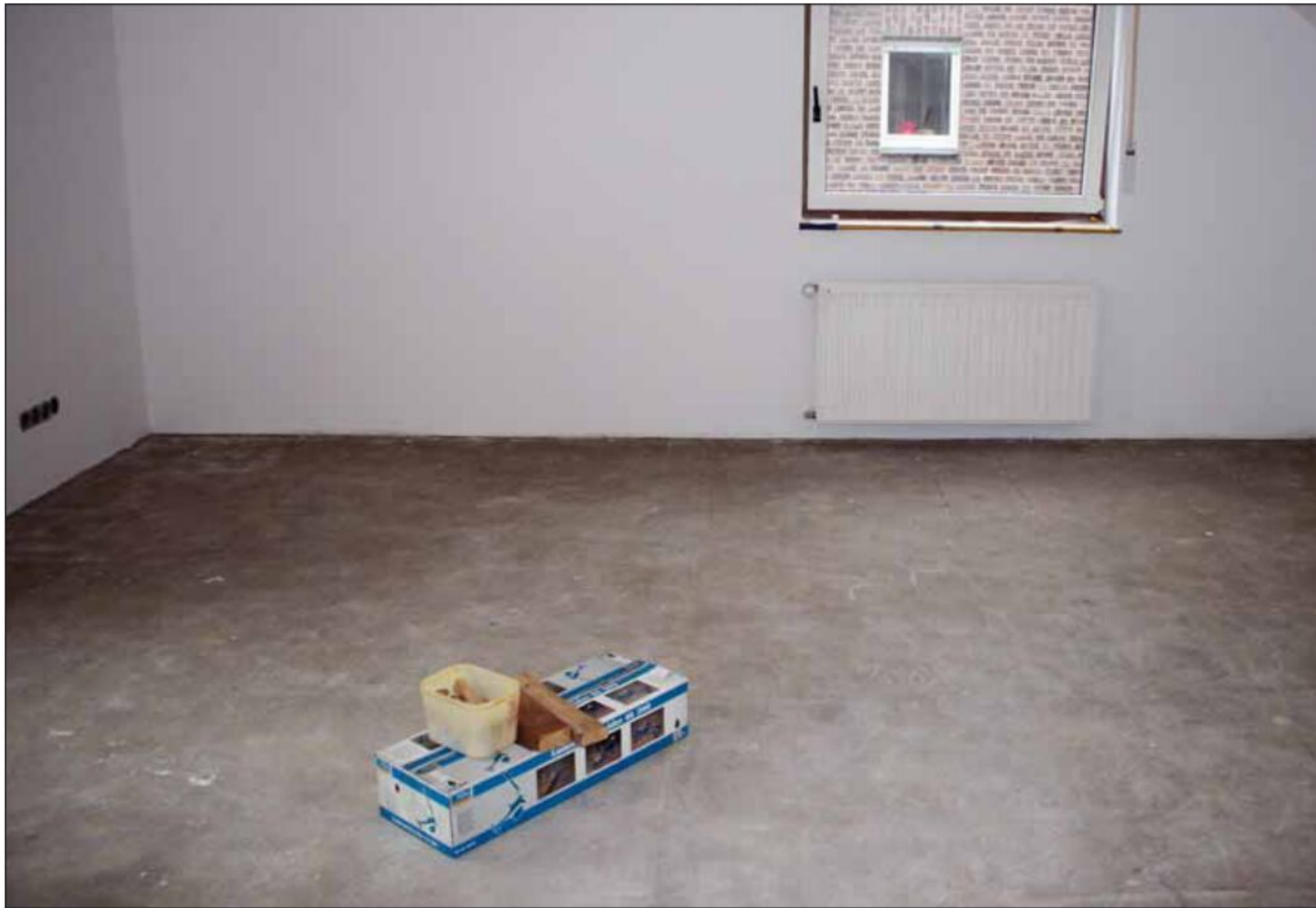
1 Die Vorbereitung ist einfach: Die Räume sind besenrein, ...
