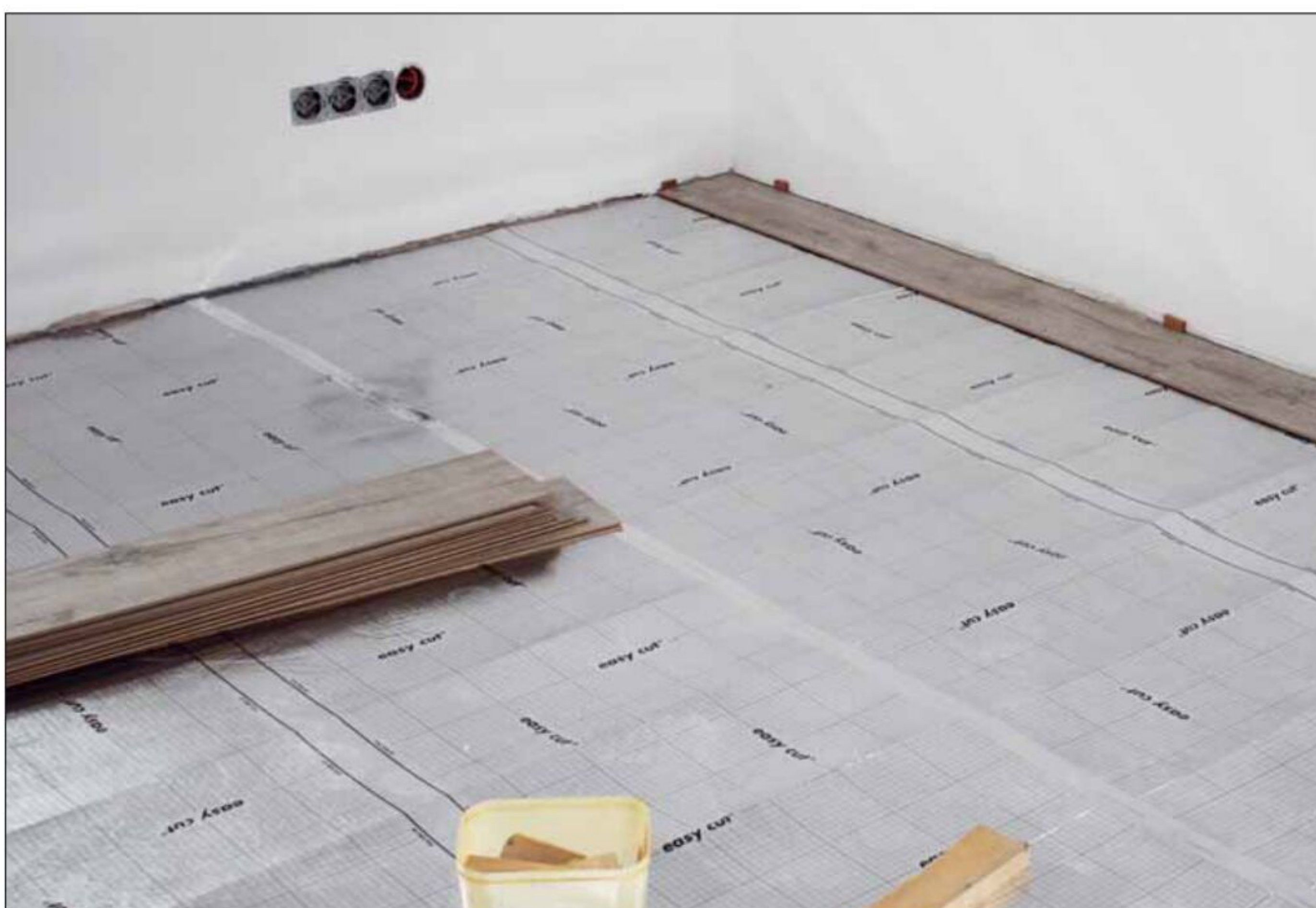
5 Jetzt kann die erste Reihe Laminat darauf verlegt und mit Abstandhaltern ausgerichtet werden. Hier wird von den Herstellern meist ein Wandabstand des Bodens von 5 bis 10 Millimetern empfohlen
