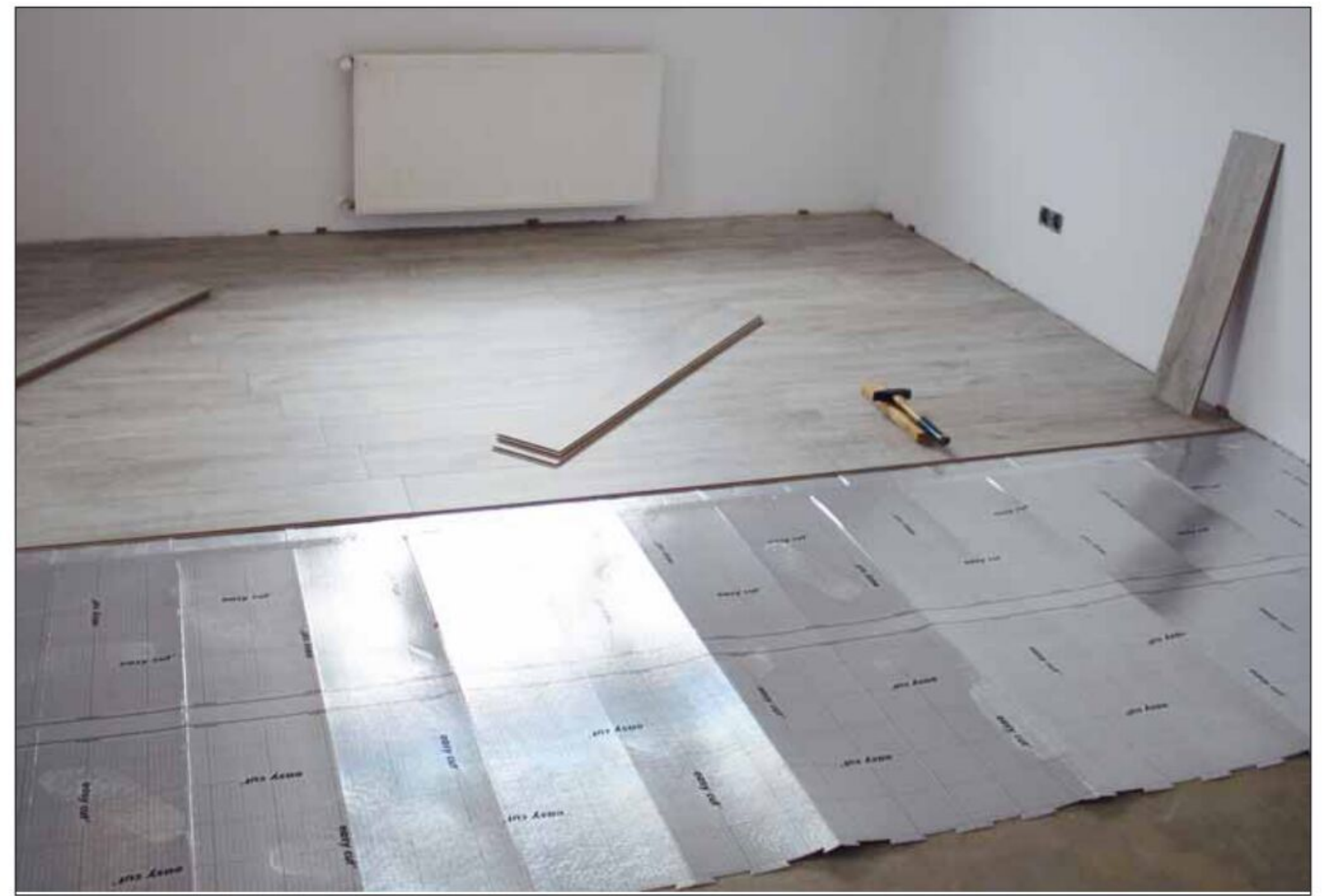
8 So folgt eine Reihe auf die andere, die Bahnen der Trittschalldämmung werden immer dann angelegt, wenn die Laminatkante herangekommen ist
