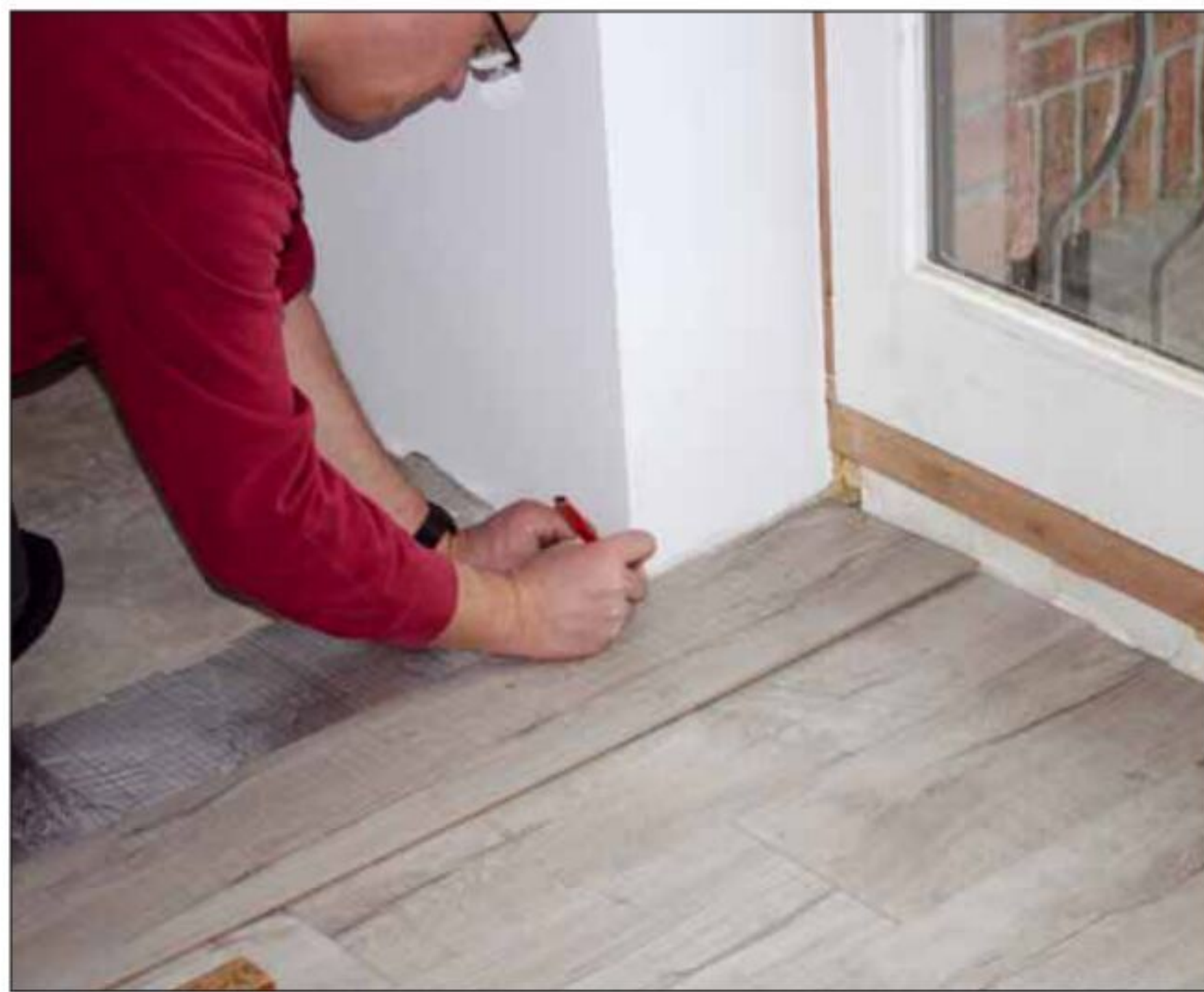
9 An Hindernissen wie Balkontüren und Kaminen werden die Paneele einzeln angepasst, sodass der Boden um die Hindernisse „herumfließt“
