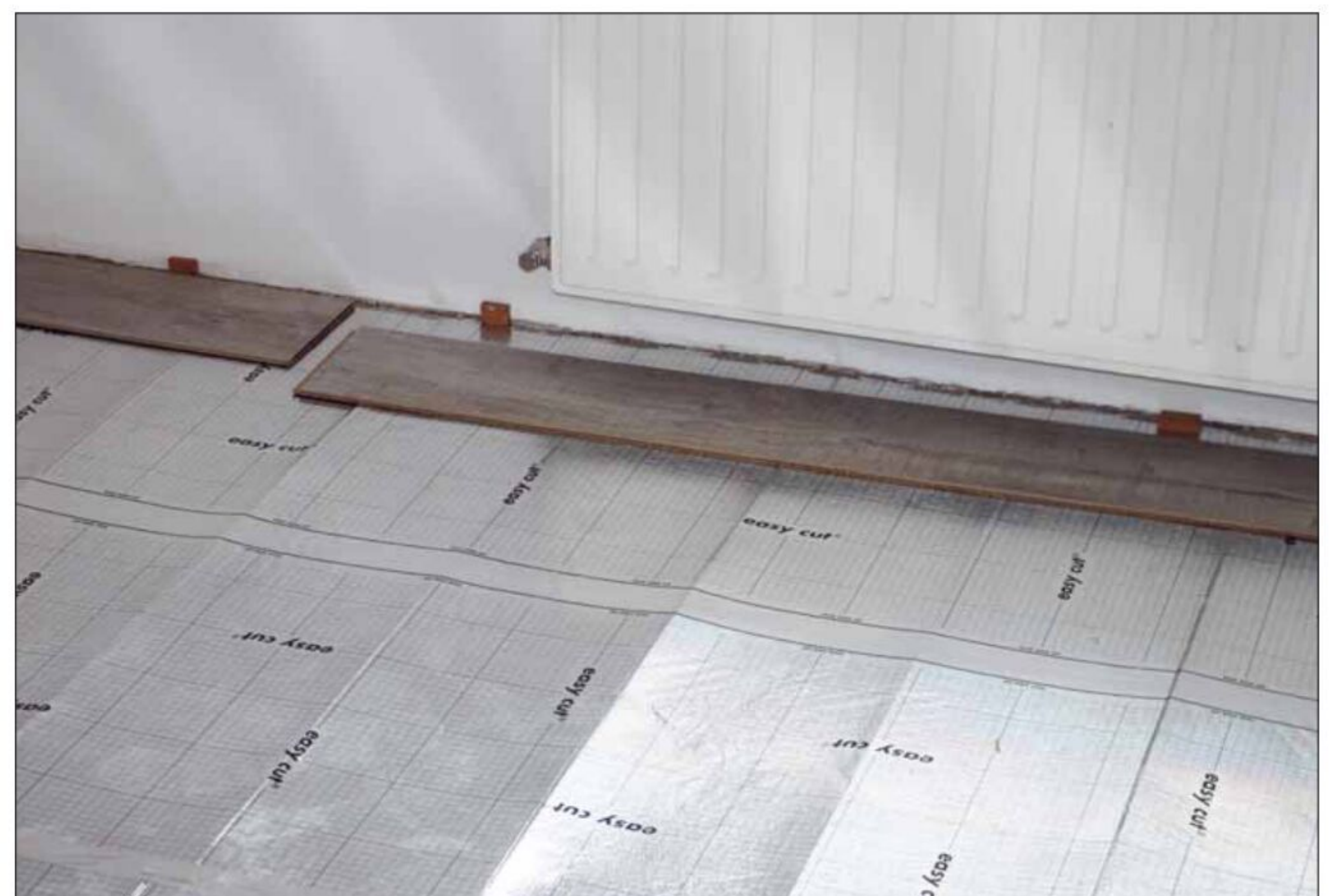
6 Die Verlegung und Ausrichtung der ersten Reihe nimmt am meisten Zeit in Anspruch
