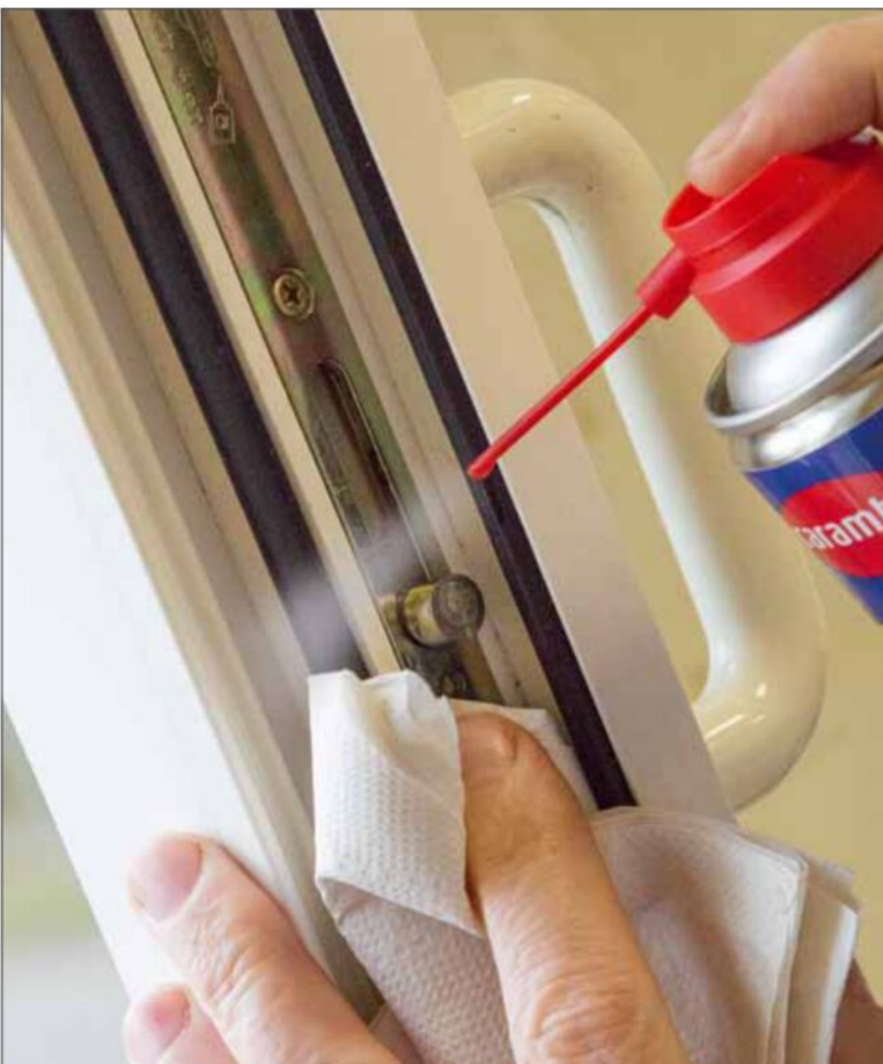
Beschläge an Fenstern und Türen freuen sich über einen Spritzer Öl. Wichtig ist, dass man ein Öl nimmt, das nicht verharzt
