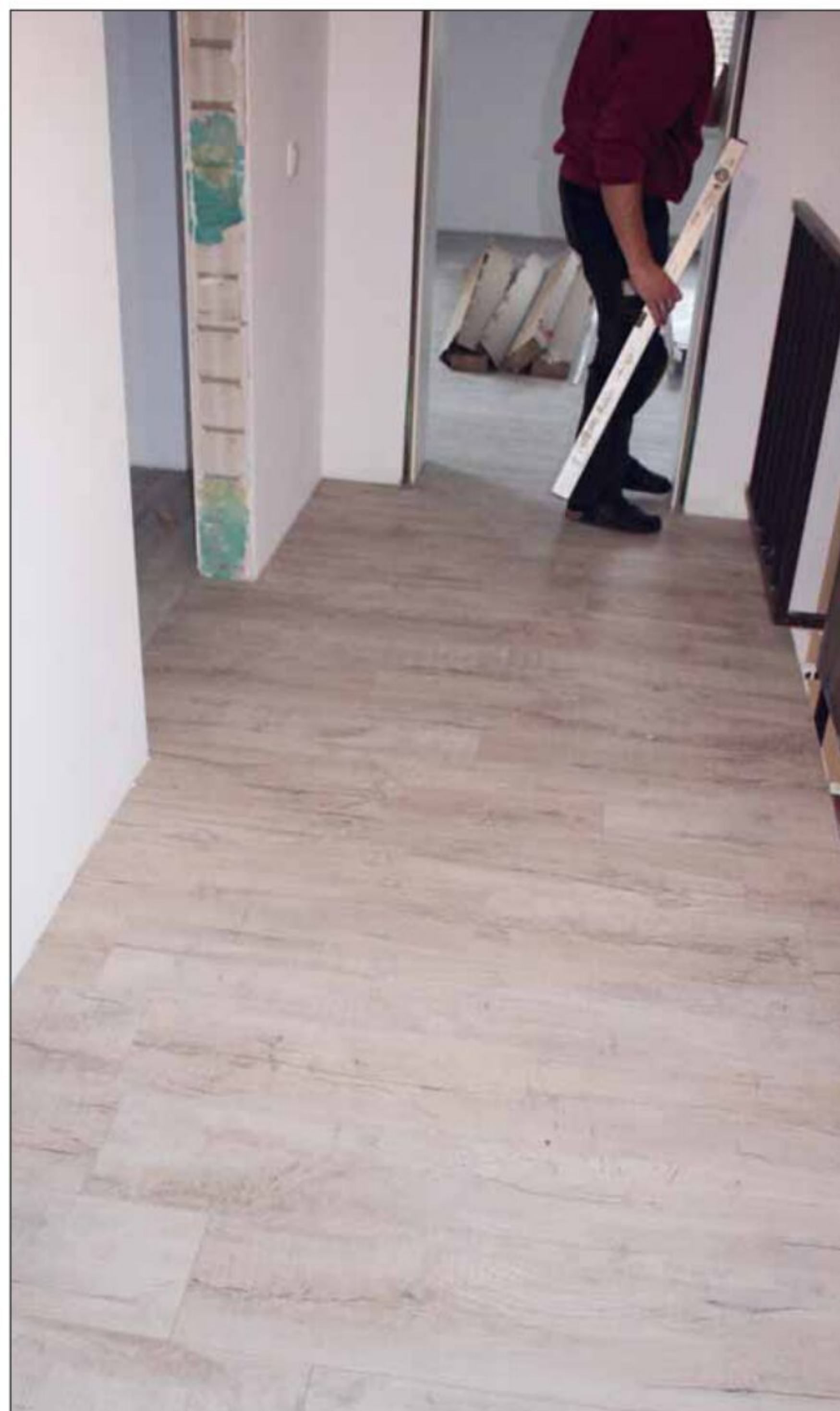
12 Eine ordentliche Überlappung der Paneele muss auch im schmalen Flur sichergestellt werden
