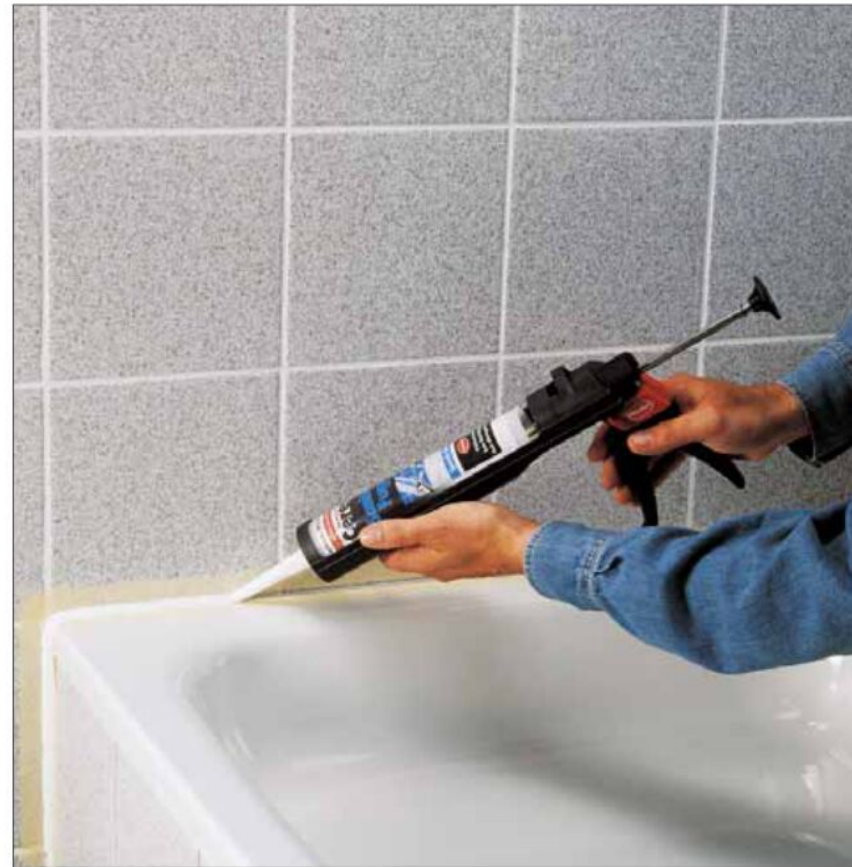
Klebt man beim Erneuern von Silikonfugen die umliegenden Fliesen mit Malerkrepp ab, kann man das neue Silikon zielgenau in die Fuge einbringen und die Fliesen bleiben sauber
