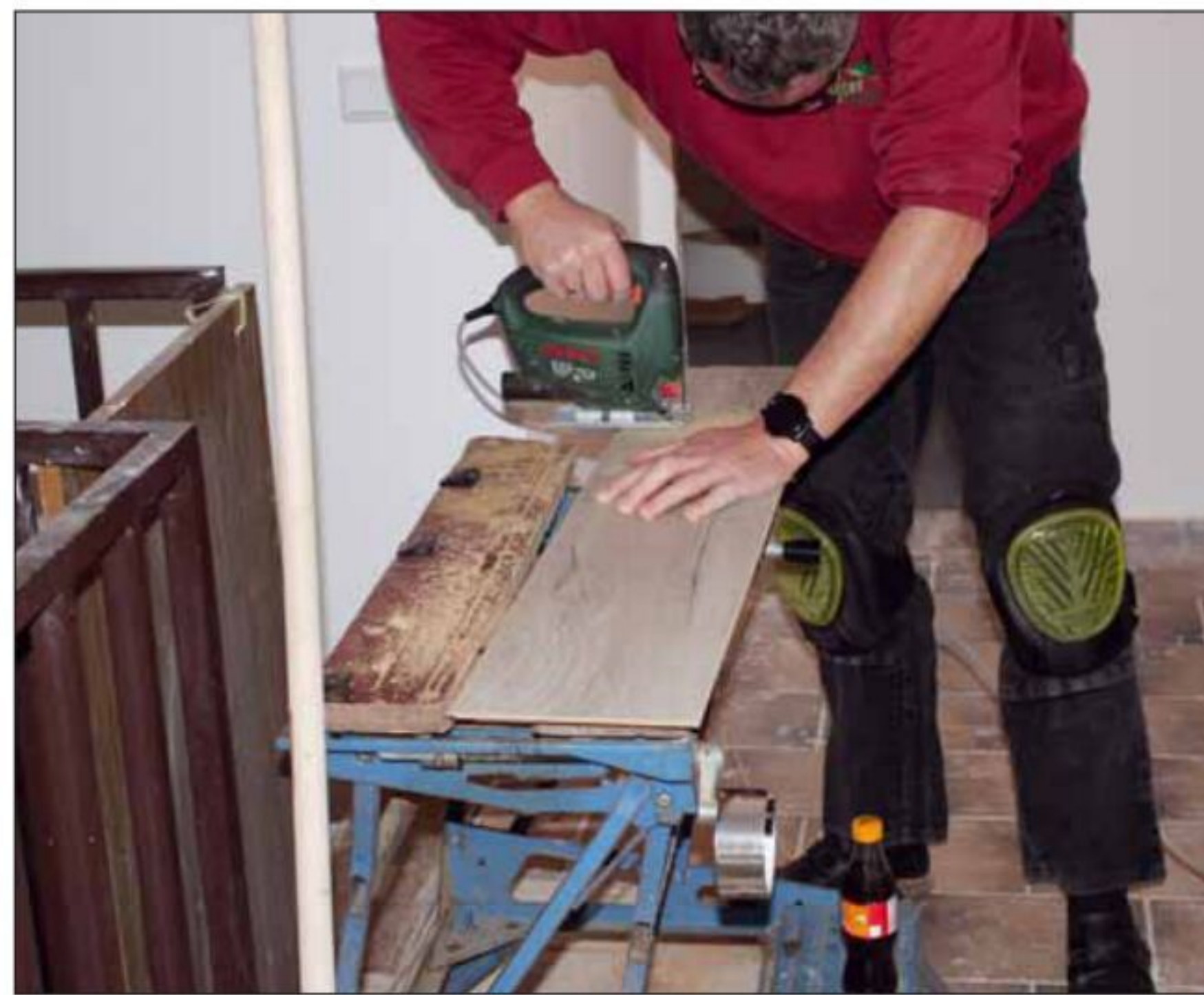
10 Eine mobile Werkbank leistet hierbei gute Dienste
