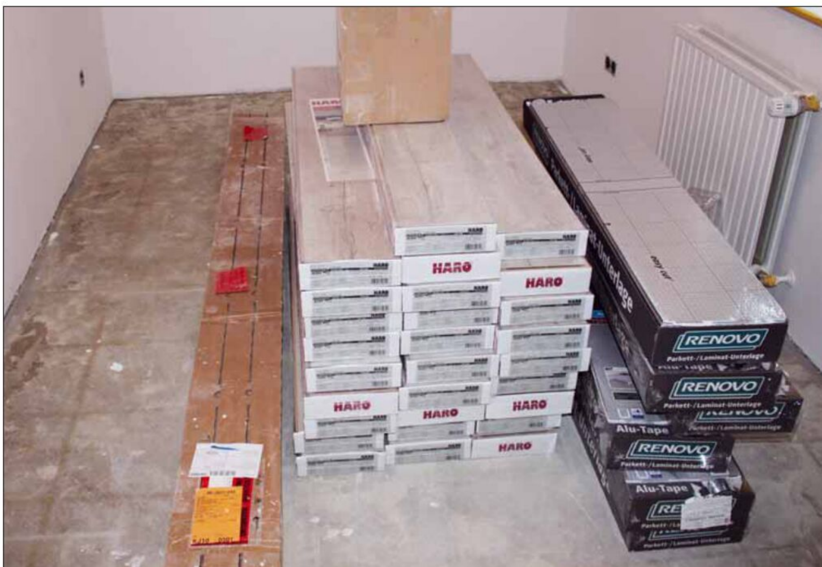
3 Anschließend wird das Laminat ca. 24 bis 48 Stunden zur Akklimatisierung in den Räumen gelagert
