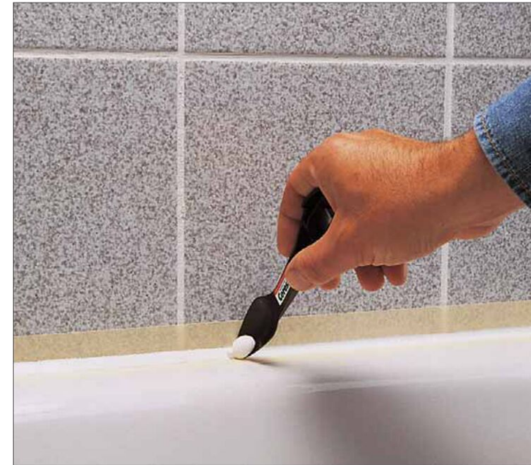
Um eine gleichmäßige Fuge zu erhalten, wird die Oberfläche mit einem Glätt-Cutter abgezogen
