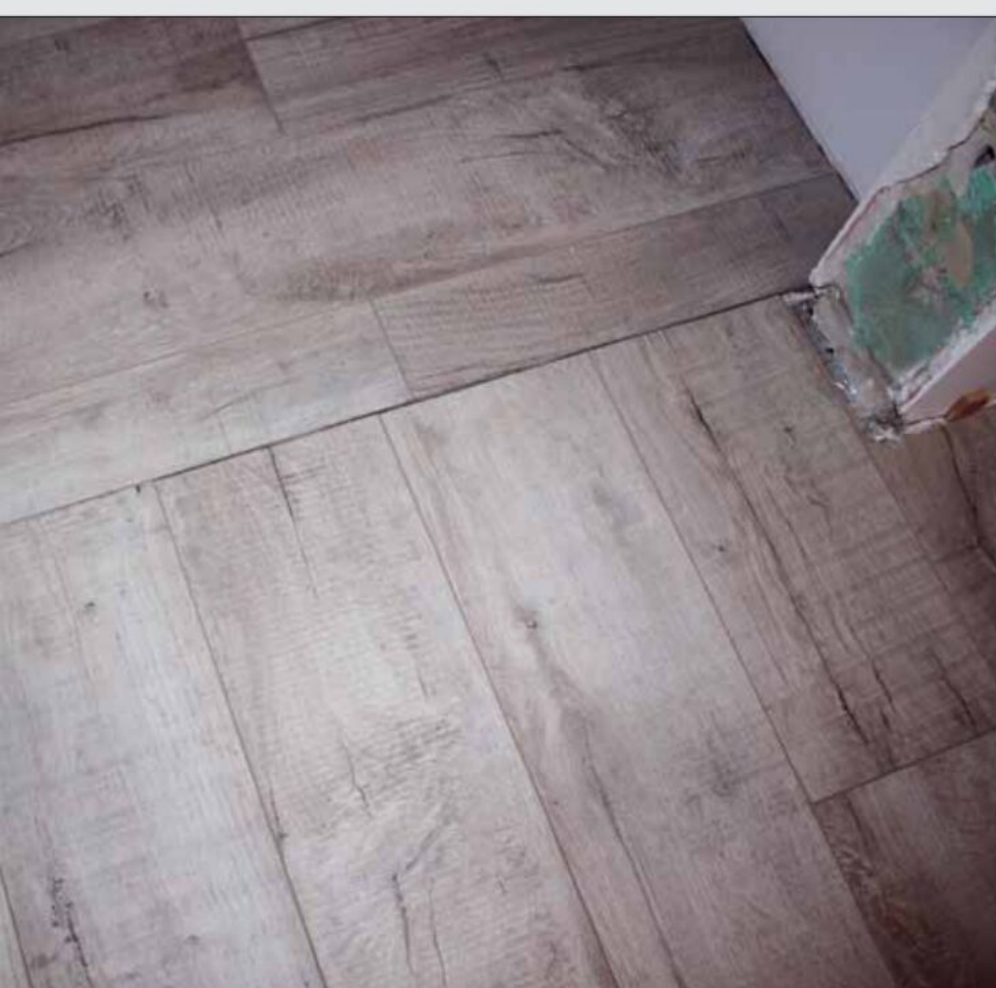
12 Eine ordentliche Überlappung der Paneele muss auch im schmalen Flur sichergestellt werden
