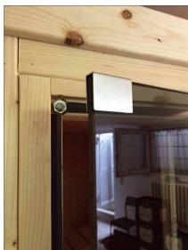
11 Die äußere Ecke oben erhält außerdem eine Edelstahlkappe aufgesetzt – das Gegenstück zum Magneten im Türrahmen. Damit und mittels der Gummidichtung im Rahmen schließt die Sauna perfekt, und doch kommt man jederzeit schnell heraus.
