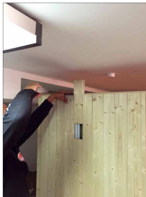
4 An der vorderen Wand weist eine Holzplatte eine Unterbrechung auf – hier wird die Steuerung eingepasst und der obere Teil mit der Handsäge passend gekürzt.
