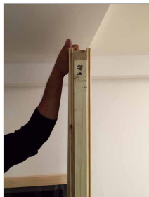
2 Als nächstes sind die Wände dran. Zwei Elemente sind es pro Seite – das ist gut, denn sonst bekäme man sie erst gar nicht durch die Tür. Ganz wichtig bei den Wänden ist, darauf zu achten, dass sie richtig herum aufgesetzt werden, denn sie haben im Inneren exakt da eine Verstärkung, wo die Liegetränke nachher angebracht werden. Die einzelnen Teile sind entsprechend gekennzeichnet, damit nichts schief läuft.
