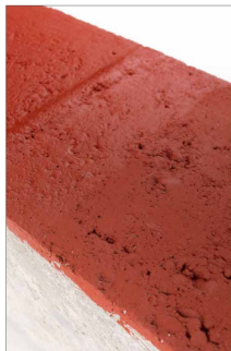
Einmal übergestrichen und schon wird aus einem Betonstein, zu sehen an der Vorderfront, ein Feldbrandstein. Wie man sieht ist schon der erste Anstrich deckend. Der zweite Anstrich sorgt dann für eine seidenmatte Oberfläche
