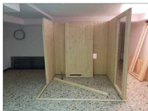
3 In der rechten hinteren Wand ist eine verschließbare Öffnung vorgesehen, die der Lüftung dient.
