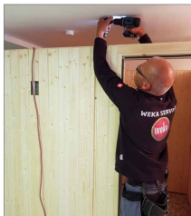
9 Der Einsatz eines herkömmlichen Akkuschraubers im 1. ist da nicht möglich. Gut, wenn man einen Winkelbohrvorsatz hat.
