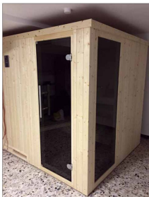
12 Der Holzbau ist fertig. Fehlt noch der elektrische Anschluss.
