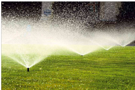
Auch das Sprengen des Rasens kann mit einer entsprechend installierten Bewässerungsanlage smart gesteuert werden
