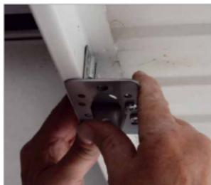
Das Lager für die Zugstange an der Toroberkante haben wir mit zwei Winkeln auf der Rückseite zusätzlich verstärkt
