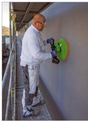
Die neue Akku-Putzbearbeitungsmaschine EPG 400 A von Eibenstock ist eine vielseitige und handliche Hilfe insbesondere zum zeit- und kräftesparenden Rabotieren sowie Abflizen von Putzflächen und Schleifen von Wärmedämmplatten. Durch das flächendeckende Schleifen wird besonders auf Gerüsten eine höhere Bewegungsfreiheit gewährleistet. In der Maschine kommen 18-Volt-Lithium-Ionen-Akkus mit einer Kapazität von 5,2 Ah zum Einsatz, welche zum Cordless Alliance System (CAS) gehören
