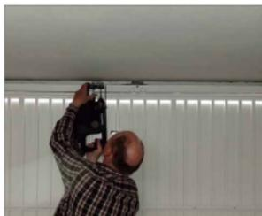
Bei Fertiggaragen bitte immer mit Tiefenschlag bohren, denn Wände und Decke sind nur zwischen 6 und 8 cm stark
