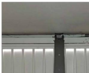
Die Laufschiene wird im vorderen Lagerbock mit einem Bolzen gesichert
