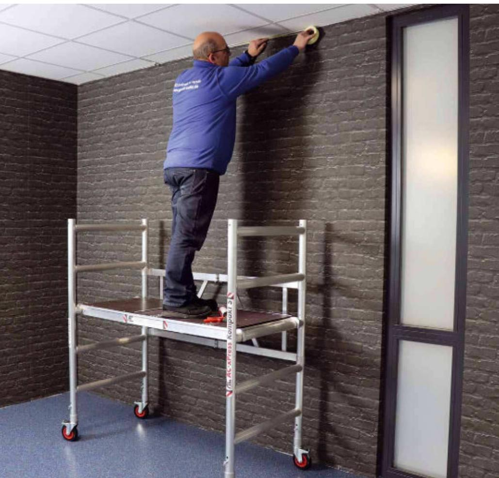
Statt immer die Leiter hoch- und wieder runterzusteigen, bietet ein Gerüst hier deutlich mehr Komfort und Sicherheit bei der Arbeit. Gerade bei Arbeiten an der Decke, also überkopf ist ein sicherer Stand in Kombination mit einer gewissen Beweglichkeit unverzichtbar.
