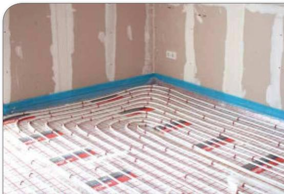
*Dank des geringen Wärmedurchlasswiderstands der SELITBLOC 1,5 mm GripTec kann die Fußbodenheizung optimal wirken*
