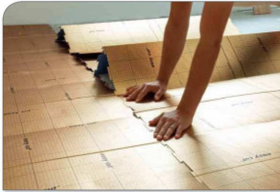
*Dank der Klickverbindung kann die SELITBLOC 1,5 mm GripTec schnell und sicher verlegt werden*
