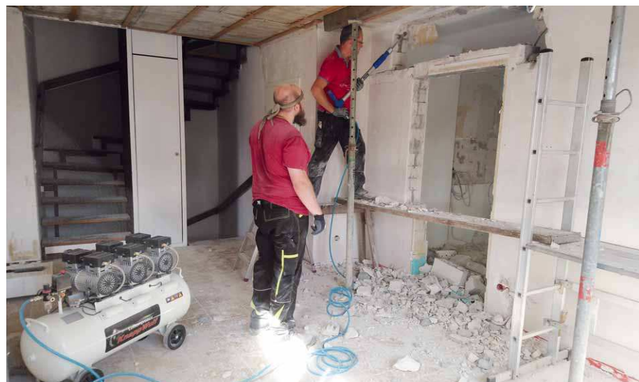
Auch beim Umbauen und Renovieren leisten Druckluftwerkzeuge gute Dienste
