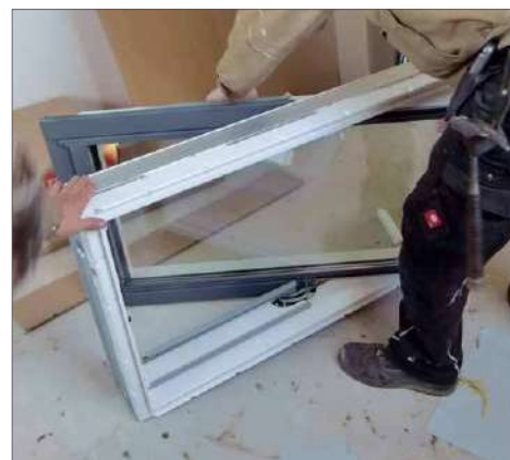
10 Das Fenster wird ausgeschwenkt und entnommen, ...
