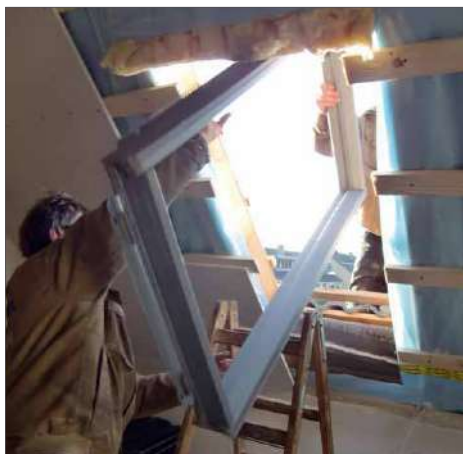
7 Der vorbereitete Einbaurahmen wird nach draußen gereicht ...
