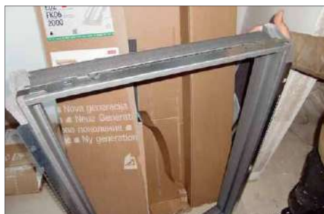
4 Währenddessen kann der Einbaurahmen des Fensters vormontiert werden
