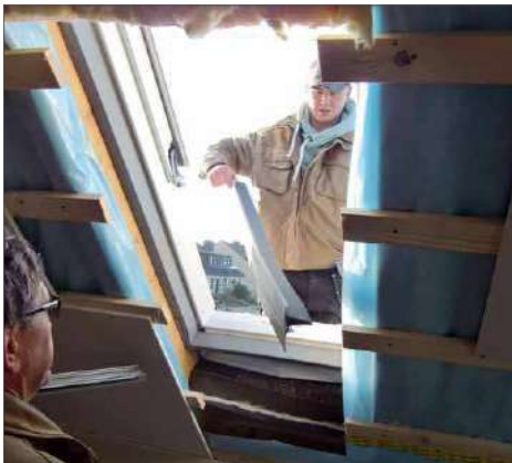
14 Zum Schluss kommen noch Abschlussleisten und Blenden zum Einsatz, ...
