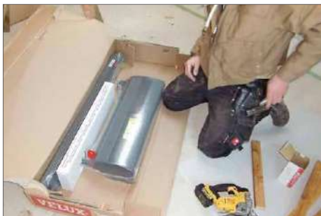
18 Nun kann der Sonnenschutz aufgebaut und vormontiert werden
