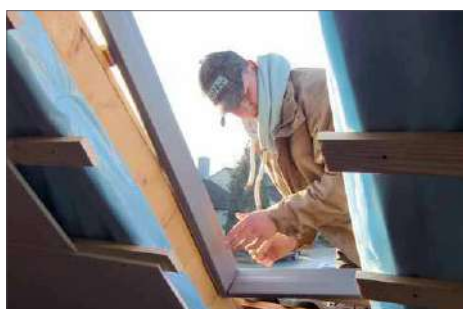
8 ... und von da aus eingebaut
