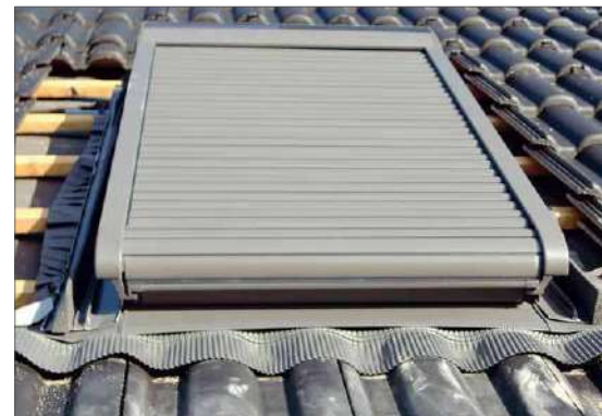
23 ... jetzt kann das Rollo gefahren werden. Der Einbau des Fensters hat mit zwei Leuten knapp einen halben Tag gedauert
