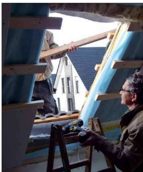
6 Von außen werden anschließend die restlichen Dachpfannen abgeräumt und das Einsetzen des Einbaurahmens wird vorbereitet
