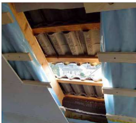
5 Dann erfolgt der Durchbruch ins Freie
