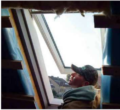
17 Noch ein paar Funktionsproben und das Fenster sitzt
