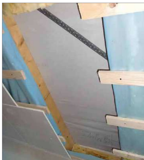
3 ... anschließend wird die Stützverlattung der Isolierung herausgesägt
