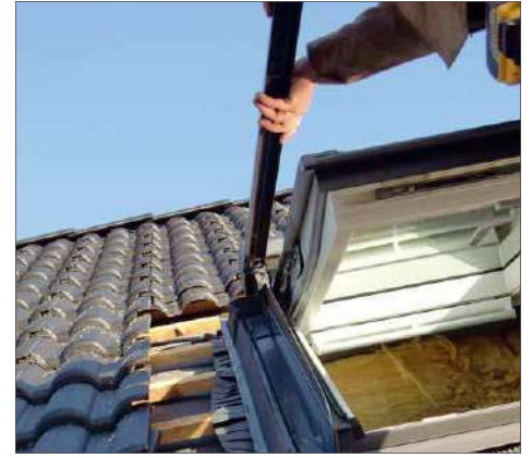
21 Zum Schluss werden noch die Abdeckungen des Antriebs aufgesetzt
