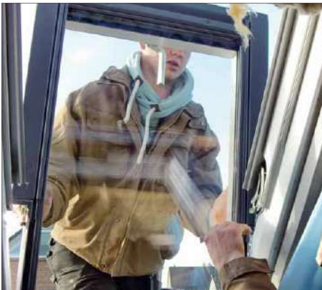
15 ... dann kann das Fenster eingehängt werden
