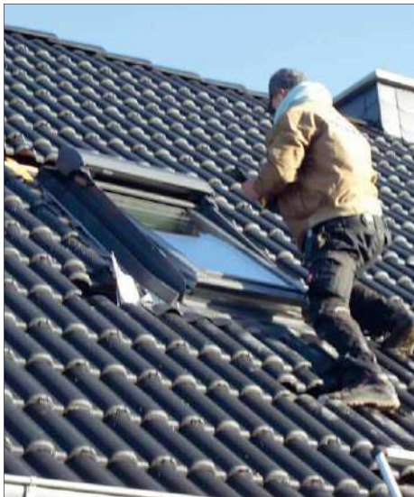
19 Ab jetzt erfolgen alle Arbeiten vom Dach aus. Der Sonnenschutz wird einfach auf den Fensterrahmen aufgesetzt und verschraubt
