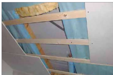
2 Zuerst werden von innen der Gipskarton und die Isolierung an der gewünschten Einbaustelle entfernt, ...
