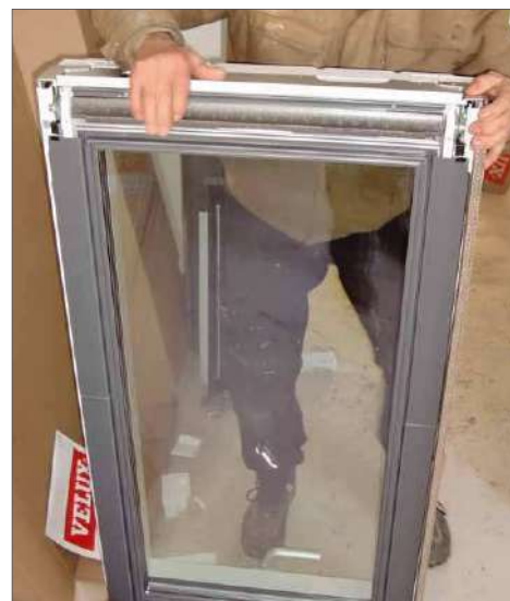
9 Danach kann das eigentliche Fenster ausgepackt und für den Einbau vorbereitet werden
