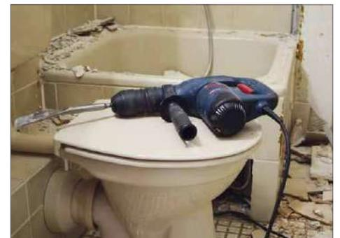
3 Mit einem guten Bohr- und Meißelhammer wird das Entfernen der Fliesen deutlich vereinfacht
