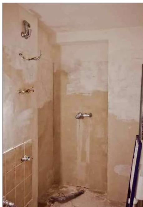
2 Mit einem Haftputz wird die Wand anschließend geglättet und so die Neuverkleidung mit Fliesen vorbereitet
