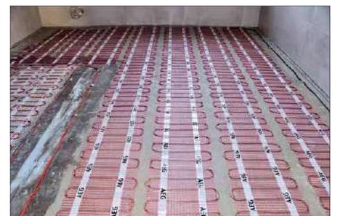
4 Vor der Verlegung des neuen Bodens wird die Fußbodenheizung durch einen Fachbetrieb montiert
