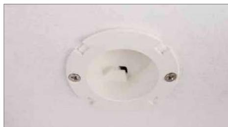
Um Rauchwarnmelder oder CO-Alarm von Cavius versenkt einzubauen, muss man in die abgehängte Decke ein Loch mit 50 mm Durchmesser sägen, in das der Einbau-Montagesockel eingesetzt wird
