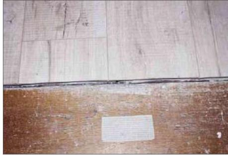
**16** Der Anschluss an die Kellertreppe erfolgt später mit einer Abschlussleiste aus Aluminium
