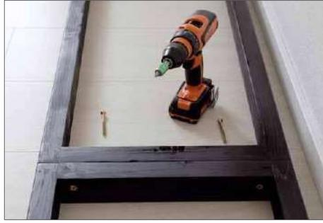
**4** Die beiden Sockelelemente werden vor Ort mit den „stumpfen“ Enden (denen ohne Gehrungs-Verbindung) zusammengeschraubt
