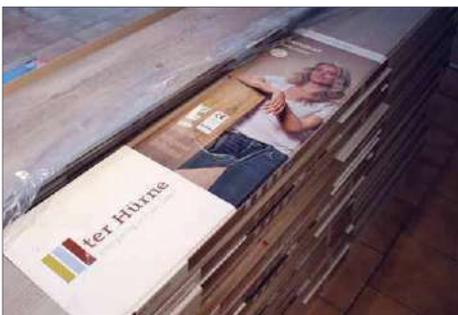
1 Als Erstes wird in dem besenreinen Raum das Laminat ca. 24 bis 48 Stunden zur Akklimatisierung gelagert
