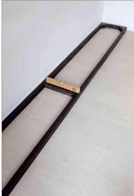
**5** Dann wird der Sockel schon mal gerade ausgerichtet und wo nötig unterlegt
