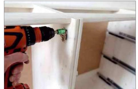
**8** Dann werden die Module miteinander verschraubt. Das geht ganz gut mit einfachen Spax-Schrauben. Auch nach unten mit dem Sockel werden die Module verschraubt
