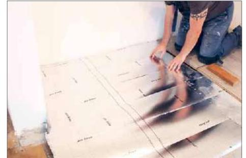
7 Bei „Hindernissen“, wie diesem Mauerstück, wird die Trittschalldämmung einfach ausgeschnitten
