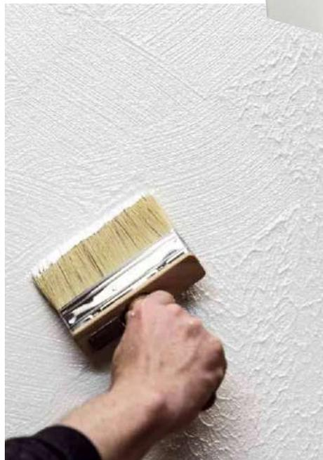
*Wenn die Struktur, die die Rolle beim Auftragen des Putzes hinterlässt, nicht gefällt, der kann kreativ werden. So lange der Putz feucht ist, kann man mit verschiedenen Hilfsmitteln eigene Strukturen erzeugen*
