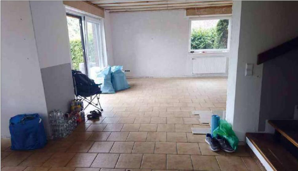
Hier soll im Rahmen der Grundrenovierung ein Laminatboden verlegt werden. Dabei bleibt der alte Fliesenboden unter dem Laminat erhalten
