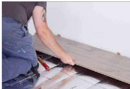
5 Anschließend kann die zweite Reihe angeschlossen werden, dabei sollte eine Überlappung der Kopffugen von rund 500 mm eingehalten werden, um dem Boden die nötige Stabilität zu geben
