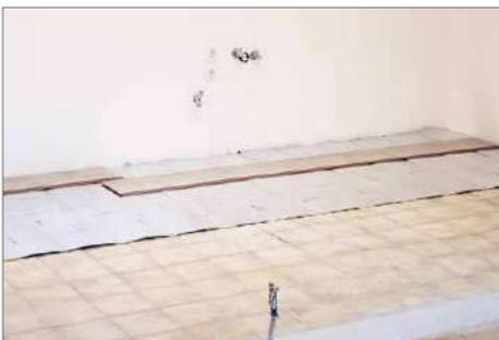
3 Zuerst wird die erste Reihe Trittschalldämmung verlegt, darauf wird die erste Laminatreihe gelegt und mit Abstandhaltern ausgerichtet. Hier wird von den Herstellern meist ein Wandabstand des Bodens von 5 bis 10 Millimetern empfohlen
