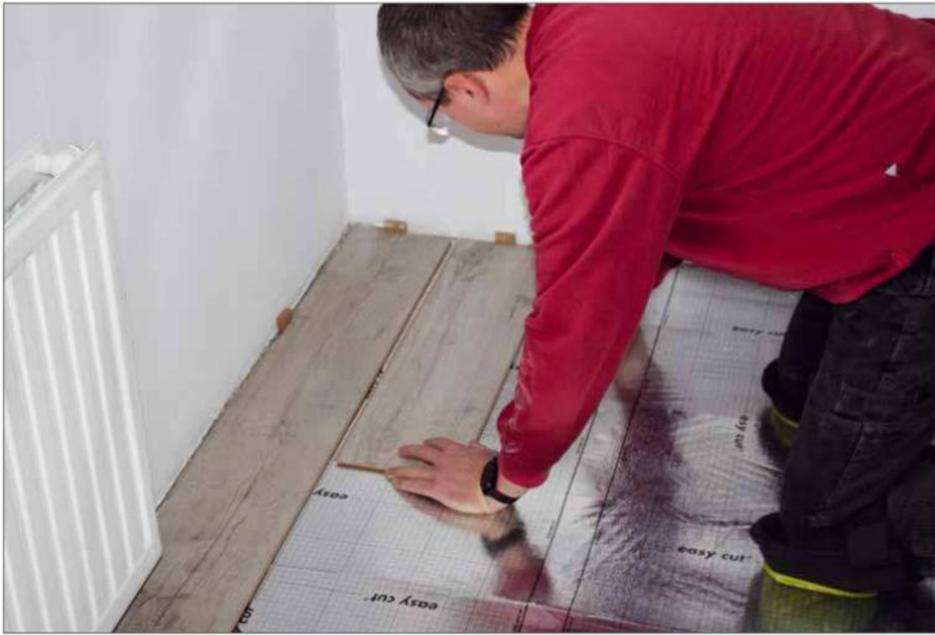
**8** Anschließend kann die zweite Reihe angeschlossen werden, dabei sollte eine Überlappung der Kopffugen von Rund 500 mm eingehalten werden, um dem Boden die nötige Stabilität zu geben
