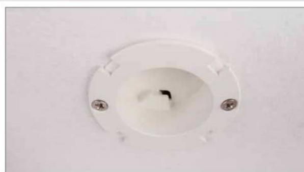
Um Rauchwarnmelder oder CO-Alarm von Cavius versenkt einzubauen, muss man in die abgehängte Decke ein Loch mit 50 mm Durchmesser sägen, in das der Einbau-Montagesockel eingesetzt wird
