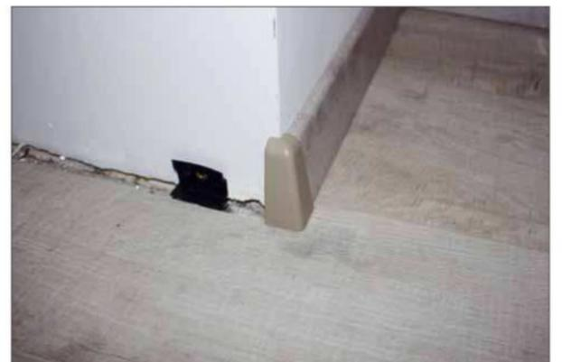
**15** Durch Eckstücke aus Kunststoff wird dem Heimwerker der Gehrungsschnitt erspart
