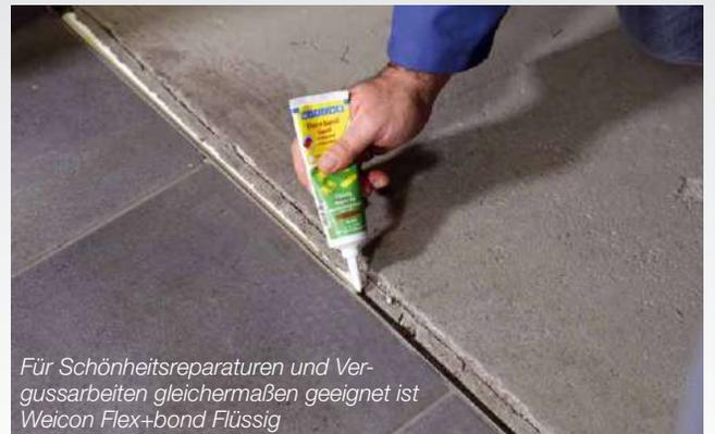
*Für Schönheitsreparaturen und Vergussarbeiten gleichermaßen geeignet ist Weicon Flex+bond Flüssig*
