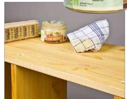
Das Wachs wird mit einem Ballen in kreisförmigen Bewegungen aufgetragen. Nachdem es einige Zeit getrocknet ist, wird es mit einer Polierbürste aufpoliert
