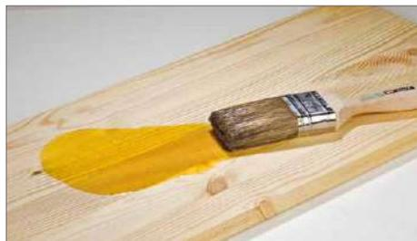
Das Öl wird mit dem Pinsel aufgetragen und zieht vollständig ein. Wenn nicht, wird der Überschuss nach etwa einer Stunde mit einem Lappen abgewischt
