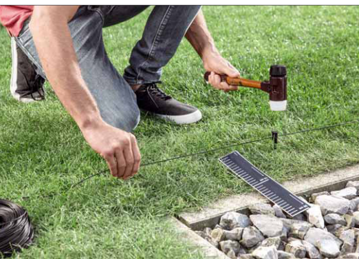
Bei der Verlegung des Begrenzungsdrahtes sollten die Randabstände von 20 cm eingehalten werden
