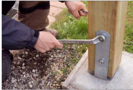
Damit Holz nicht mit dem feuchten Boden und darin wohnenden Schädlingen in Berührung kommt, setzt man Holzpfähle am besten auf Betonfundamente, auf denen sie mit Stahlshuhen befestigt werden
