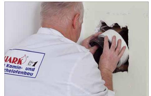
**7** Mit einem Abdichtband aus Glaskeramik wird das Wandfutter für das Rauchrohr in das Schamotterrohr des Schornsteins eingesetzt
