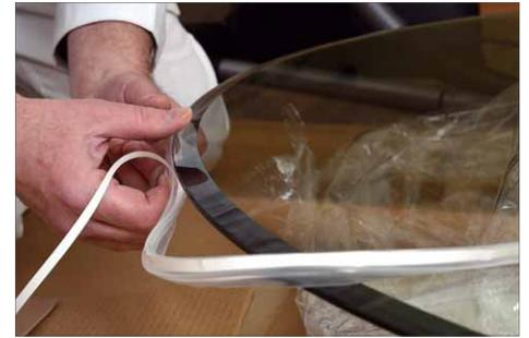
**5** Vor der Verlegung der feuerfesten Glas-Bodenplatte wird ein Silikonprofil an den Außenkanten aufgeklebt. Dies verhindert, dass Staub oder Putzwasser unter die Platte laufen
