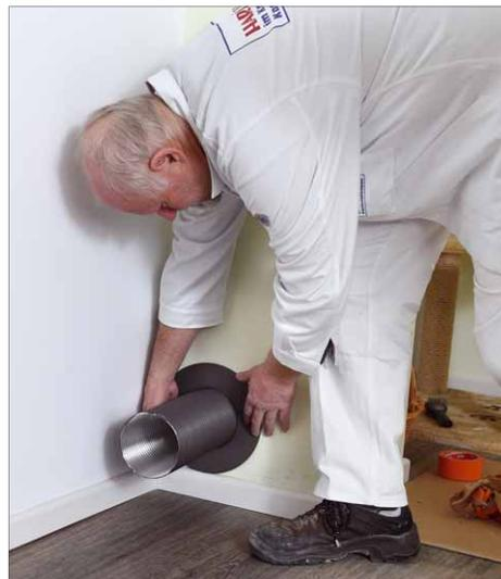
**4** Für die Verbrennungsluftversorgung des Ofens wird ein Aluminiumflexrohr in die ausgebohrte Öffnung eingesetzt und luftdicht ausgemörtelt
