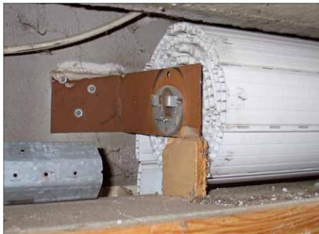
**1** Eine Bodenplatte musste um das Mittellager herum mit dem Cutter ausgeschnitten werden. Gut zu sehen ist, dass der vordere Wandanschluss uneben ist. Damit hier nicht kein Teil der Dämmwirkung verloren geht, ist Eigeninitiative gefragt
