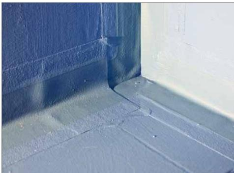
**12** ... und das Malerkrepp entfernt. Nun markiert der Fliesenkleber die genaue Position der Fliese.
