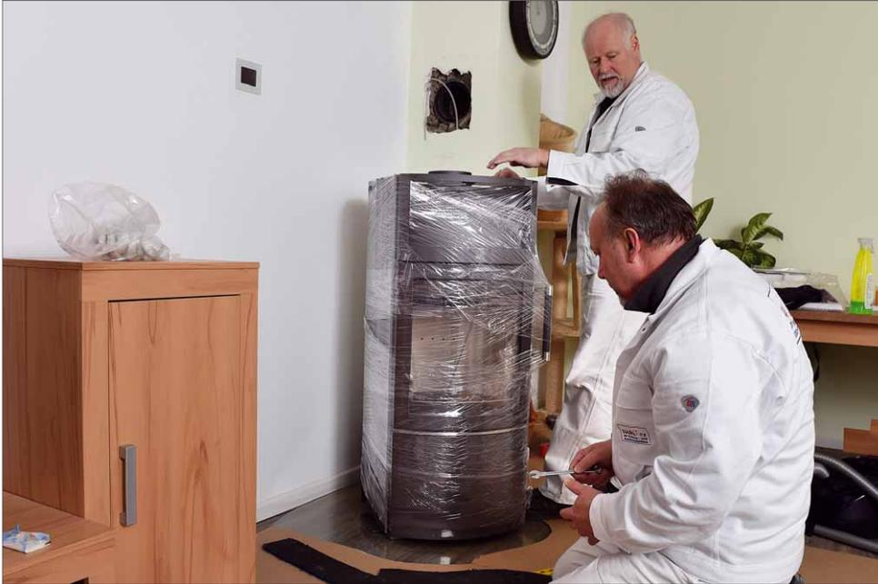
9 Der Kaminofen wird auf die Glasbodenplatte gesetzt und in die richtige Position gebracht
