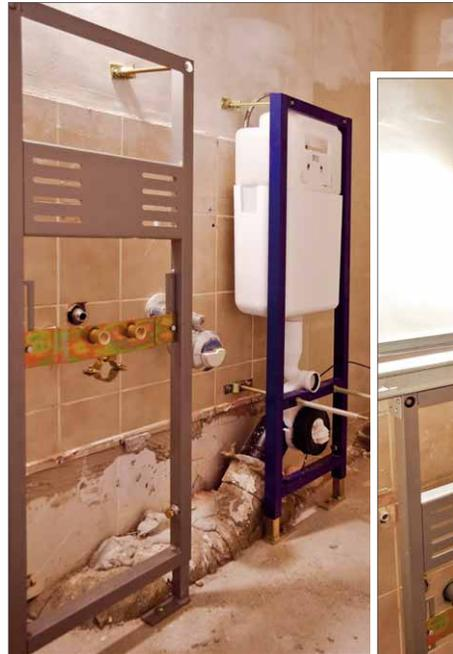
**3** Nachdem die Wände wieder glatt sind, werden die Vorwand-Installations-elemente für Toilette und Wasch-becken montiert. Hier sollte man sich genau an die Montageanleitung des Herstellers halten. Die von uns verwendeten, sehr soliden und erfreulich preiswerten Installationselemente haben wir bei Cornat gefunden.
