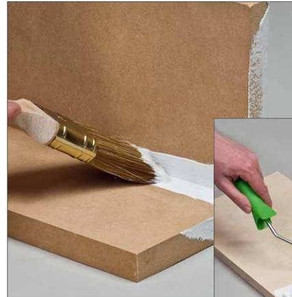
Mit dem Pinsel kommt man auch an enge Stellen und in Ecken. Dafür benötigt man Übung, um Flächen gleichmäßig und streifenfrei zu lackieren
