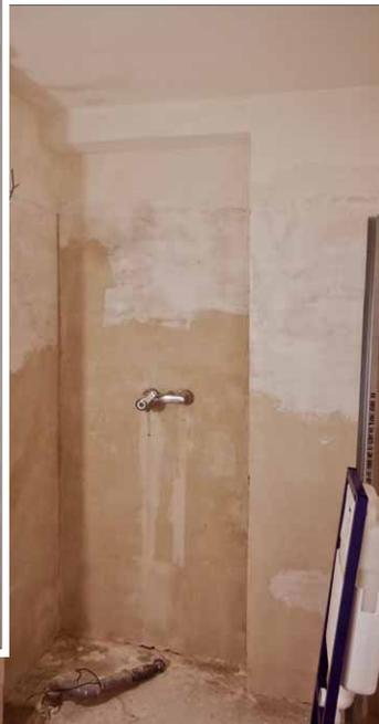
**2** So ganz ohne Kollateralschäden lassen sich Fliesen selten abschlagen. Mit Knauf Rotband Haftputzgips lassen sich die entstandenen Meißelspuren flächig glatt ziehen. Den Untergrund haben wir vorher mit Knauf Rotband Universal-grundierung grundiert.
