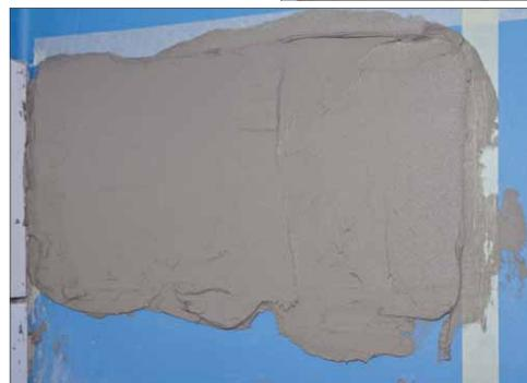
**11** Dann wird der Fliesenkleber mit dem Zahnspatel durchgekämmt ...
