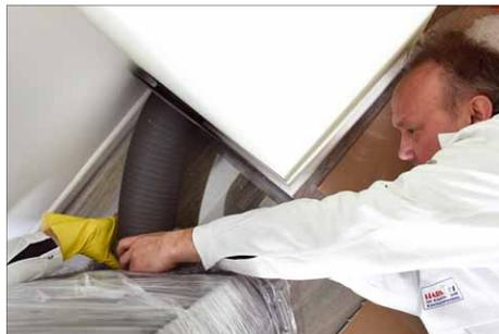
13 Auch das Aluflexrohr der externen Verbrennungsluftzufuhr wird mit dem Kaminofen verbunden
