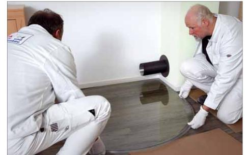
**6** Anschließend wird die Glasbodenplatte auf der Stellfläche verlegt
