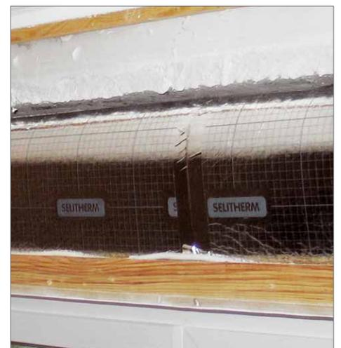
**4** Die Stöße der Platten werden mit dem beiliegenden Klebeband abgedichtet
