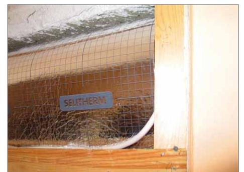
**5** Gurt und Kabeldurchführungen werden an den Seiten der Isolierung eingebaut und soweit möglich mit Dichtband wieder verschlossen
