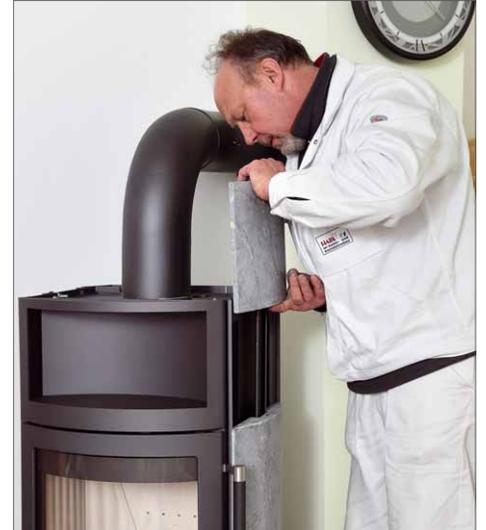
14 Zum Abschluss der Montage werden die Steine der Seitenverkleidung des Kaminofens eingeschoben ...
