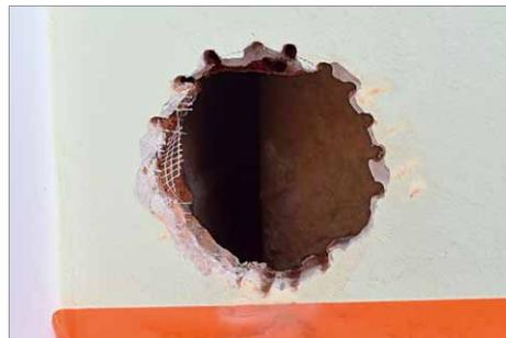
**3** ... und durch Perforation des Schornsteinsmantels ausgebohrt
