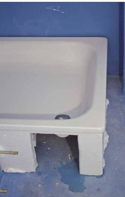
**8** Zum Aufstellen der Duschwanne gibt es spezielle Wannenträger. Wannenträger und Duschwanne werden mit PU-Schaum verklebt.
