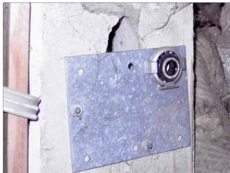
**1** Vor der Demontage sollte man den Mittelpunkt der Wellenlagerung an der Wand markieren. Das erspart bei der Montage des Motorlagers lästiges Messen. Das gegenüberliegende Lager wird durch das dem Set beiliegende Neuteil ersetzt.
