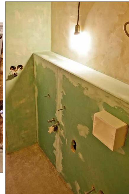
**6** Anschließend wird alles mit zwei Lagen Gipskartonplatten verkleidet (doppelt beplankt) und die Fugen mit Spachtel geglättet. Achtung! Auf jeden Fall auf die Durchbrüche für die Installationen achten! Genaue Schablonen liegen den einzelnen Produkten meist bei.
