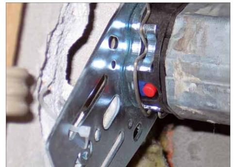
**4** Wir haben die Stromversorgung für den Motor vom Elektriker unter Putz legen und im Rollladenkasten eine Verteilerdose setzen lassen. Der alte Schacht des Rollladengurts wurde verschlossen. Mit dem roten Knopf am Motor lassen sich sowohl die Endanschläge feinjustieren als auch Funktaster oder Fernbedienungen an- und abmelden.
