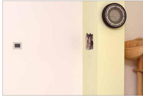
**1** Als Erstes wird der Durchbruch für den Anschluss des Rauchrohrs an den Schornstein gemacht
