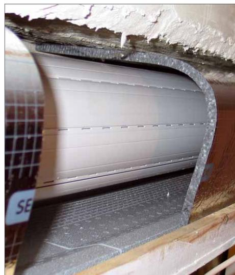
**3** Vorne schließt die Dämmplatte am Mauerwerk ab. In der Bodenplatte wird sie in die integrierte Nut gesteckt
