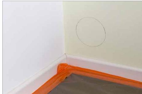
**2** Dann folgt der Anschluss für den Verbrennungsluftkanal. Die Position wird am Schornsteinschacht angezeichnet ...
