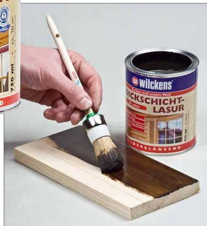
Fall empfiehlt sich ein spezieller Lasurpinsel für den Auftrag. Gestrichen wird dabei immer in Maserungsrichtung. Ergibt der erste Lasurauftrag noch nicht das gewünschte Ergebnis, kann nach einem Feinschliff ein zweiter Auftrag erfolgen.
