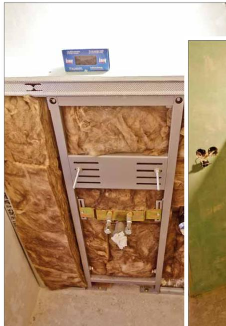
**5** Zur Schalldämmung werden die Hohlräume mit Dämmmaterial gefüllt.
