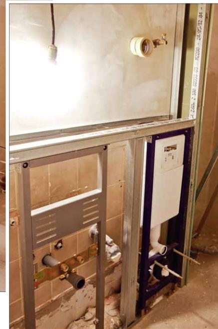
**4** Sind die Vorwandinstallations-elemente montiert und ausgerichtet, werden sie in das Ständerwerk aus Blechprofilen integriert. Für den kompletten Trockenbau haben wir auf Knauf Bauprodukte zurückgegriffen.
