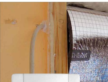
**6** Erst Strom rein, dann Strom wieder raus. Die neue Elektro-Installation bietet sich für eine Steckdose in Höhe des Rollladenkastens an. Hier lassen sich im Advent Lichterketten und leuchtende Fensterdekos anschließen. Beim Arbeiten am Rollladenkasten bietet es sich an, diesen gleich zu isolieren (siehe Seite 44).
