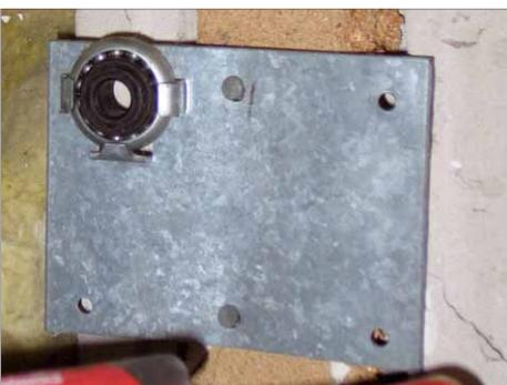
**7** Beim zweiten Motor war die Befestigung des Lagers wegen der Vertiefung im Stein etwas schwieriger. Gelöst wurde das Problem, indem die Holzunterlage erst im Stein verübelt und dann das Motorlager darauf befestigt wurde.
