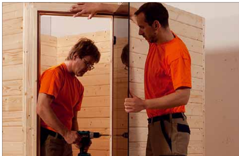
12 ... und danach der Türrahmen an der Frontwand montiert
