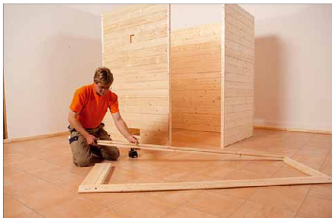
9 Die Frontwand wird für die Aufnahme des Türrahmens vorbereitet
