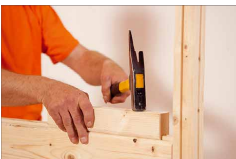
3 Dann werden für die Rückwände die weiteren Lagen Wandbohlen eingesetzt
