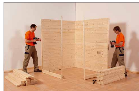
5 Alle Verschraubungen erfolgen über die mitgelieferten Eckpfosten
