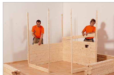
4 Die Wandbohlen werden dabei an den langen Seiten über die Gewindestangen gehoben
