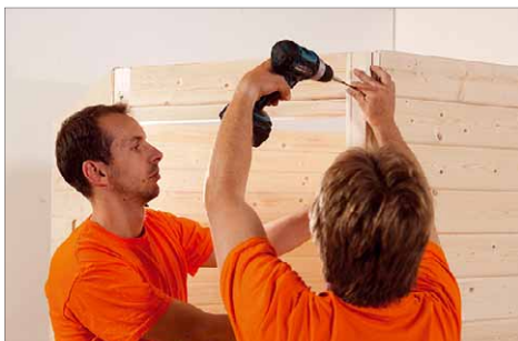
10 Anschließend werden die Seitenwände verschraubt
