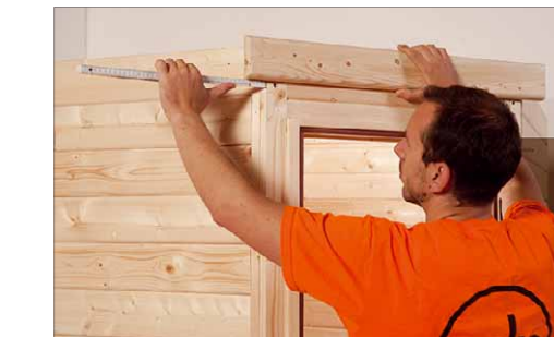
14 Die Position der Abschlussblenden muss ermittelt werden
