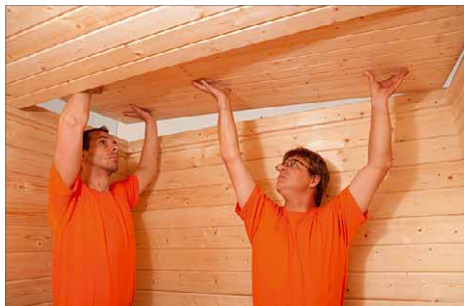
15 Um die Decke zu bauen, werden die Deckenelemente auf die vorab montierten Trageleisten gelegt
