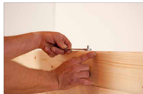
6 Die Gewindestangen werden mittels Unterlegscheiben und Muttern an den Wandbohlen befestigt
