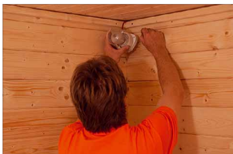
16 Fast fertig. Jetzt wird noch die Saunaleuchte an der inneren Saunawand befestigt ...
