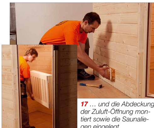
16 Fast fertig. Jetzt wird noch die Saunaleuchte an der inneren Saunawand befestigt ...
