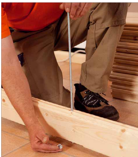
2 Gewindestangen dienen zur Fixierung der langen Saunawände
