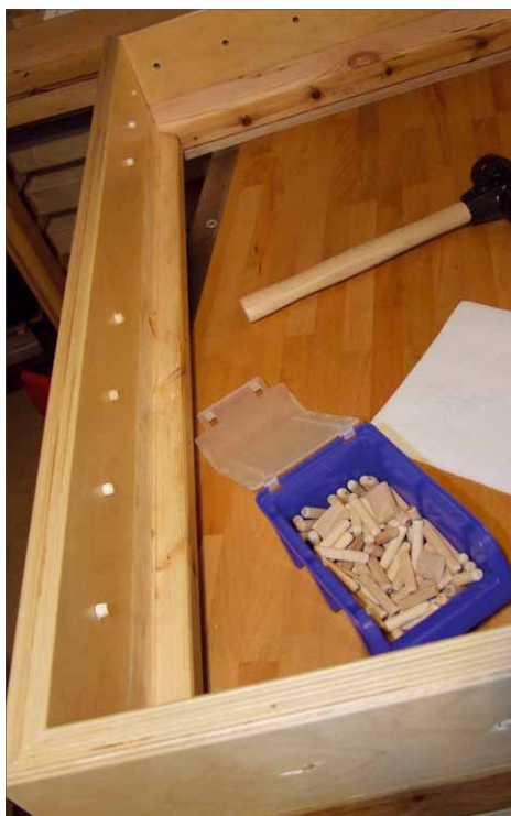
6 Nach dem Abbinden werden die alten Boh-rungen und Schraubenlöcher mit eingeklebten Holzdübeln verschlossen und nach dem Abbinden bündig abgesägt
