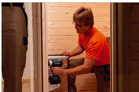
18 Zuletzt kommt die Technik: Befestigen Sie den Saunaofen über der Zuluft-Öffnung an der Seitenwand und schrauben Sie das Bedienteil von außen an der Frontwand fest
