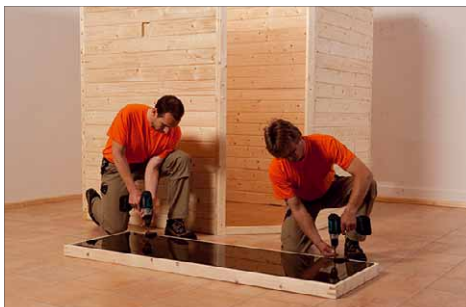
11 Die Glastür wird mit den Beschlägen am Rahmen befestigt ...
