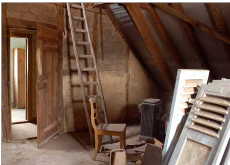
Auch auf dem Dachboden kann sich ein geeigneter Platz finden
