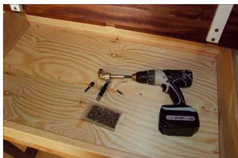
20 Jetzt kann der Boden eingesetzt und verschraubt werden
