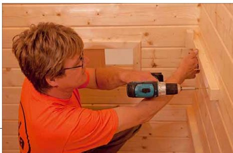
12 ... und danach der Türrahmen an der Frontwand montiert
