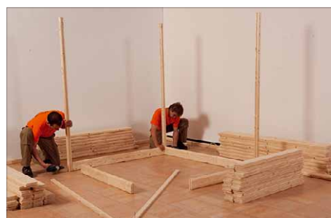
1 Als Erstes wird die erste Lage Blockbohlen mit allen Eckpfosten verschraubt
