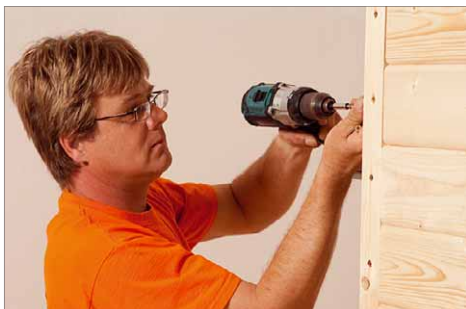
8 Dazu wird jede Blockbohle mit einer Schraube an den Pfosten geschraubt.
