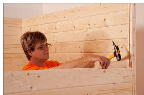
7 Dann werden Schritt für Schritt die Seitenwände montiert
