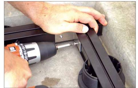
4 In den Ecken wird die Unterkonstruktion mit Winkeln verschraubt.
