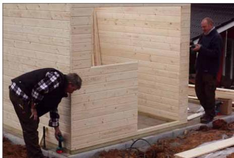
**5** Aufgrund der Konstruktion sind die Wandbohlen spiegelverkehrt austauschbar. So würde sich z. B. die Tür links und das Fenster rechts einbauen lassen. Dabei ist zu beachten, dass der Türanschlag immer rechts bleibt.
