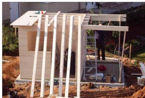
**7** Nach erfolgter Montage des seitlichen Anbaus wird die Dachschalung über das komplette Haus verlegt.
