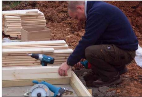
**2** Die Sockelbohlen werden mit den Bodenbalken verschraubt.
