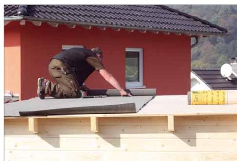
**8** Im Lieferumfang enthalten ist eine Dachpappe zur Ersteindeckung und als vorübergehender Schutz gegen Witterungseinflüsse, die mit speziellen Dachpappstiften auf die Dachschalung genagelt wird.
