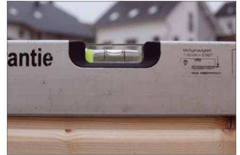
**4** Beim Aufbau eines Blockbohlenhauses ist immer wieder zu kontrollieren, dass die Wandbohlen waagrecht sitzen.
