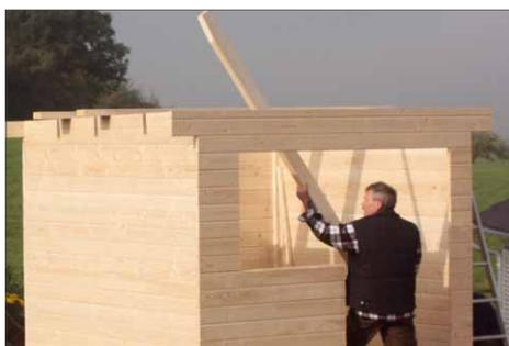
**6** Nach dem Aufsetzen der Giebel werden die Dachpfetten eingelegt und zur Stabilisierung des Daches über Sparren-Pfetten-Verbinder mit dem Haus verschraubt.
