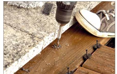
5 Weil die als Rahmen verlegten Außendielen über die Unterkonstruktion herausragen, können diese nicht verdeckt mit Klammern verschraubt werden. Hierfür liefert Trex Schrauben in Paneelfarbe für die Verschraubung von oben.
