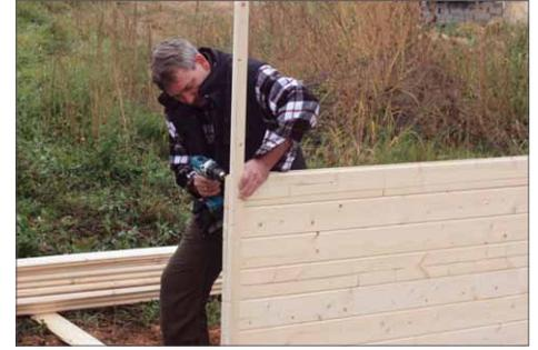
**3** Die Wandbohlen werden mit der Nut-und-Feder-Verbindung einfach ineinandergesteckt.
