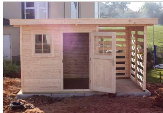
**10** Fenster und Tür lassen sich sowohl während der Wandmontage als auch im Nachhinein einsetzen. Entfernen Sie die Schutzfolie von den Scheiben erst, wenn das gesamte Haus ausreichend imprägniert und lasiert wurde.
