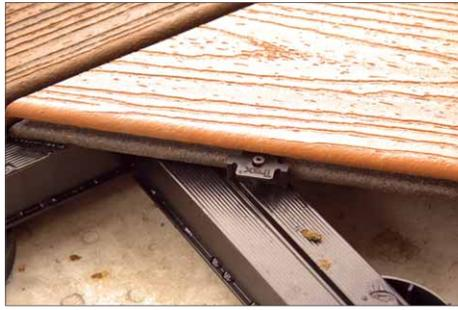
**8** In den Innenfeldern werden die Paneele unsichtbar mit Kunststoffklammern verschraubt. Neben der Befestigung dienen die Halter gleichzeitig dazu, den gleichmäßigen Paneelabstand zu gewährleisten.
