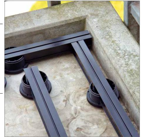
3 Bei der Planung der randnahen Unterkonstruktion sollte man die seitliche Ausladung der Füße berücksichtigen. Als Abstand für die Füße sowie für die einzelnen „Linien“ der Unterkonstruktion empfehlen sich ca. 400 mm. Dieser Abstand sorgt für ausreichende Belastbarkeit und verhindert gleichzeitig das Federn des Bodens, wenn man darüber läuft.
