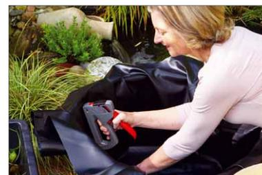
**Schritt 2** Folie an den Innenseiten hochstreichen und mit einem NOVUS Handtacker am inneren Rand befestigen. Folie straff spannen, damit sie nicht reißt.
