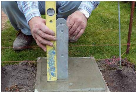
**2** Anschließend wird der Stahlschuh für die Holzbalken eingesetzt und der Beton glatt gestrichen. Dann wird der Schuh mit einer Wasserwaage ins Lot gebracht und zum Abbinden fixiert
