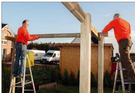
**7** ... und der erste und der letzte Querbalken aufgelegt. Anschließend wird mit einer Diagonalenmessung überprüft, ob die Konstruktion rechteckig ist
