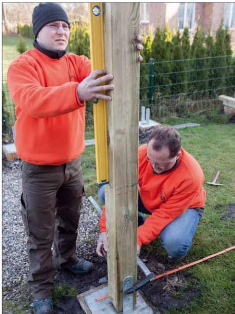
**3** Nachdem der Beton ausgehärtet ist, kann die Montage des Carportes beginnen. Dabei ist darauf zu achten, dass alle Balken absolut senkrecht stehen. Schraubzwingen leisten zur vorläufigen Fixierung gute Dienste
