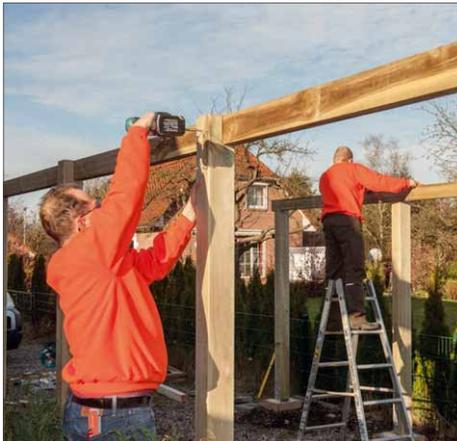
**5** Im nächsten Schritt werden die Längsträger aufgelegt, verbunden und im Anschluss mit den Balken verschraubt. Hierfür werden Schlossschrauben verwendet, die zum Lieferumfang gehören
