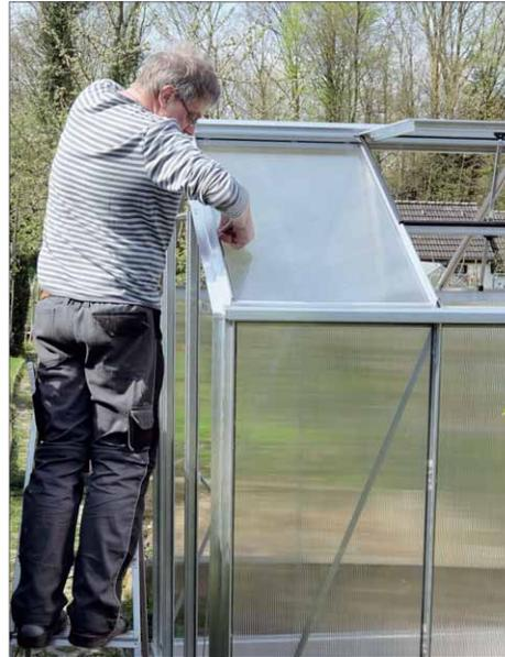
9 Zuletzt wird die Verglasung aus Doppelstegplatten eingesetzt, die Platten werden mithilfe spezieller Klammern in den Alu-Profilen fixiert. Zuletzt wird noch die zweiteilige Türe zusammengebaut und eingehängt.
