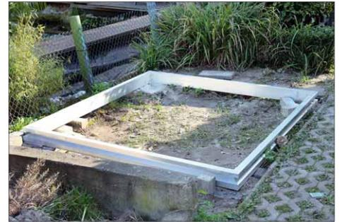
**1** Zuerst wird der als Fundament dienende Alu-Rahmen an den vier Eckpunkern einbetoniert. Beim Ausrichten hilft die Wasserwaage.
