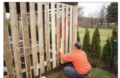
**11** Zuletzt werden Seiten- und Stirnwand montiert. Diese bestehen aus einzelnen Leisten, die zueinander versetzt montiert werden. Bei der Ausrichtung leistet eine Wasserwaage gute Dienste.
