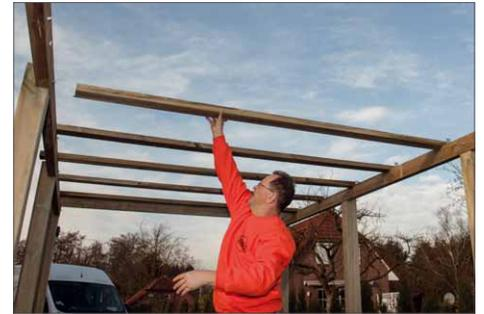
**8** Dann werden die restlichen Balken aufgelegt, ausgerichtet und verschraubt
