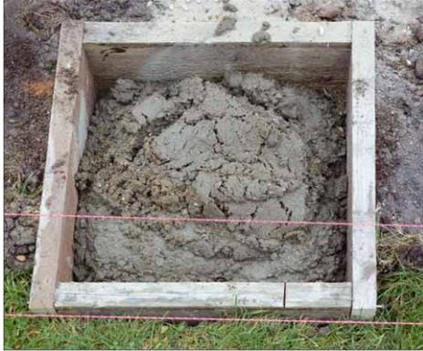
**1** Zur genauen Ausrichtung des Carports werden Leinen gespannt, an denen die Fundamente platziert werden. Zuerst wird das Loch ausgeschachtet, dann mit Brettern ausgekleidet und anschließend kann der Beton eingefüllt werden
