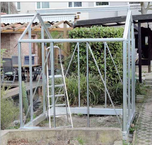
6 Wenn der Giebel eingesetzt ist, kann das Treibhaus noch mal exakt ausgerichtet und auf dem Fundament festgeschraubt werden.
