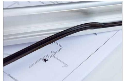
**2** Vor der Montage werden die nötigen Dichtgummis in die Alu-Profile gesteckt.
