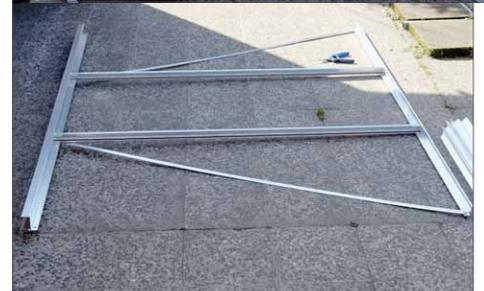
**4** Zuerst werden Seiten- und Stirnwände liegend zusammenschraubt
