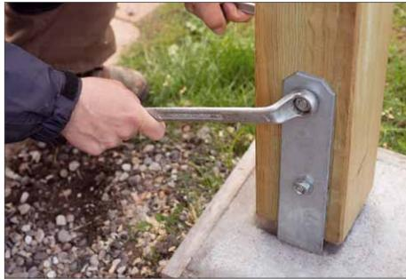
**4** Mit einem Akkuschauber werden Löcher für die Schrauben durchgebohrt. Anschließend werden die Schrauben durchgesteckt und angezogen
