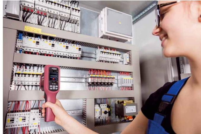
Bei der Prüfung ob elektrische Installationen überlastet sind, kann eine Wärmebildkamera wie die Testboy TV 291 hilfreich sein
