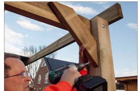
**10** Zur Stabilisierung der Konstruktion werden an den Ecken Stützstreben gesetzt. Am besten werden diese zuerst am senkrechten Balken angeschraubt und anschließend am Querbalken.
