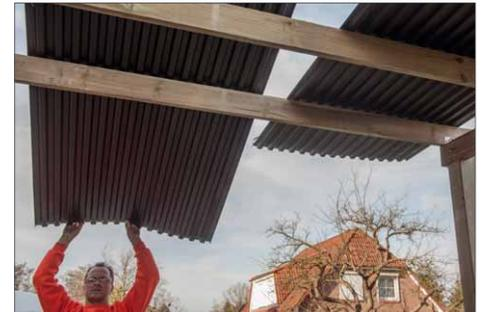
**9** Nun werden die Wellbleche für das Dach aufgelegt und ausgerichtet. Dabei sollte darauf geachtet werden, dass sie an beiden Seiten den gleichen Überhang haben. Anschließend werden die Platten durchgebohrt und verschraubt
