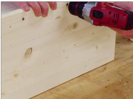
14 Dann werden die Schrauben eingedreht. Sie ziehen das Brett unter den Boden, so dass der Leim unter dem erforderlichen Pressdruck abbinden kann.
