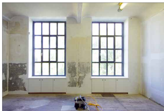
4 Meter hohe Wände, Ecken und Rundungen – das ideale Einsatzgebiet für ein leistungsfähiges Airless-Sprühgerät
