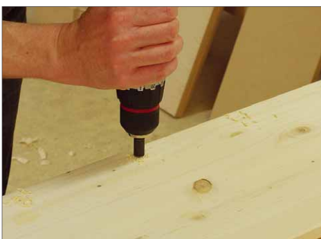
10 Senkbohrungen (nicht zu groß) verhindern, dass die Schraubenköpfe später das Holz einreißen.
