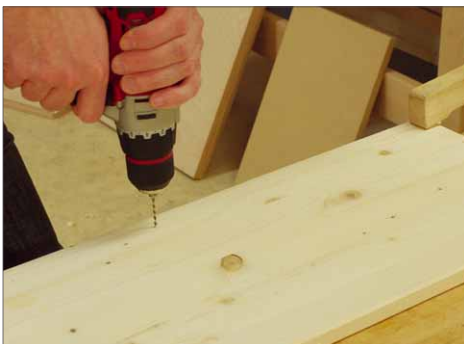
9 Anschließend bohrt man durch die Böden Löcher für 3–4 Schrauben vor. Die Löcher sollten mittig in den Brettern darunter landen. Das kann man ausmessen oder mit einem guten Augenmaß machen.
