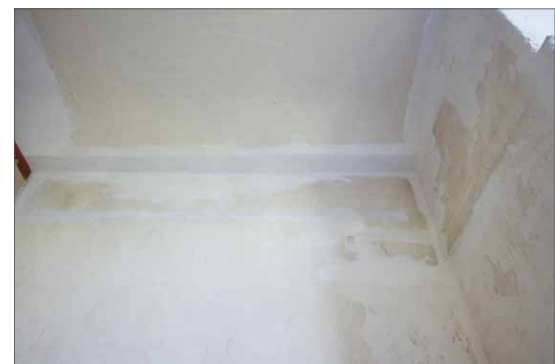
Nicht schön: Beim Streichen mit der Rolle hätte man die alte Leimfarbe bestimmt schnell an der Rolle kleben – ein sauberes Streichergebnis könnte man vergessen. Beim Sprühen sind solche Probleme nicht zu befürchten
