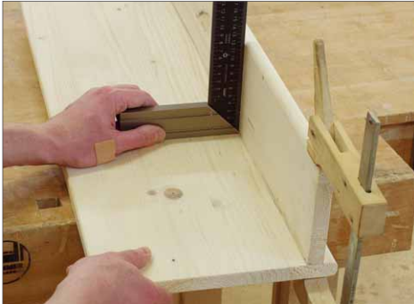
8 Die Bretter werden mit kleinen Leimzweigen provisorisch unter dem Boden bzw. Deckel des Regals fixiert. Mit dem Tischlerwinkel kann man prüfen, ob die Bretter senkrecht auf den Böden stehen.
