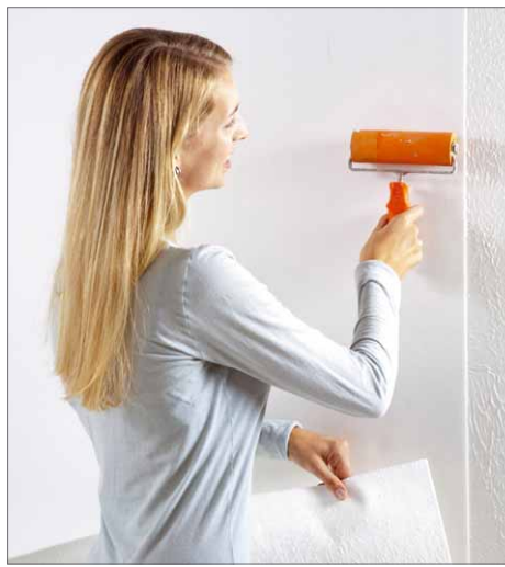
Das Thermovlies wird in Wandklebetechnik verklebt: Kleber auf die Wand, anschließend die Tapetenbahnen auf Stoß andrücken
