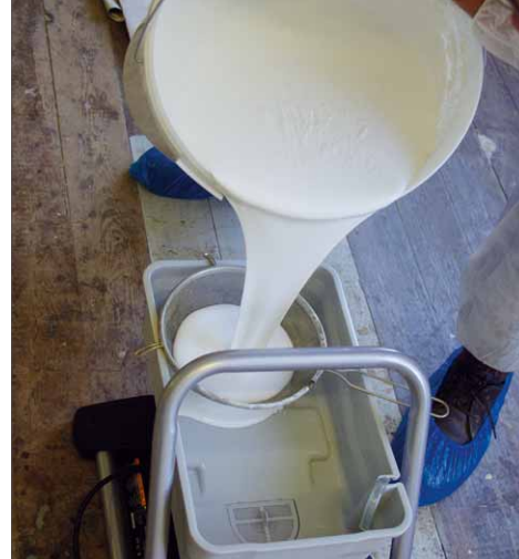
Anschließend wird sie durch ein Sieb in den Farbbehälter gefüllt
