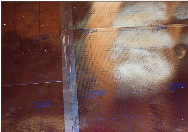
3 ... mit speziellem Klebeband verbunden wurden. So erhalten wir eine gute Abdichtung
