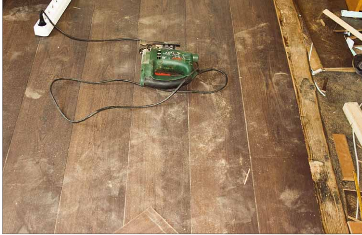
13 Schon nach kurzer Zeit nimmt die Fläche Form an
