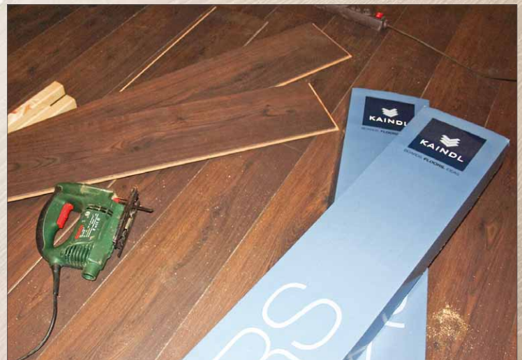
16 Der Boden von Kaindl überzeugt durch seine hohe Widerstandsfähigkeit und lässt sich dank der guten Klickverbindung sehr einfach verlegen.
