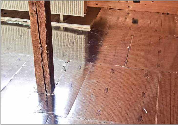
7 Der erhöhte Heizkörper-Absatz wurde ebenfalls mit SELITstop eingefasst
