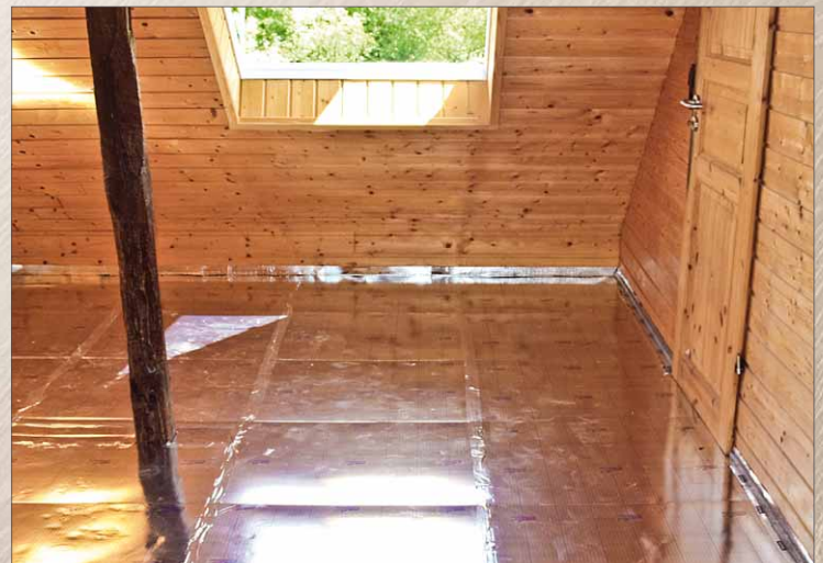
4 Nach der Verlegung bildet die Trittschalldämmung eine geschlossene Fläche
