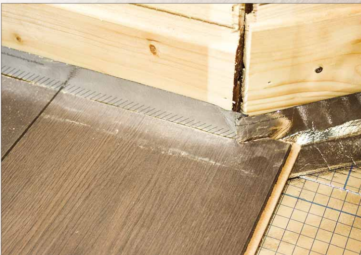
11 An den Ecken wird das Paneel dem Wandverlauf angepasst. Hierbei ist zu beachten, dass immer der nötige Abstand von 5 bis 10 Millimetern zur Wand eingehalten wird.
