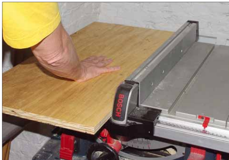
12 In die Bretter werden auf der Unterseite Nuten geschlitzt, in denen später die Gewindestangen verlaufen. Damit die Gewindestangen später in der Mitte der Holme befestigt werden können, haben wir die 6 mm breiten, 10 mm tiefen Nuten mit 2 cm Abstand zur Bodenkante angebracht. Das kann man z.B. durch mehrere nebeneinander liegende verdeckte Schnitte auf der Tischkreissäge machen...
