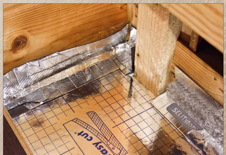
6 Um auch die Ränder abzudichten, haben wir um den ganzen Boden herum SELITstop verlegt
