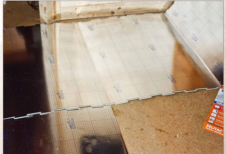
2 Zuerst wird die Trittschalldämmung verlegt. Wir haben auf eine Dampfsperre verzichtet, da der Boden trocken ist und die Dämmplatten ...
