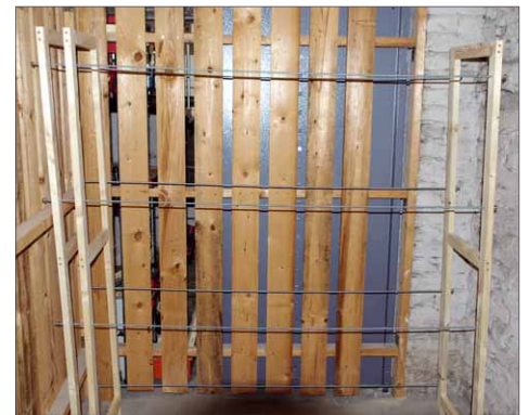
17 Um das Regal auch unter beengten Bedingungen aufbauen zu können, kann man die Gewindestangen „einfädeln“, wenn die mittlere Leiter erst einmal auf einer Seite steht.
