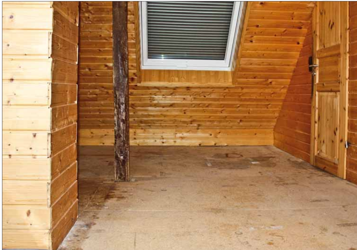
1 Frisch ausgebaut fehlt nur noch der Boden. Der Untergrund besteht aus Spanplatten und ist tragfähig
