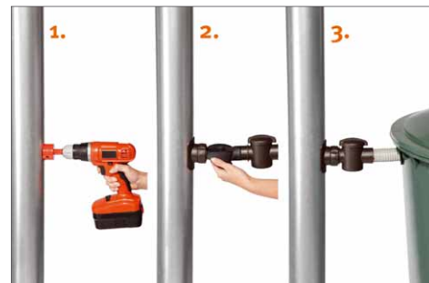
Mit nur drei einfachen Arbeitsschritten wird das Fallrohr angezapft. Schon kann das Regenwasser zum Gießen genutzt werden. Die Funktionsskizze zeigt das Prinzip
