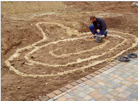
2 Zuerst wird mit Sand die grobe Form des Teiches und seines Bachlaufs festgelegt.
