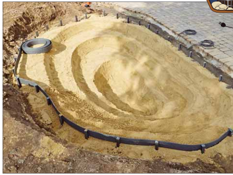
3 Nach dem Aushub wird erst der Grund mit Füllsand beschichtet und anschließend können die Teichränder eingesetzt werden.
