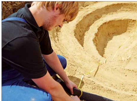
4 Mit einer Messschnur wird die Foliengröße bestimmt. Hierbei sollte großzügig gemessen werden.
