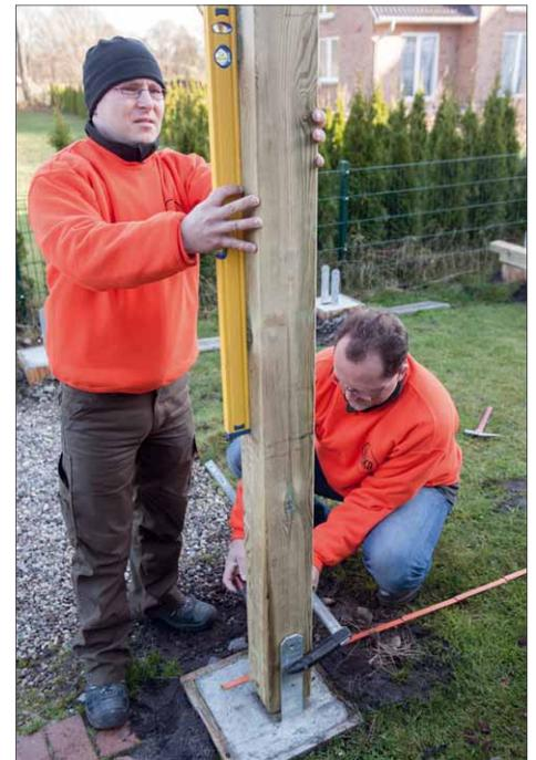
**6** Nachdem der Beton ausgehärtet ist, kann die Montage des Carportes beginnen. Auch hierbei ist darauf zu achten, dass alle Balken absolut senkrecht stehen. Schraubzwingen leisten zur vorläufigen Fixierung gute Dienste.
