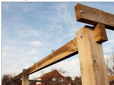
**15** Damit die Querbalken alle den gleichen Überstand haben, wird wieder mit einer Schnur gearbeitet.
