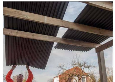
**19** Nun werden die Wellbleche des Dachs aufgelegt und ausgerichtet. Dabei sollte darauf geachtet werden, dass sie an beiden Seiten den gleichen Überhang haben.
