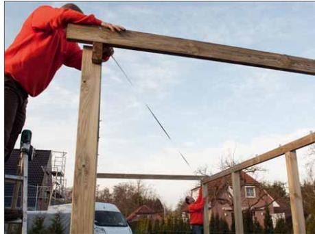
**14** Anschließend wird mit einer Diagonalmessung überprüft, ob die Konstruktion rechteckig ist.
