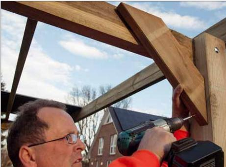
**21** Zur Stabilisierung der Konstruktion werden an den Ecken Stützstreben gesetzt. Am besten werden diese zuerst am senkrechten Balken angeschraubt ...
