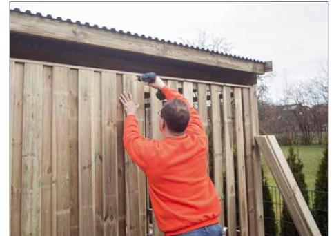
**25** Die zweite „Schicht“ Leisten wird auf der ersten Schicht verschraubt. So wird durch die Überlappung ein guter Schutz erreicht und dabei gleichzeitig eine gute Luftzirkulation sichergestellt.
