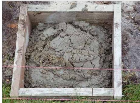
**1** Zur genauen Ausrichtung werden Schlagleinen gespannt, an denen die Fundamente platziert werden. Zuerst wird das Loch ausgeschachtet, dann mit Brettern ausgekleidet und anschließend kann der Beton eingefüllt werden.
