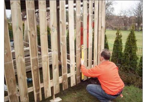
**24** Nun werden Seiten- und Stirnwand montiert. Diese bestehen aus einzelnen Leisten, die zueinander versetzt montiert werden. Bei der Ausrichtung leistet eine Wasserwaage gute Dienste.
