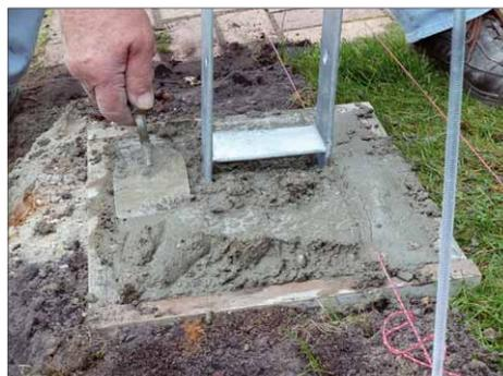
**3** Anschließend wird der Stahlschuh für die Holzbalken eingesetzt und der Rest Beton eingefüllt und glattgestrichen. Hierfür eignet sich am besten eine Mauerkelle.
