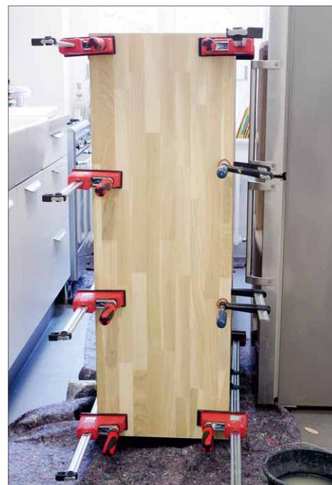
**17** Zuletzt wird der Deckel aufgeleimt. Nach dem Abbinden des Leims kann das Regal fertig aufgerichtet werden.
