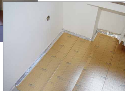
Die Trittschalldämmung wird mit Isolierband zu den Wänden hin versiegelt
