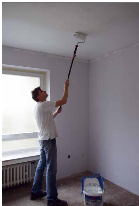
Für die Flächen eignet sich die Rolle am besten. Für die Decke empfiehlt sich eine Teleskopstange für die Rolle – damit erspart man es sich, ständig auf die Leiter steigen zu müssen
