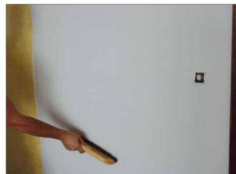
Orientiert man sich beim Tapezieren an geraden Referenzlinien, wie etwa hier am Türrahmen (rechts), spart man sich den Einsatz von Lot oder Linienlaser, um einen geraden Anfang für die erste Bahn zu haben
