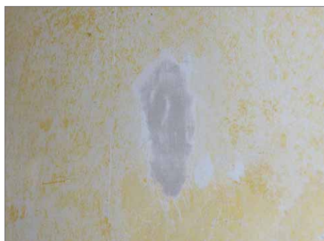
Löcher und Risse in den Wänden sollten sorgfältig gespachtelt werden
