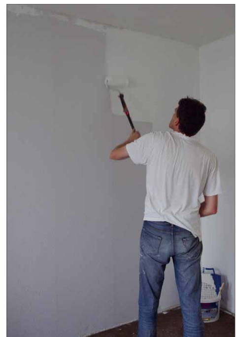
Auch beim Streichen der Wände erhöht die Teleskopstange die Reichweite
