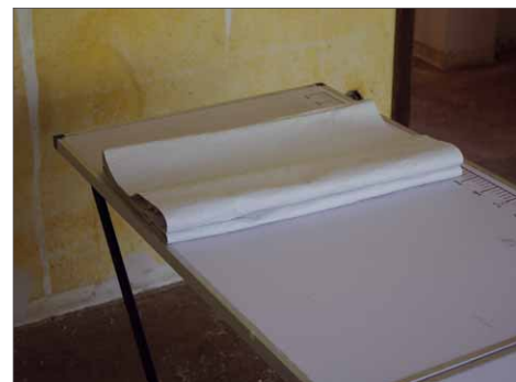
Die eingekleisterte Raufaser muss ein wenig quellen, bevor man sie an die Wand bringt
