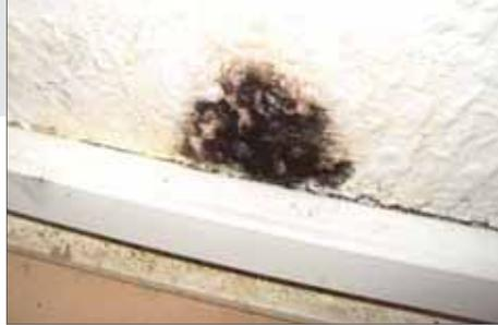
*Schimmel bildet sich verstärkt an kalten Außenwänden und versteckt sich in Ecken oder hinter Möbeln, wo die Luftzirkulation gering ist*
