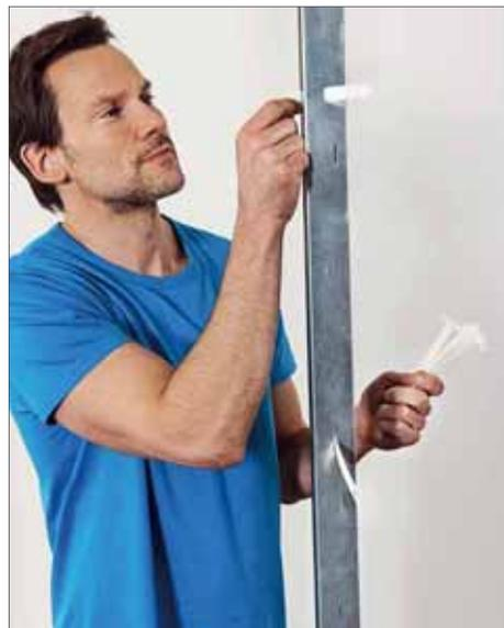
**2** Steht die Unterkonstruktion in regelmäßigen Abständen durch die Schlitze in den Profilen gesteckt.
