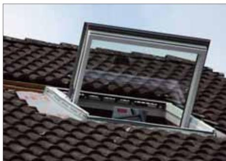
**4** In den vorbereiteten Rahmen wird der Fensterflügel eingehängt
