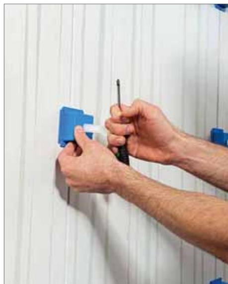
**5** ... und anschließend mithilfe eines Schraubendrehers mit den speziellen Caps auf den Zips fixiert.
