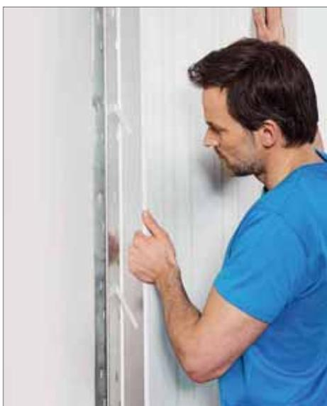
**4** Dann werden die Boards aufgesetzt, exakt ausgerichtet ...
