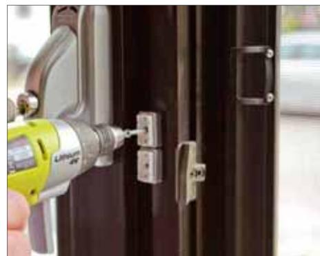
**6** Die Bodenplatte des Magneten kann am Rahmen angeklebt oder verschraubt werden. Weil der Magnet wie erwähnt sehr stark ist, empfiehlt sich die Verschraubung.
