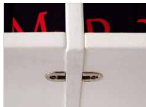
**9** Wir haben die Böden oben und unten zwei Millimeter nach innen versetzt, damit die Wangen die Krägen der Beschläge überdecken, wie hier am fertig montierten Regal zu sehen ist. Die Mitte des Dübellochs ist also 10 mm von den Enden der Wangen entfernt.
