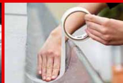
Auch in undichten Dachrinnen findet das hoch elastische Dichtband optimale Verwendung
