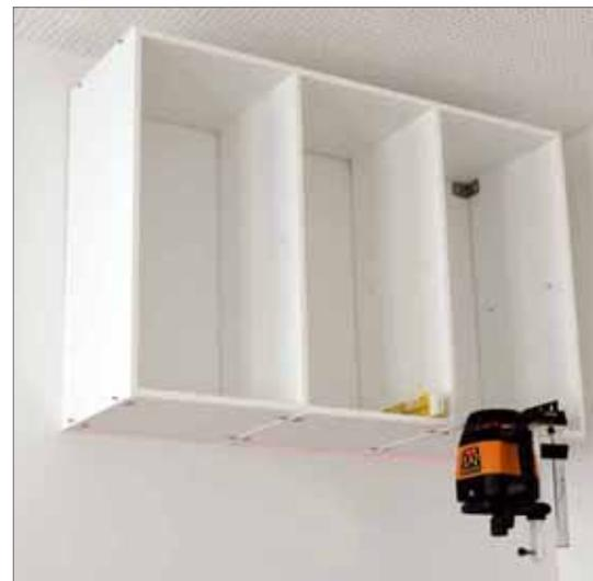
**10** Wenn der Lack trocken ist, wird das Regal Stück für Stück aufgehängt. Hier macht sich der Nachteil des Altbaus bemerkbar: Die Wände sind sehr krumm. Wasserwaage und Linienlaser helfen beim exakten Ausrichten des Regals
