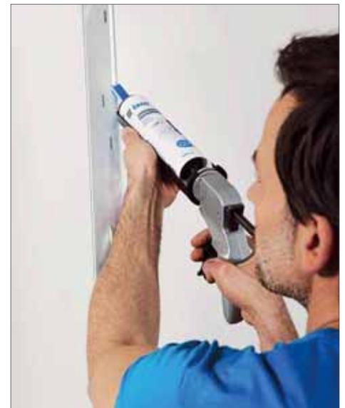
**3** Nachdem die einzelnen Boards auf die richtige Länge gebracht wurden (am besten jeweils trocken anhalten und prüfen, ob alles passt), wird der Spezialkleber auf die Profile aufgetragen.
