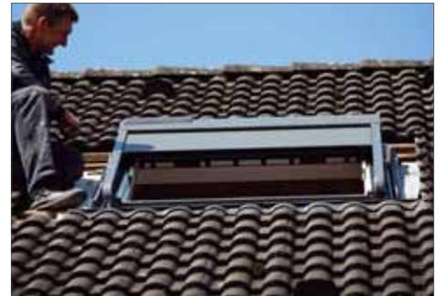
**5** Der Außen-Solar-Rolladen kommt auf das Fenster. Die Solarzelle für den Antrieb ist auf der linken Seite der Abdeckung gut zu erkennen
