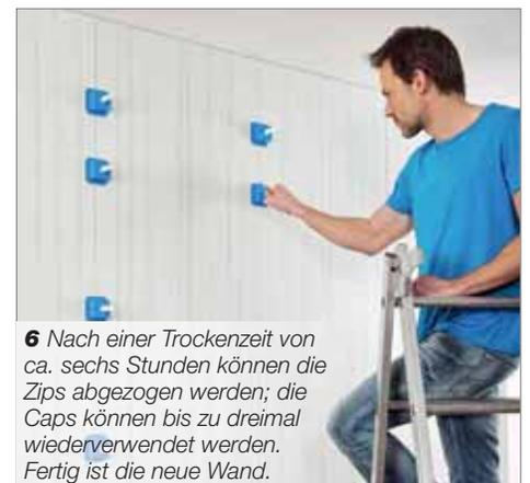
**6** Nach einer Trockenzeit von ca. sechs Stunden können die Zips abgezogen werden; die Caps können bis zu dreimal wiederverwendet werden. Fertig ist die neue Wand.
