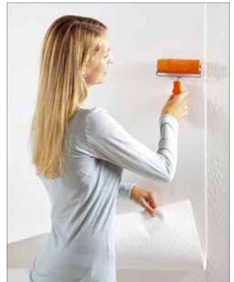
*Das Thermovlies wird in Wanklebeteknik verklebt: Kleber auf die Wand, anschließend die Tapetenbahnen auf Stoß andrücken*
