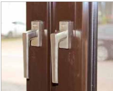
**1** Doppelflügelige Fenster wie dieses gibt es in beinahe jedem Haushalt. Insbesondere wenn ein Flügel auf Kipp steht, kann von Diebstahlschutz keine Rede sein. Durch den Kippspalt kann der geschlossene Flügel bequem geöffnet werden. Das soll in Zukunft verhindert werden.
