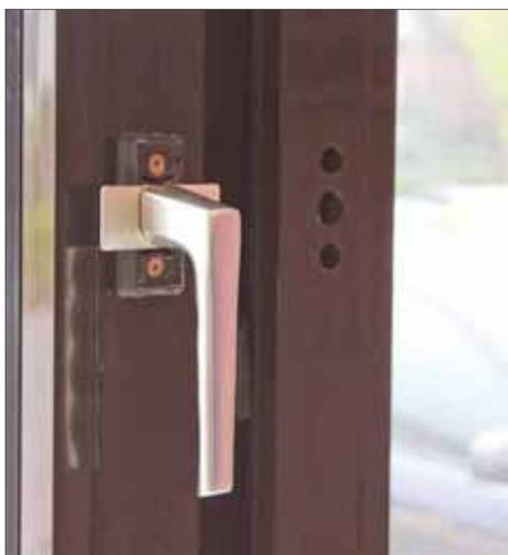
**2** Zunächst wird der vorhandene Griff demontiert. Um an die Schrauben zu gelangen, wird in unserem Fall nur die Metallblende leicht angehoben und um 90 Grad gedreht. Der Griff wird dann mit dem Antriebsvierkant abgenommen. Bei anderen Fabrikaten muss eventuell eine Blende heruntergeholt werden.
