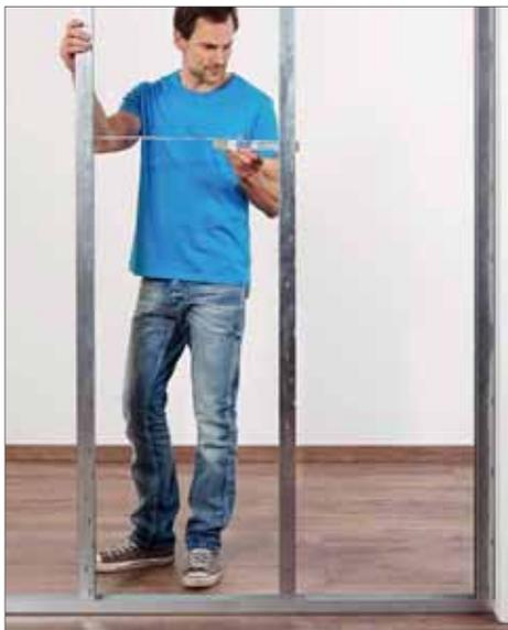
**1** Nachdem die genaue Position der neuen Perfectwall im Raum angezeichnet wurde, wird die Unterkonstruktion aus speziellen Perfectwall-Profilen gebaut. Neben Zollstock und Wasserwaage benötigt man lediglich eine Blechschere zum Zuschneiden der Profile sowie eine Bohrmaschine, um die Randprofile an Boden, Seitenwänden und Decke zu befestigen. Die senkrechten CW-Profile werden einfach nur in die Rahmenprofile eingeklemmt und exakt ausgerichtet.
