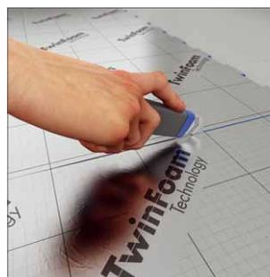
Der Rasterdruck auf der oberen Folie ermöglicht den präzisen Zuschnitt
