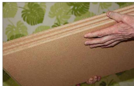
**3** Bevor die erste Reihe des KWG-Korkfertigparketts gelegt wird, ist die Säge gefragt: Die Korkfliesen werden auf der Wandseite durch einen geraden Schnitt mit der Kreis- oder Stichsäge von der Verbindungs-Feder befreit.
