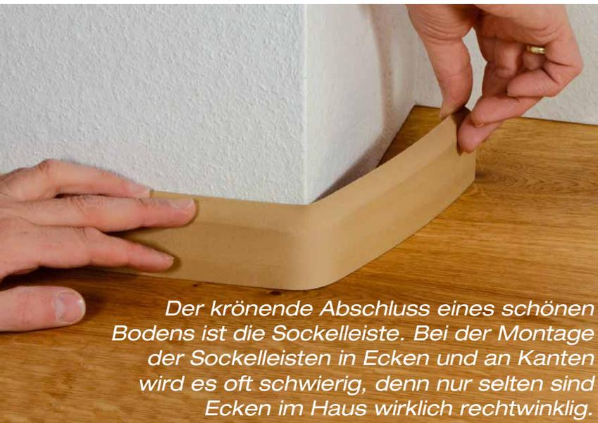
*Der krönende Abschluss eines schönen Bodens ist die Sockelleiste. Bei der Montage der Sockelleisten in Ecken und an Kanten wird es oft schwierig, denn nur selten sind Ecken im Haus wirklich rechtwinklig.*
