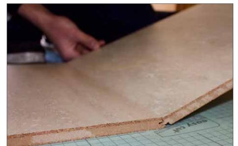
**4** Das Zusammenfügen der einzelnen Elemente geht dank der Klickverbindung zügig von der Hand. Schon bei der ersten Reihe lohnt es sich, sorgfältig zu arbeiten, damit der Boden am Ende völlig fugenlos liegt.
