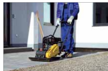
Nachdem der Untergrund verdichtet ist, lassen sich mit der selben Maschine dank Polyurethan-Matte auch empfindliche Platten einrütteln
