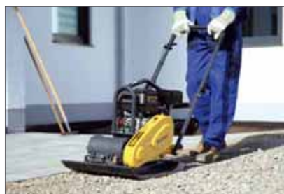
Nachdem der Untergrund verdichtet ist, lassen sich mit der selben Maschine dank Polyurethan-Matte auch empfindliche Platten einrütteln
