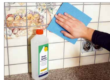
2 Zuerst wird der alte Fliesenspiegel gründlich gereinigt. Es dürfen keine Fettreste auf den Fliesen zurückbleiben
