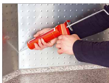
9 Abschließend können die Fugen mit dauerelastischer Masse abgedichtet werden, fertig!
