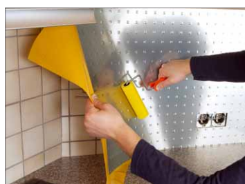
8 Dann kann die Dekorplatte mit ihrer Rückseite auf dem Fliesenspiegel verklebt werden. Dabei hilft eine Walze, um die Platte mit dem nötigen Anpressdruck zu fixieren
