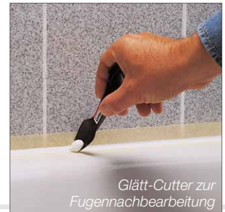
Abgelebt werden die Fliesen nicht beschmutzt
