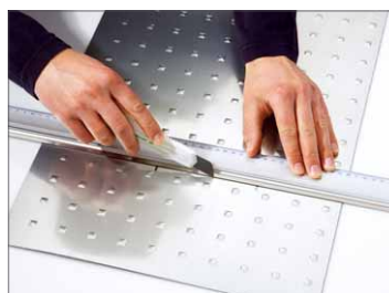
5 Mithilfe eines Lineals werden die Platten erst geritzt, ...
