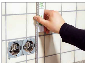
3 Im nächsten Schritt werden die Positionen von Steckdosen bestimmt, ...
