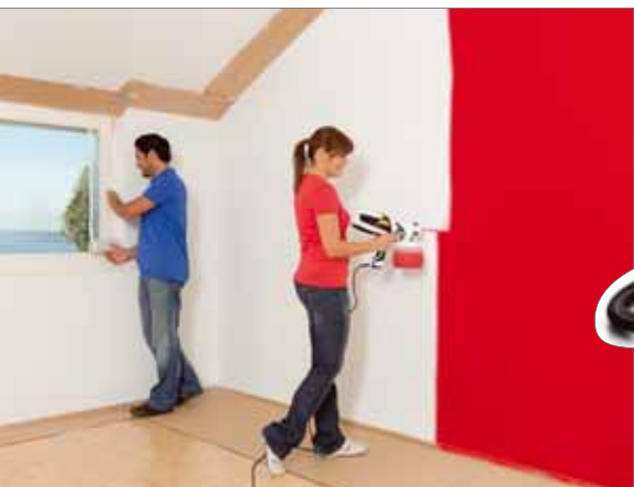
Mit Farbsprühsystemen geht der Auftrag von Innenwandfarbe besonders schnell von der Hand. Ecken, Winkel und Kanten müssen nicht mehr mühsam vorgestrichen werden, sondern werden „in einem Rutsch“ gleich mitbeschichtet
