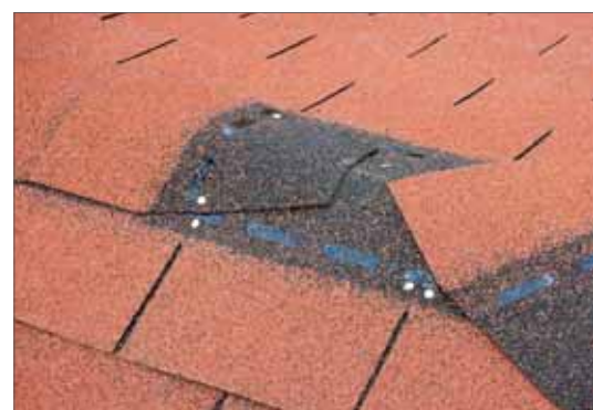
Der First wird doppelagig. Zuerst überlappen die Überstände beider Dachhälften. Somit ist das Dach schon mal dicht. Für die Optik und als zusätzliche Sicherheit werden aus den Platten V-förmige Segmente geschnitten, die dann über den First genagelt werden
