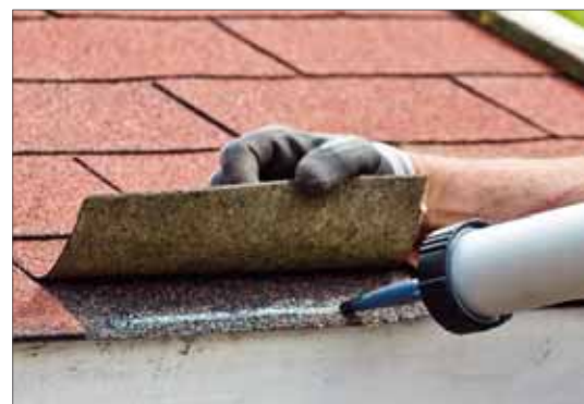
Damit der Wind die Schindeln nicht hochklappt, werden die Dachunterkanten, der First und evtl. die Giebelkanten mit Bitumenkleber verklebt
