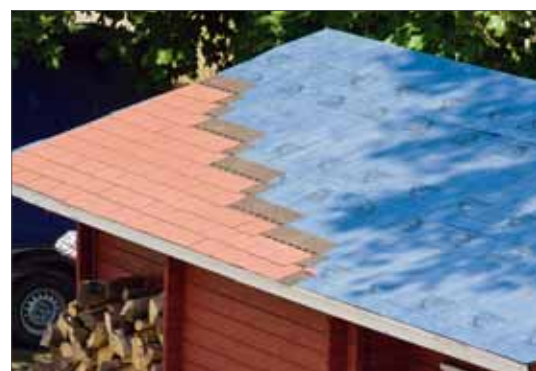
Als Nächstes werden die Schindelplatten Reihe für Reihe im Versatz vernagelt. Das Nageln dient dabei der Fixierung. Eine dichte Dachfläche entsteht durch den Klebestreifen an Unter- und Oberseite der Platten, der durch Sonneneinstrahlung weich wird und sich selbst verklebt
