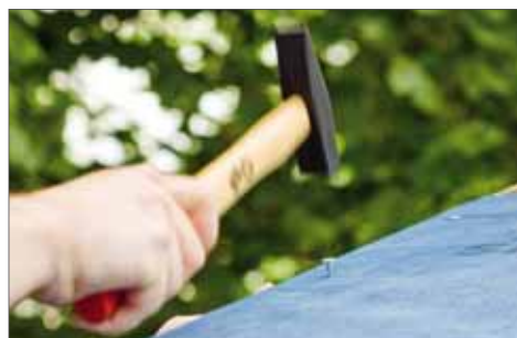
Auf das saubere Dach werden als Erstes die Vordeckbahnen von der Rolle aufgelegt und vernagelt. Logischerweise erfolgt dies von unten nach oben. Die Unterseite der Vordeckbahn ist bitumenbeschichtet und sorgt so schon für Dichtigkeit und Dämmung
