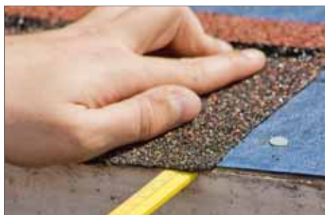
Die halben Platten werden mit einem Überstand von 6–10 mm verlegt und dienen als Tropfkante für ablaufendes Wasser. Alternativ können auch Traufkantenbleche verwendet werden
