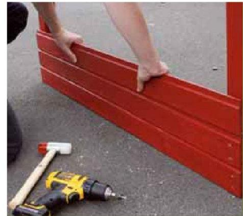
Die Seitenwände und die Rückwand werden Stück für Stück aus Nut-und-Feder-Brettern aufgebaut
