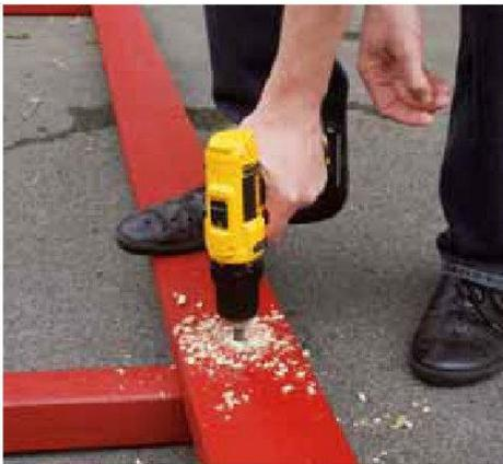
Um die Fußpfette mit den Pfosten zu verbinden, müssen 10-mm-Löcher für die Schlossschrauben gebohrt werden
