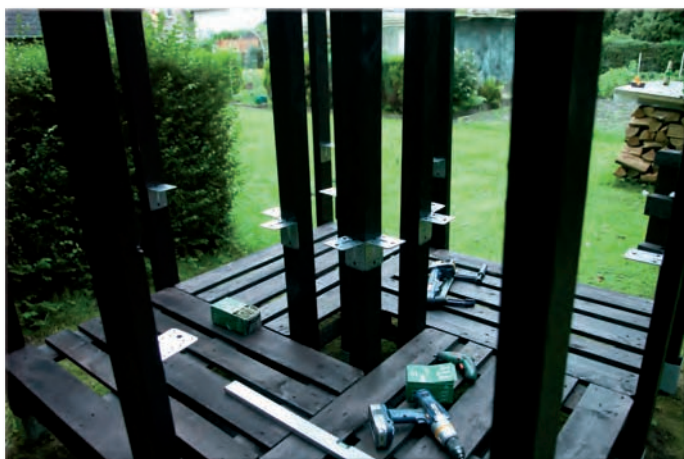
Die vier Paletten werden jeweils um 90 Grad versetzt angeordnet. Das Ergebnis ist eine quadratische Fläche mit einer Öffnung von 40 x 40 cm in der Mitte. Diese sorgt zusätzlich für Belüftung des eingestapelten Holzes
