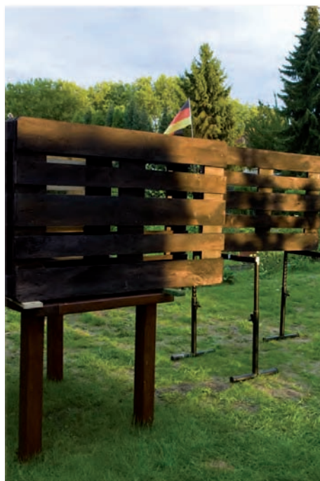
Nach dem Setzen der Erdhülsen werden die ersten Winkel innen ans Ständerwerk geschraubt, an die kommt man hinterher nicht mehr dran. Dann werden die Paletten eingesetzt, per Wasserwaage ausgerichtet und mit den restlichen Winkeln verschraubt. Die Stützpfeiler stehen noch lose in den Einschlaghülsen
