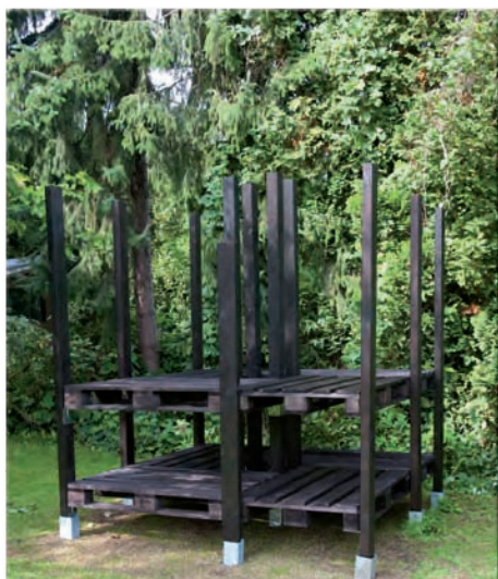
Einen halben Meter oberhalb der ersten Lage wird die zweite Palettenebene eingebaut. Die Vorgehensweise ist dieselbe wie zuvor
