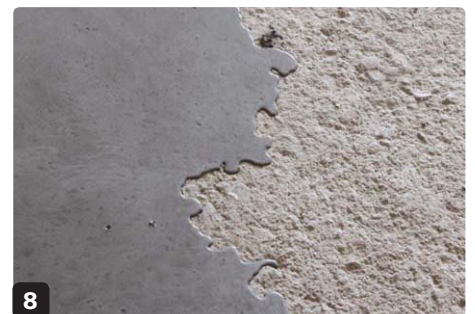
7 Pour the compound on the raw floor
