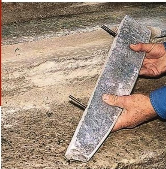
**5/** Percez deux trous Ø 8 mm dans la tranche de la pièce, remplissez-les de colle époxy (Araldite), puis insérez deux tiges filetées en laiton Ø 6x100 mm.
