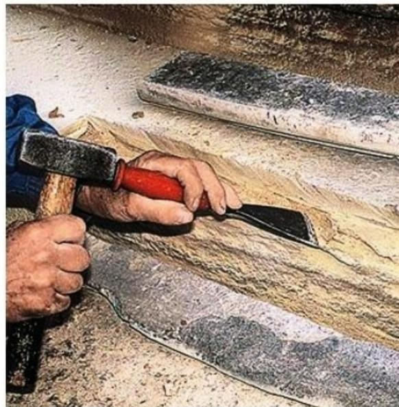
**4/** En frappant doucement et régulièrement, rectifiez la pierre évidée avec un ciseau de maçon. Respectez le plus précisément possible les dimensions de la pièce à venir.
