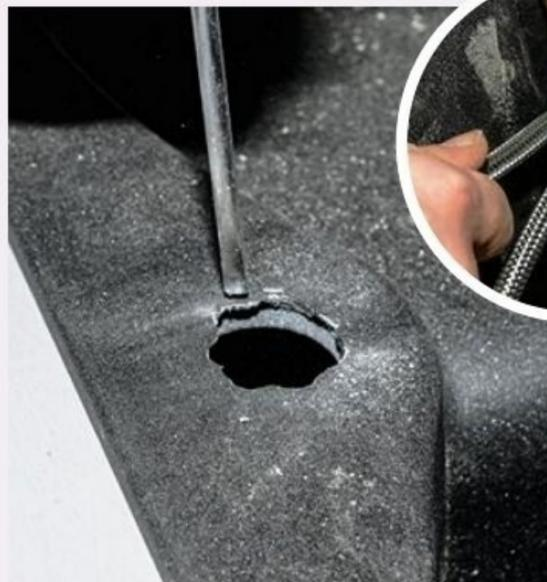
**8** Ajustez le perçage afin que le diamètre du trou corresponde au plus près à celui de la robinetterie. Attention de ne pas percer trop large !
