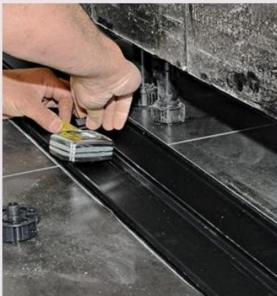
**22** Posez la plinthe face avant contre le sol pour repérer les emplacements des pieds de meubles. Reportez-les au dos de la plinthe et enfoncez les taquets de fixation dans la rainure. Emboîtez la plinthe. Procédez de la même façon pour les autres caissons.
