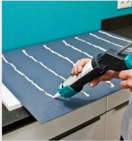
**2** Après séchage, réalisez au pistolet extrudeur des cordons de 10 mm d'épaisseur de mastic-colle. Répartissez-les uniformément et à égale distance.
