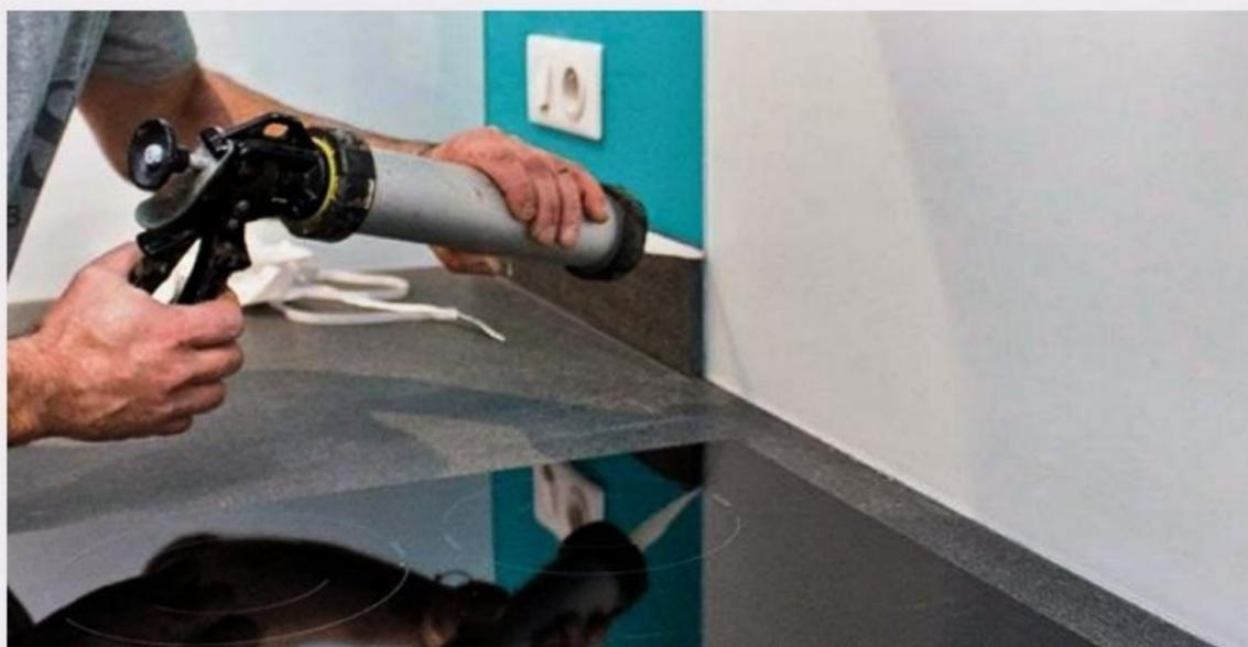
**22** Dépoussiérez autour de la plaque de cuisson et appliquez un joint de silicone transparent en bas et sur les côtés de la crédence. Laissez sécher 24 h.
