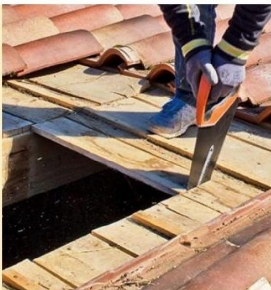
**8** Tracez sur la volige les dimensions du nouveau châssis à installer. À la scie sabre ou égoïne, découpez le voligeage pour agrandir la trémie aux dimensions du nouveau châssis.
