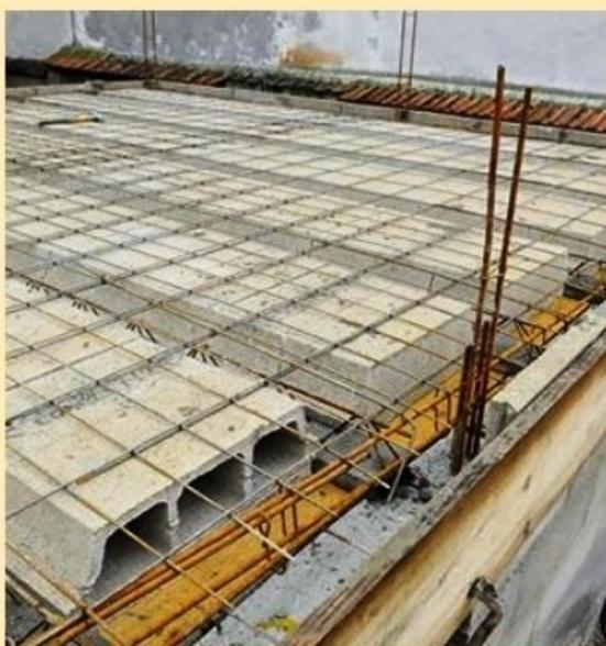
**8** Entre les hourdis (ou entrevous) et les planelles, des fers ( $\varnothing$  10 mm) sont placés sur toute la périphérie du plancher. Pour les espacer régulièrement, le premier rang de fer est posé sur la partie en béton des poutrelles et le second rang sur le treillis de celles-ci. L'espace entre les entrevous et les planelles est coffré par le dessous pour couler le béton de la dalle.
