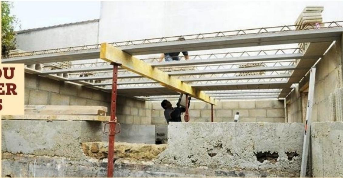
**1** Les poutrelles sont posées perpendiculairement au sens le plus long du bâti en respectant l'entraxe défini par les calculs du bureau d'études (ici 52 cm). L'extrémité des poutrelles doit reposer parfaitement sur l'arase des murs. Des étais (un à chaque extrémité, un au centre) et un bastaing suffisamment long sont installés pour soutenir le futur plancher.
