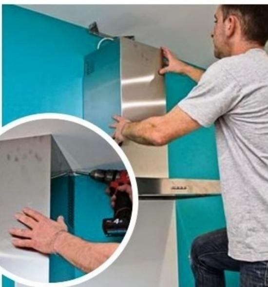
**18** Installez le conduit dans la réservation se trouvant sur la hotte. Déployez-le jusqu'au plafond puis vissez-le sur le côté sur la fixation installée.
