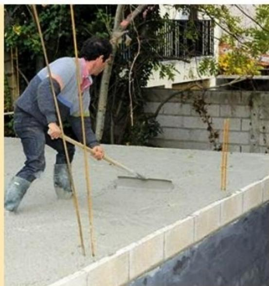
**12** Le béton est livré par camion toupie. Pour la mise en œuvre de la dalle plusieurs personnes sont nécessaires. L'une coule le béton, l'autre l'étale à l'aide d'un épandeur. Le béton affleure le chant supérieur des planelles. L'armature doit être recouverte par plusieurs centimètres de béton. Sans cela, elle risque de s'oxyder et de créer des fissures dans la dalle.
