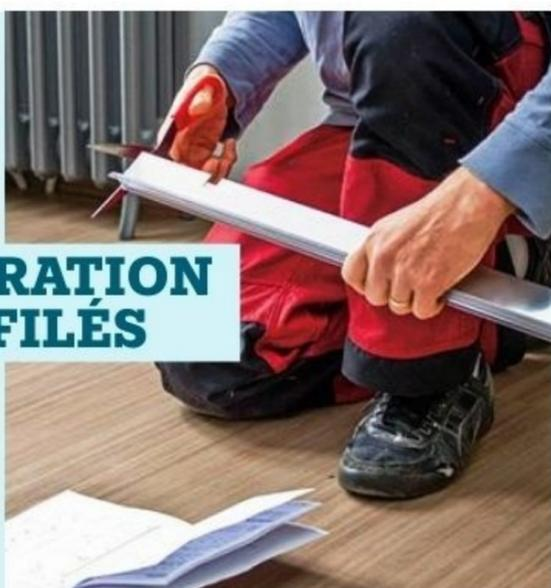
**1** En suivant la notice d'installation, insérez un premier joint dans les gorges du montant de la porte et découpez le surplus aux ciseaux.
