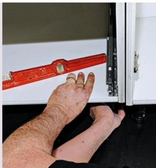
**13** À l'aide d'un niveau à bulle posé en diagonal, réglez les aplombs de chaque caisson dans les deux sens en jouant sur la hauteur des pieds.
