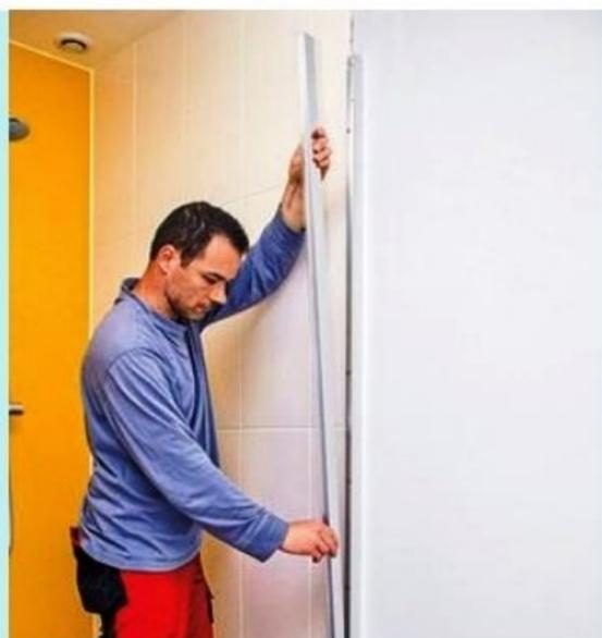
**11** Après vissage, dépoussiérez le sol puis insérez dans le montant fixé au mur, celui comprenant le pivot de la porte de douche.
