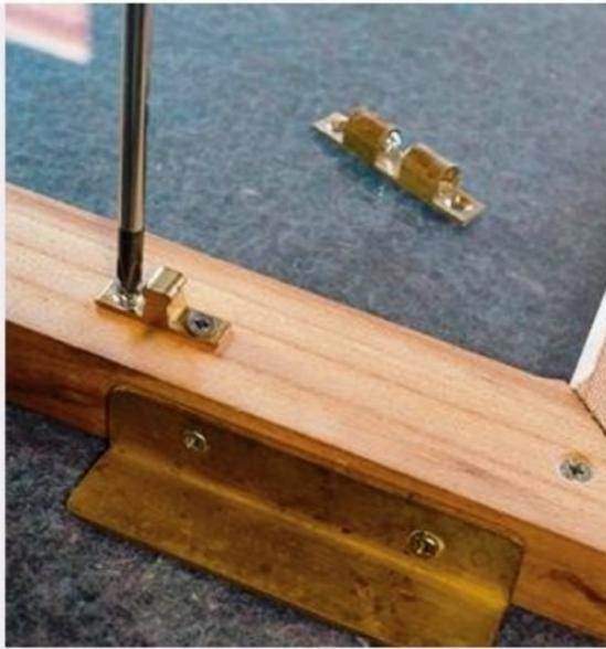
**15** Fixez les loquets à bille, également en laiton. Sur la partie dormante (le caisson), la partie femelle du loquet est intégrée dans l'épaisseur du bois.
