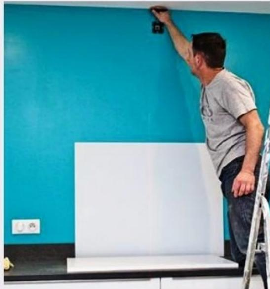
**5** Positionnez un niveau laser (ou à défaut un niveau et un mètre) sur le trait de repère et marquez au crayon en haut de la cloison sa projection à la limite du plafond.
