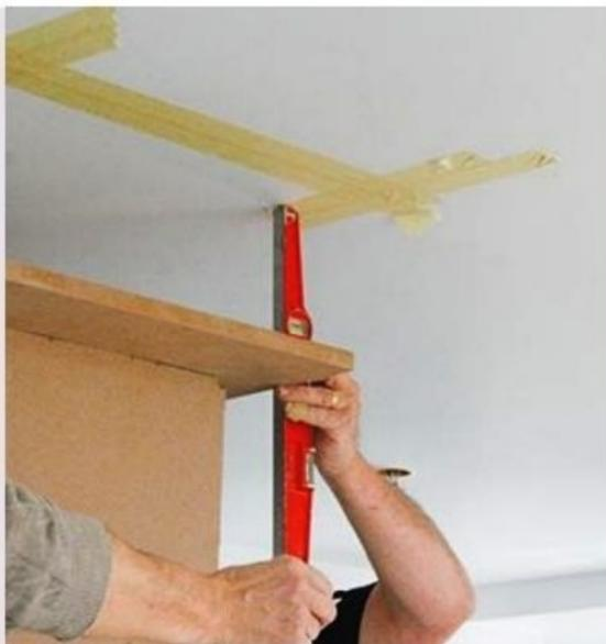
**26** Positionnez le dessus du caisson sur la joue murale. Calez-le de niveau à l'aide d'une planche posée sur le meuble bas. Repérez les points d'ancrage.
