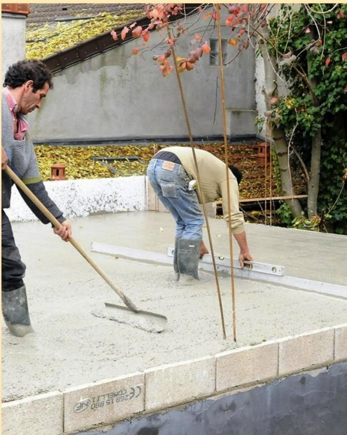
**13** Au fur et à mesure du coulage, le béton est nivelé à l'aide d'une longue règle de maçon surmontée d'un niveau à bulle. Lors de cette phase, travailler à trois est un plus : l'un coule, l'autre étale, le suivant nivelle, etc.
