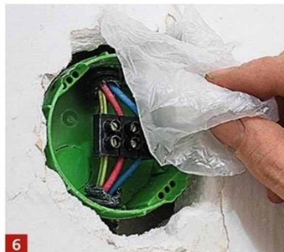
**6** Protégez la réparation en l'enroulant soigneusement dans un morceau de plastique. Maintenez l'ensemble avec un bout de ruban adhésif.
