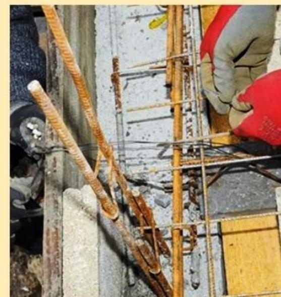
**11** Les « petits » coffrages réalisés en amont sont maintenus avec du fil attaché à l'armature. Cela permet de bien plaquer le haut du coffrage contre les planelles.
