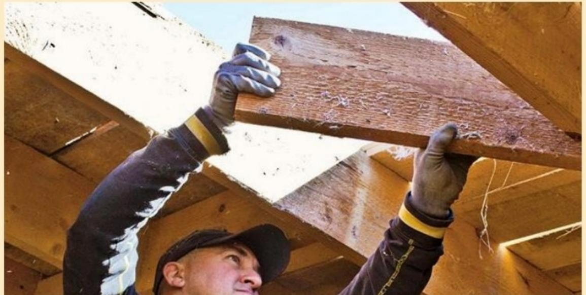
**7** Au niveau de la trémie, retirez au marteau l'éventuelle entretoise en bois servant à rigidifier les chevrons. Si nécessaire, coupez-la en deux à la scie sabre pour l'arracher plus facilement de ses clous de fixation.
