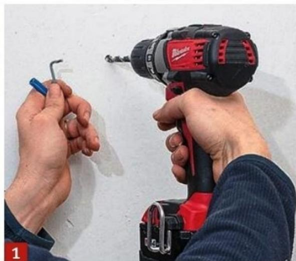
**1** Les câbles électriques circulent dans l'épaisseur des cloisons. En perceant, vous pouvez accidentellement couper un circuit. Toute l'installation saute.
