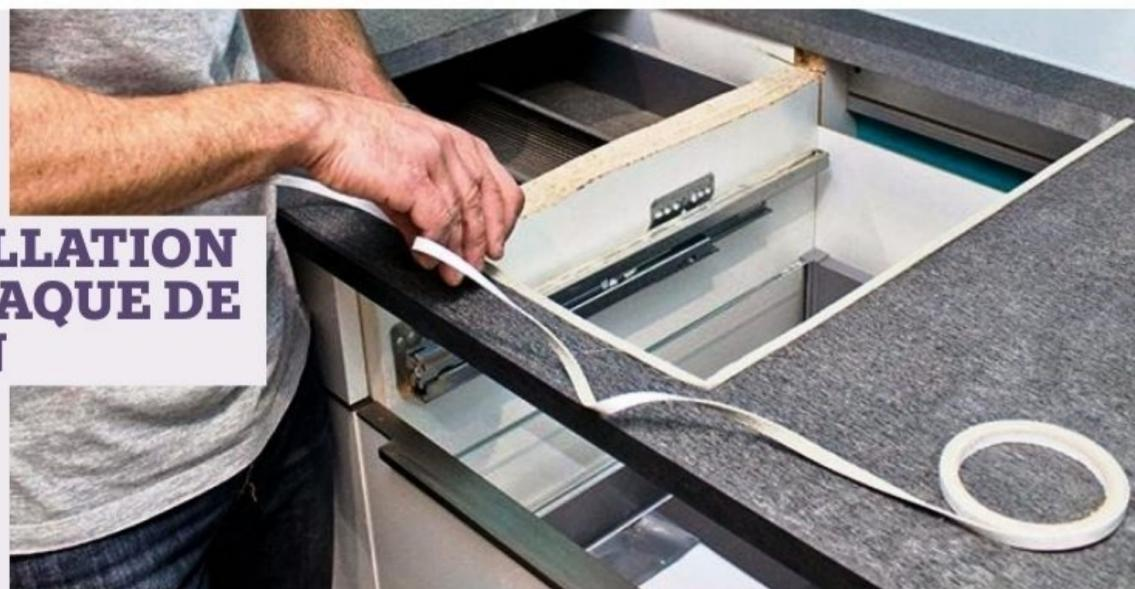
**19** Après avoir découpé (ou fait découper) le plan de travail aux cotes d'encastrement de la plaque, posez le joint souple d'étanchéité généralement livré avec la plaque sur le pourtour de la découpe. Il maintiendra la table de cuisson en place.
