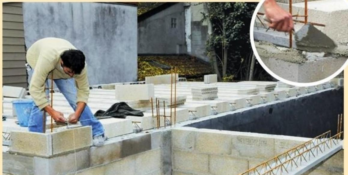
**5** Pour poser les planelles intermédiaires parfaitement alignées, un cordeau est tiré entre les angles. L'horizontalité et la verticalité sont constamment contrôlées avec un niveau à bulle et corrigées si besoin.
