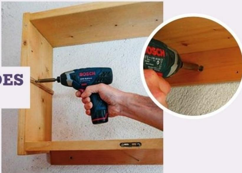
**18** Percez ( $\varnothing$  4 mm) dans les faces intérieures des côtés des caissons pour intégrer des taquets d'étagère. Les caissons sont soutenus par un tasseau fixé au mur.
