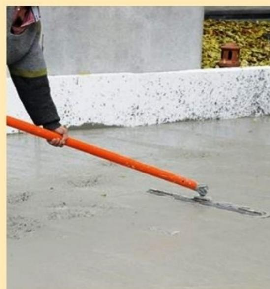
**14** Pour aplanir la surface du béton, une lisseuse est utilisée, en partant de la surface coulée en premier et en reculant vers l'autre extrémité de la dalle.
