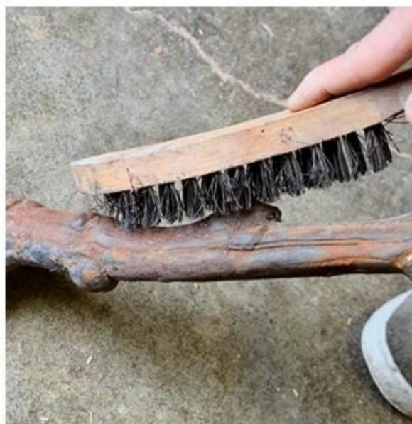
**1/** Brossez le piètement à l'aide d'une brosse métallique pour éliminer la rouille. Vous pouvez utiliser également une brosse rotative en fil d'acier montée sur une perceuse.
