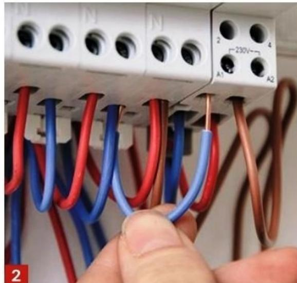
2 Le télérupteur est raccordé par deux fils au module de protection du circuit, et deux autres au bouton-poussoir. Débranchez et repérez les fils.
