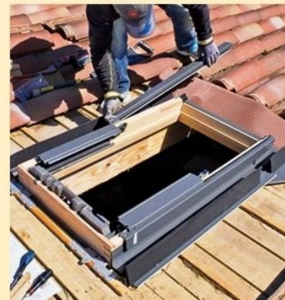
**12** Poursuivez la mise en place des autres éléments d'étanchéité sur le haut du cadre du châssis. Certaines pièces sont à emboîter et d'autres à visser.
