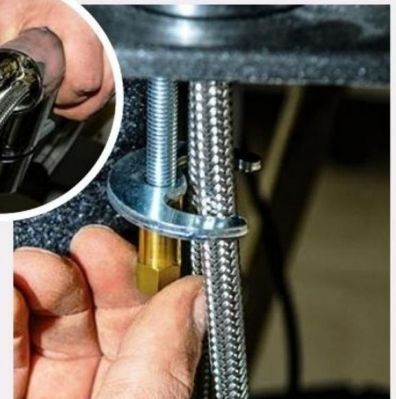
**9** Positionnez le mitigeur une fois les flexibles d'alimentation engagés dans l'orifice de l'évier. Enclenchez la cale de serrage et vissez l'écrou à la main, puis à la clé.
