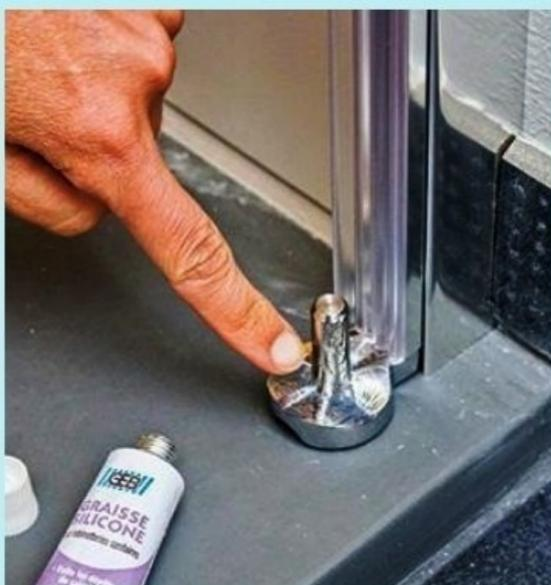
**13** Sur le pivot en bas du montant de la porte vitrée, déposez de la graisse silicone pour faciliter la rotation de la porte et assurer son étanchéité.
