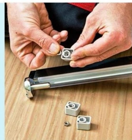
**3** Pour faire le lien entre le montant et le mur, installez les écrous de vissage dans leur emplacement respectif.
