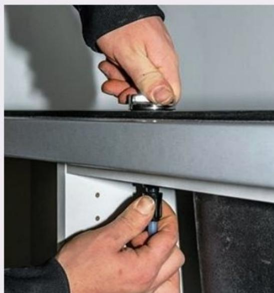
**16** Raccordez le flexible de commande du clapet de bonde au bouton prévu à cet effet, disposé sur le devant de l'évier.
