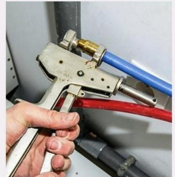
**6** Le raccordement avec les flexibles d'alimentation s'effectue par un raccord à sertir. Montez le raccord avec une pince à sertir après manchonnage du tube.
