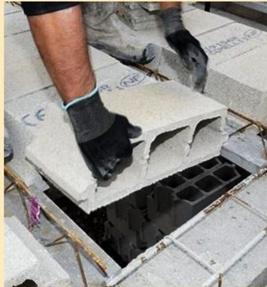
**3** En fin de rangée, l'espace entre l'extrémité de la poutrelle et du dernier élément est mesuré. La mesure est ensuite reportée sur un entrevous, découpé à dimension à l'aide d'une meuleuse Ø 230 mm équipée d'un disque diamant.
