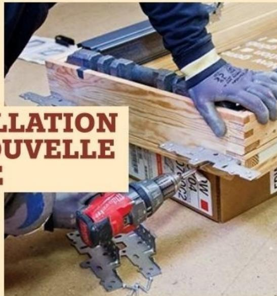
**5** Sortez la nouvelle fenêtre et séparez l'ouvrant de son châssis. Vissez les quatre fixations fournies dans les angles en suivant les indications du fabricant.
