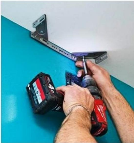
**10** Remplacez le dispositif de fixation du conduit de hotte et vissez-le au plafond dans les chevilles métalliques précédemment installées.
