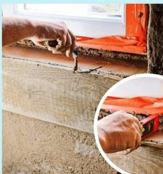
**13** Remplissez le coffrage jusqu'à atteindre le chant supérieur de la planche. Lissez la surface à la truelle ou au platoir. Contrôlez l'horizontalité de l'appui dans le sens avant arrière.
