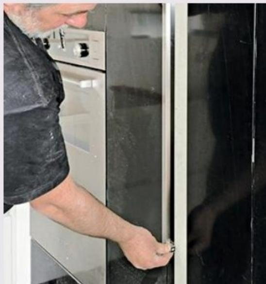
**24** À l'aide d'un mètre, reportez l'entraxe des fixations sur l'axe tracé. Avant de poinçonner les repères et de percer, contrôlez leur correspondance à l'aide d'une des poignées.
