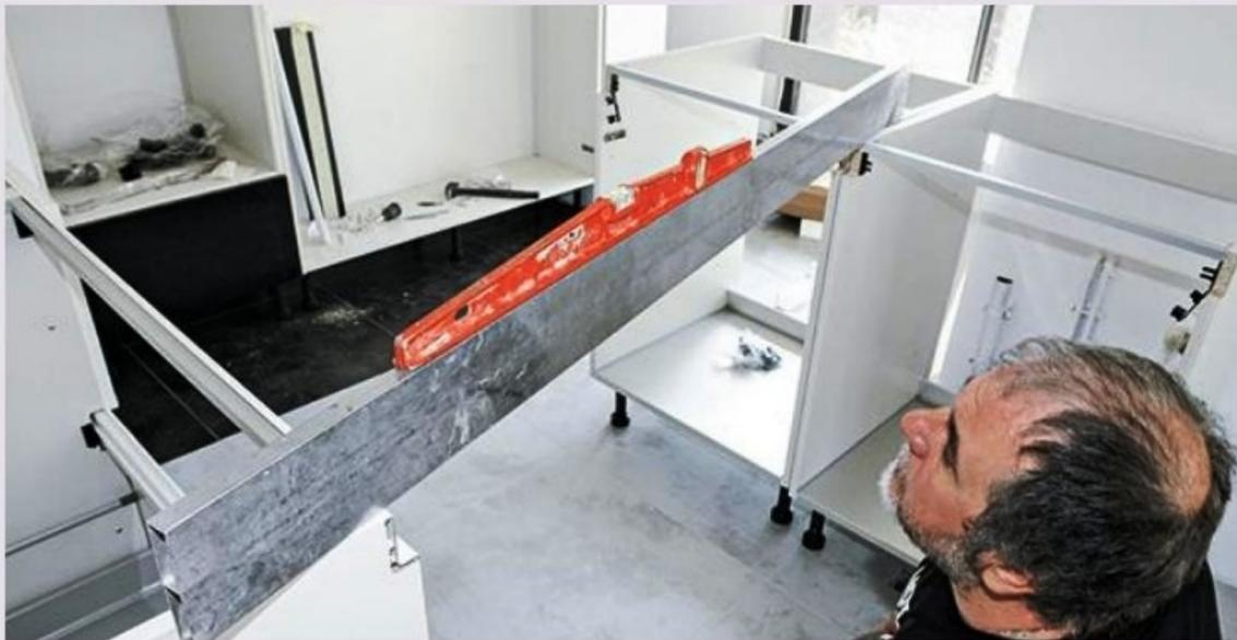
**8** Vérifiez que tous les meubles bas arrivent à la même hauteur à l'aide d'une grande règle et d'un niveau à bulle. Ajustez si nécessaire la hauteur des pieds de l'une ou l'autre série de caissons.
