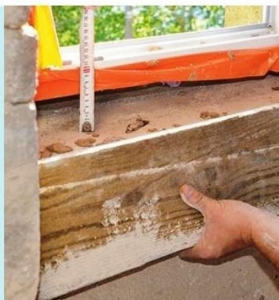
**12** En cas de décalage entre la fenêtre et le bas du tableau, la réalisation d'un coffrage est inévitable. Coupez une planche plane et lisse à la longueur de l'appui. Fixez-la d'un côté avec une chevillette pour qu'elle arrive à la hauteur voulue. Réglez l'horizontalité de la planche et enfoncez une seconde chevillette.
