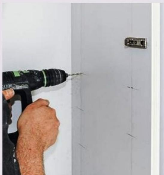
**19** Marquez les emplacements des perçages d'un coup de poinçon. Percez ensuite les avant-trous (sans déboucher) au diamètre exact des taquets fournis par le fabricant.
