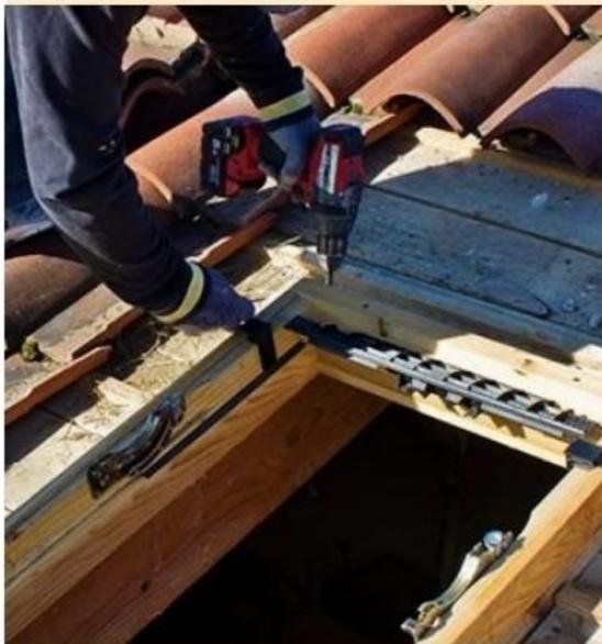
**4** Pour retirer le châssis, ôtez les vis au niveau des pattes métalliques de fixation présentes aux quatre angles du dormant de la fenêtre de toit.
