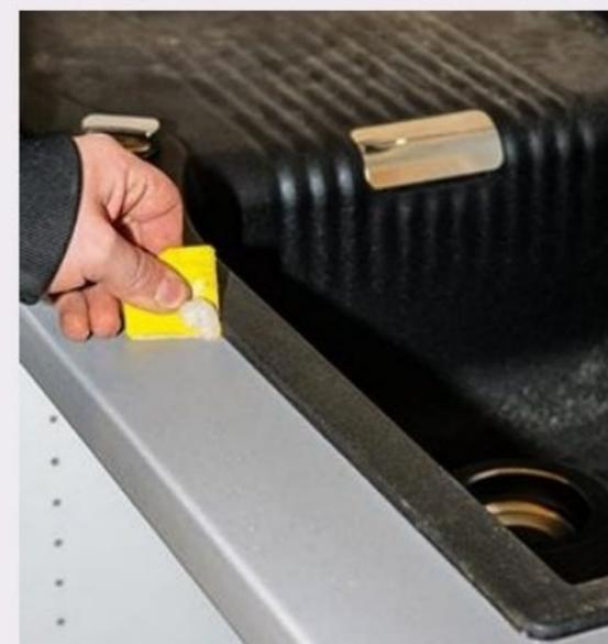
**14** Le mastic silicone formant le joint reflue en périphérie du bac. Éliminez ce débordement avec un lisseur à joint.
