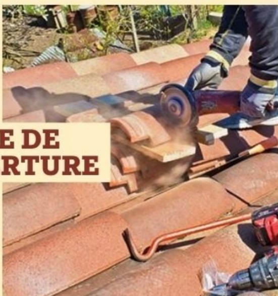
**13** Mesurez et tracez des repères sur les tuiles devant être recoupées. Utilisez une meuleuse équipée d'un disque de maçonnerie (diamant) pour les retailler.
