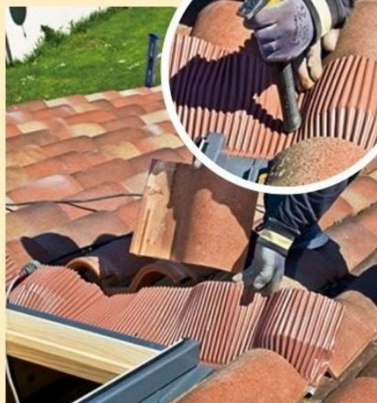
**14** Reposez les tuiles en périphérie de la fenêtre de toit. Formez et écrasez la bavette plissée en plomb sur les tuiles du bas pour assurer l'étanchéité et l'écoulement de l'eau.
