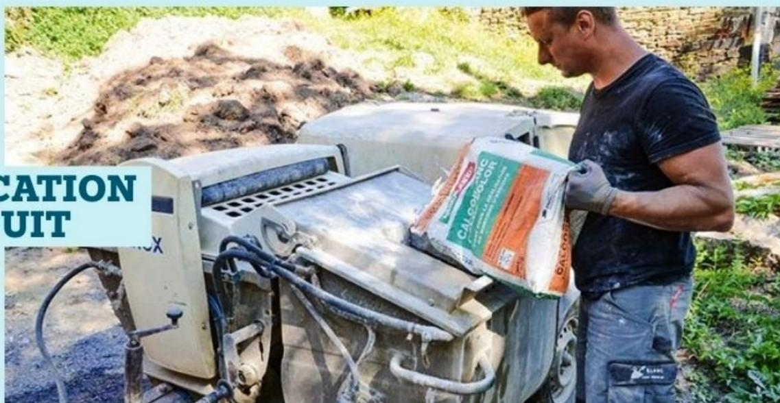
**3** Montez la buse requise sur la lance de la machine à projeter puis raccordez-la à un robinet et démarrez le moteur. Déversez directement le contenu d'un premier sac dans la trémie. Comptez de 9 à 14 l d'eau par sac de 20 kg, plus 60 kg de sable calibre 0-2 ou 0-3 (environ quatre seaux). Mélangez pendant 5 min (5 à 7 min avec bétonnière).
