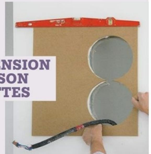
**25** Dans la joue (côté mur) du caisson suspendu abritant les hottes, découpez les passages des conduits d'extraction (Ø 125 mm). Chevillez et vissez la joue sur le mur.
