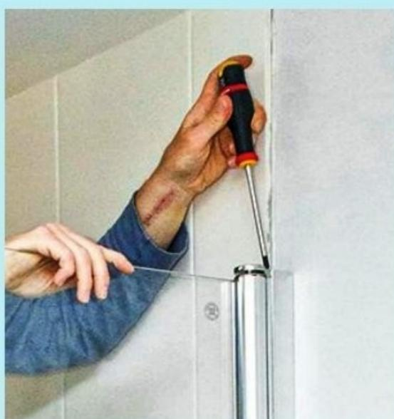
**18** Dévissez légèrement le connecteur en haut de la porte et testez sa fermeture contre la paroi vitrée fixe. Laissez 2 mm de vide pour le joint latéral.
