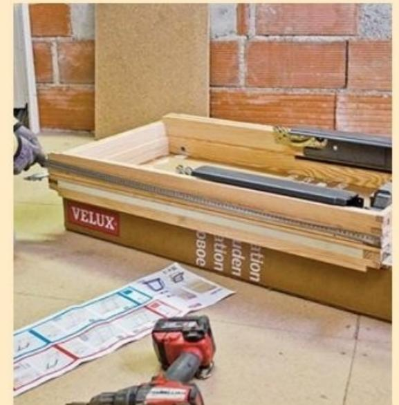
**6** Au mètre ruban, mesurez les dimensions du cadre à installer dans la trémie. Ici, la largeur étant la même, seule la longueur est à prendre en considération.
