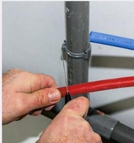
**5** L'alimentation de l'évier en eau chaude et en eau froide est réalisée avec des tubes PER. Coupez-les à la longueur voulue avec la lame d'un cutter.
