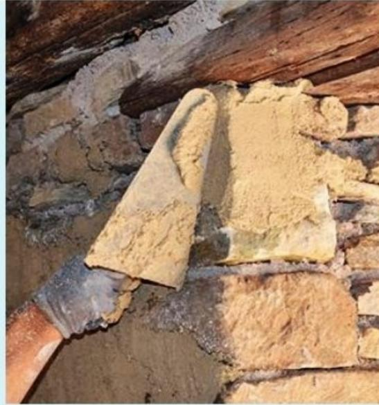
**6** À la truelle, déposez ou étalez l'enduit là où il n'était pas possible de le projeter : arête d'un tableau de baie, angle de mur, prises...
