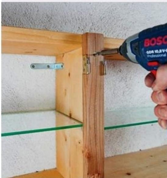
**19** Soutenus par un tasseau, ils sont aussi fixés au mur par des équerres métalliques. Les chants reçoivent les parties femelles des paumelles. Ajustez leur position puis vissez-les.
