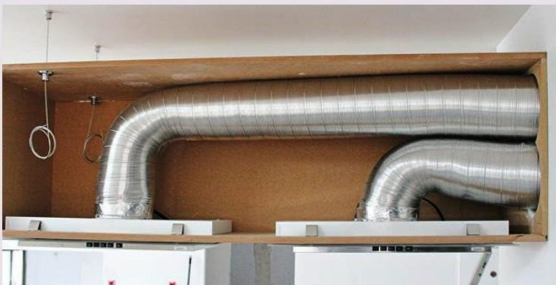
**29** Découpez l'emplacement des hottes à extraction dans le dessous du caisson. En raison du poids des hottes, fixez ce dernier à l'aide d'équerres aux joues et à la face arrière. Intégrez et raccordez les hottes. Fermez le caisson en collant et vissant le panneau frontal.
