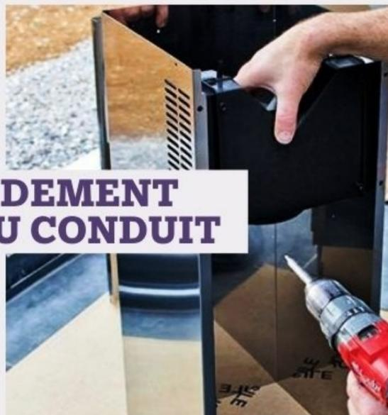
**16** Laissez (ou retirez comme ici) l'accessoire de connexion de la gaine d'évacuation suivant votre configuration. Ici, la hotte choisie est en mode filtrant et non à extraction.
