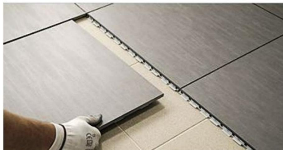
Le **carrelage sans colle** permet d'habiller un sol rapidement. Il existe en version à clipser avec joint intégré et en version à poser sur une sous-couche scratch. Dans ce cas, les joints se réalisent au mastic acrylique blanc ou d'une couleur assortie aux carreaux.
