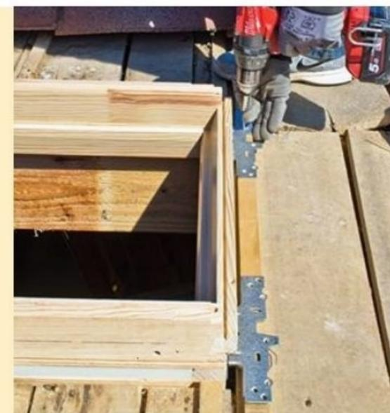
**10** Ajustez le nouveau châssis sur les liteaux par rapport à la trémie puis, à chaque angle, vissez ses pattes de fixation sur les liteaux cloués en toiture.
