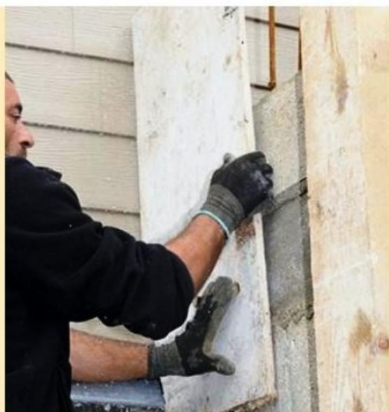
**6** Ici la maison est mitoyenne. Aux extrémités de la dalle, les angles sont coffrés afin de retenir, entre le mur et la planelle d'extrémité, le béton qui sera coulé.
