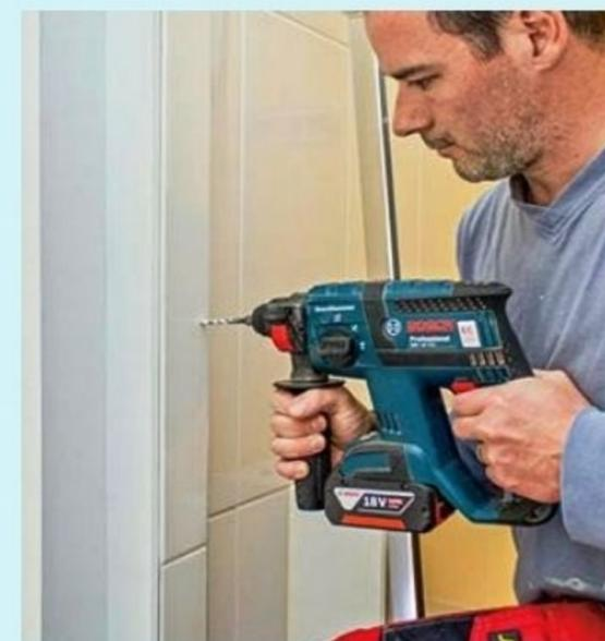
**9** À la perceuse équipée d'une mèche à béton (ou à verre), percez sans percussion le carrelage. Chevillez selon la nature de la cloison.
