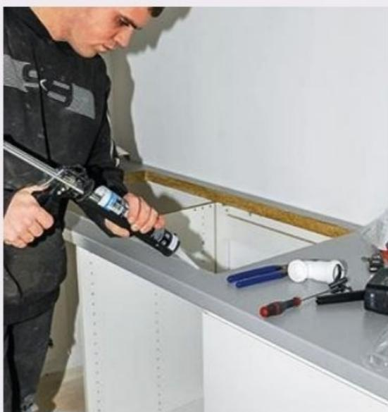
**12** De la même façon, déposez un cordon de mastic silicone sur le plan de travail sur le pourtour supérieur de la découpe, pour réaliser le joint d'étanchéité.
