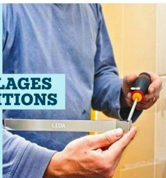
**16** Dans les trous prévus sur la porte vitrée, vissez la poignée extérieure en installant les pièces en caoutchouc prévues et fournies.
