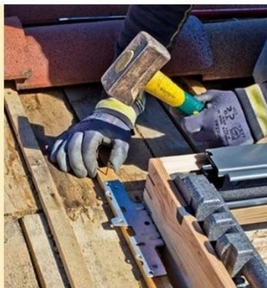
**9** Placez le châssis fixe dans la trémie sur de nouvelles sections de liteau que vous glissez sous les pattes de fixation et que vous clouez dans la volige.
