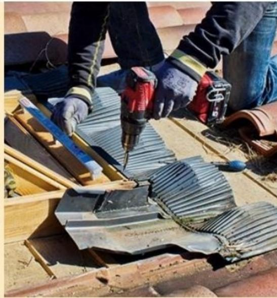
**2** Retirez l'ensemble des accessoires de raccordement d'étanchéité (profilés d'écoulement d'eau, bavette plissée...) à l'aide d'une visseuse, puis dépoussiérez les alentours.
