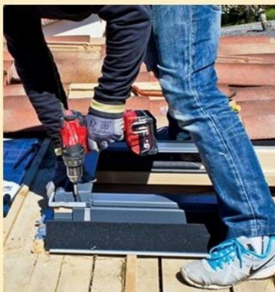
**11** Suivez scrupuleusement les indications de la notice pour poser les premiers accessoires d'étanchéité (profilés d'écoulement d'eau, raccords...) autour du châssis. Maintenez-les en place en clouant sur les liteaux latéraux les pattes en zinc fournies.
