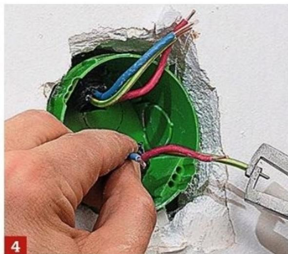
**4** À l'aide d'une pince, dénudez les six fils sur environ 3 mm. Vous ne devez pas entamer l'âme du fil avec la pince : une petite vis permet de bloquer les mâchoires.
