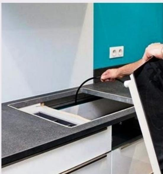
**20** Glissez le câble électrique dans le vide sanitaire (à l'arrière du meuble). Insérez la plaque dans la découpe sans endommager le joint. Vissez les pattes de serrage sous la plaque.
