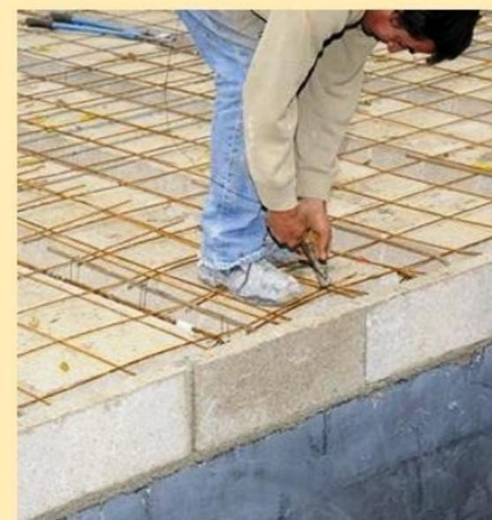
**9** Les panneaux de treillis soudés sont ligaturés entre eux avec du fil d'acier recuit ( $\varnothing$  0,8 mm). Ce ferrailage assure la solidité et la résistance de la future dalle.
