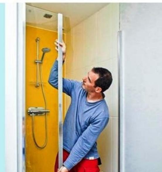
**12** Avec précaution, insérez dans le montant opposé fixé dans la cloison en plâtre, le cadre de la paroi fixe vitrée.
