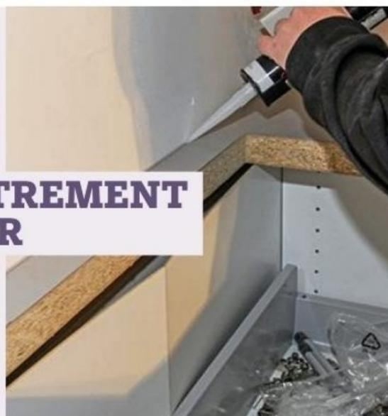
**10** Découpez l'emplacement de l'évier dans le plan de travail. Posez-le, puis réalisez le joint silicone d'étanchéité avec le mur.
