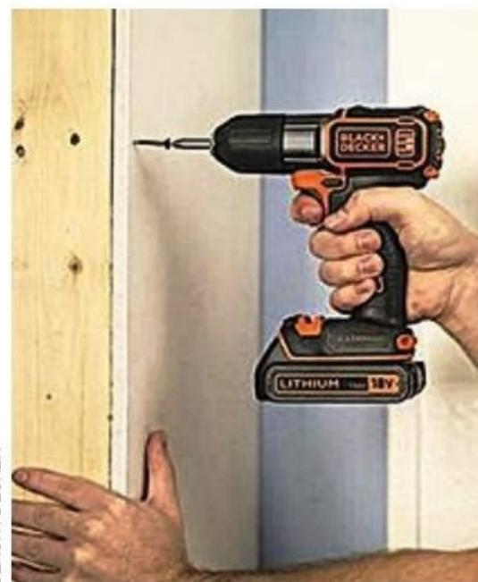
Visser une plaque de plâtre exige une certaine maîtrise pour ne pas la perforer. Une **perceuse-visseuse sensitive** à vitesse variable permet de fixer la plaque avec précision, tout en assurant un contrôle optimal de bout en bout. Elle dispose d'une lampe led intégrée, s'actionnant à la gâchette, pour travailler dans les coins sombres.
