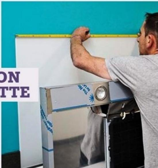
**4** Au crayon et au mètre ruban, tracez sur la cloison un repère vertical centré au-dessus de la crédence.
