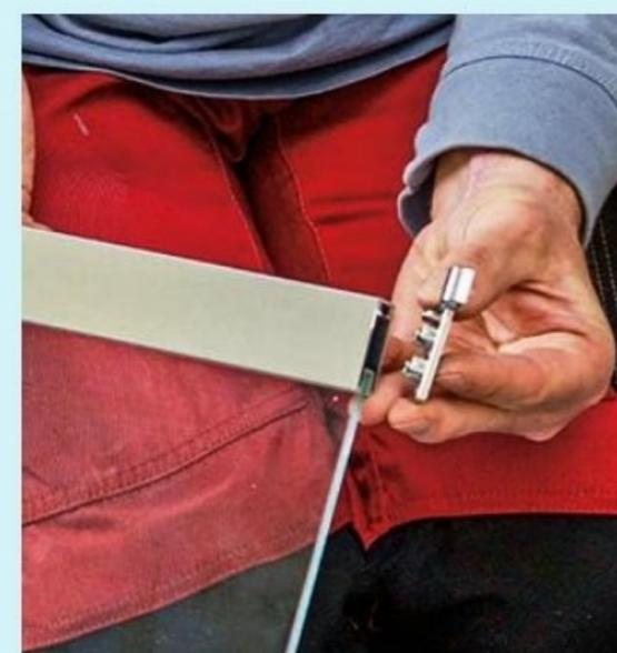
**6** En bas des montants de la paroi fixe, clipsez l'embout de finition et de la réglette d'étanchéité de sol.
