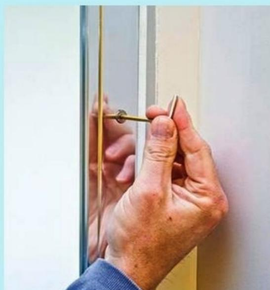
**19** Après avoir ajusté la porte et la paroi fixe sur quelques millimètres en largeur, verrouillez la fixation des montants en les vissant à l'aide de la clé hexagonale.
