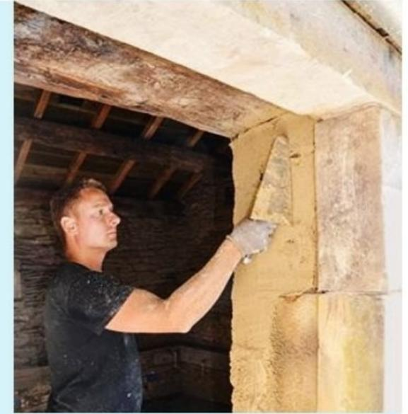
**7** Égalisez les surfaces des tableaux des menuiseries extérieures. L'enduit doit être le plus lisse possible.
