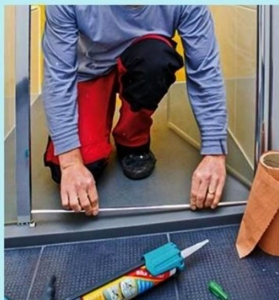
**21** Appliquez un cordon de silicone au dos de la barre d'étanchéité de sol et placez-la sur le receveur. Réalisez les joints périphériques au silicone le long des montants côté intérieur.
