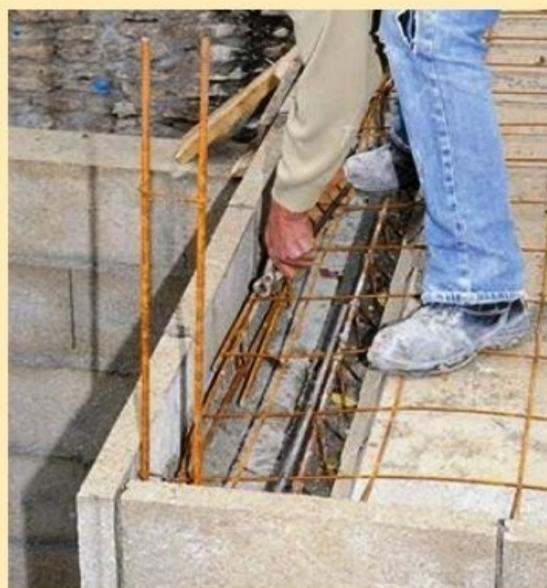
**10** Sur le pourtour de la dalle, l'armature est renforcée avec des fers de même diamètre qu'en périphérie. Ils forment un treillis et sont ligaturés entre eux comme précédemment.
