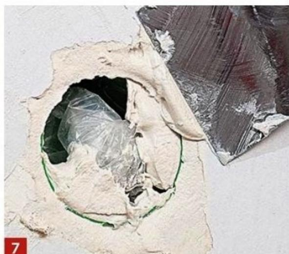
**7** Scellez le pot dans le mur, au plâtre ou à l'enduit de rebouchage. Avantage : ce dernier sèche en 24 heures, alors que le plâtre a besoin de plusieurs jours.
