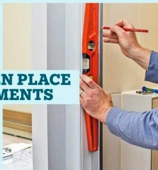
**8** À l'aide d'un mètre et d'un niveau à bulle, placez verticalement un montant contre le carrelage et repérez les trous de fixation correspondant.
