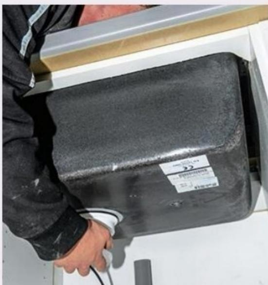
**15** Montez la bonde (par le dessus) et le siphon (par le dessous), sans oublier d'assujettir le câble de commande du clapet au siphon.
