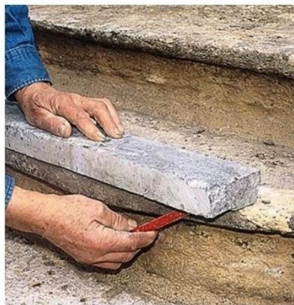
**1/** Relevez les dimensions de la partie à remplacer: reportez en sous-face du bloc de pierre de récupération la délimitation de la partie manquante, et sur la marche, la partie à purger.
