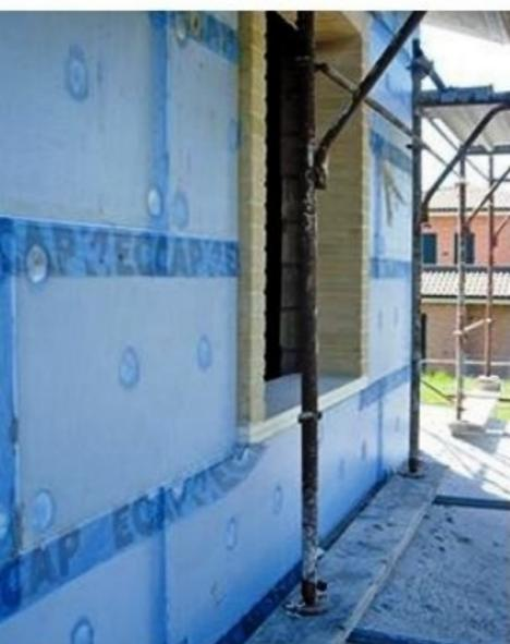
La trame et les emplacements des chevilles sont réalisés en usine ce qui facilite la mise en œuvre des panneaux. Le recouvrement assuré par l'armature débordante sur deux côtés permet un bon positionnement du système pour une durée de vie maximisée.
