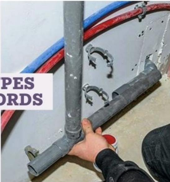
**1** Réalisez le montage à blanc du système d'évacuation en tube PVC issu du bac. Ce positionnement permet de déterminer les coupes à réaliser.
