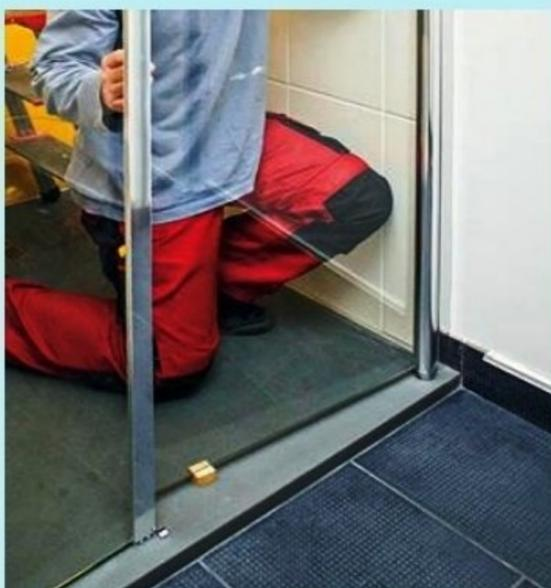
**14** Positionnez la porte sur le pivot du bas tout en insérant son montant dans celui fixé au mur. Utilisez la cale en bois fournie.
