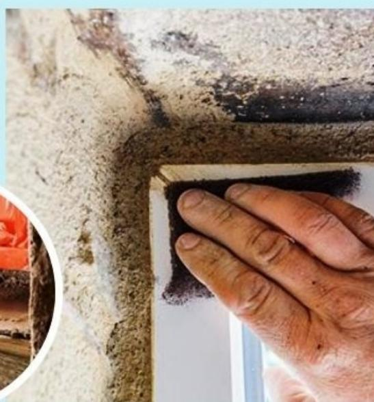
**14** Pendant le séchage de l'appui de baie, lissez à l'éponge humide l'enduit déposé sur le pourtour du dormant. Retirez l'adhésif de protection et essuyez les éventuelles bavures.
