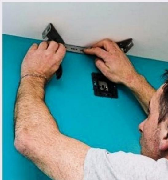
**8** Présentez contre le plafond, le dispositif de maintien du conduit de hotte centré sur le repère. Tracez au plafond l'emplacement des quatre trous de fixation.
