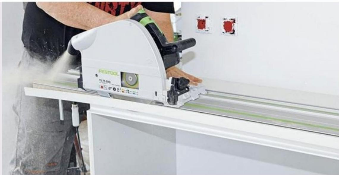
**20** Selon les besoins de rangement, rien n'interdit de raccourcir la profondeur de certaines étagères. Le meilleur outil pour réaliser cette opération est la scie circulaire équipée d'un rail de guidage.
