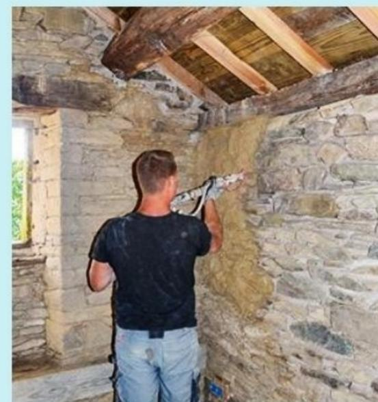
**4** Réglez le débit d'air pour obtenir une consistance moyennement pâteuse. Projetez l'enduit en passes parallèles, horizontales puis verticales sur une surface d'environ 1 m<sup>2</sup>.
