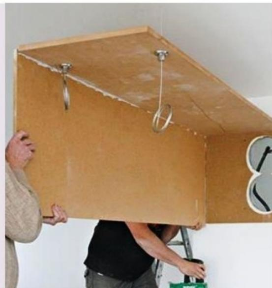
**28** Collez et vissez les panneaux (dessus + arrière) face contre chant. Après séchage, fixez l'ensemble sur la joue murale. Réglez l'horizontalité avec les câbles de suspension.
