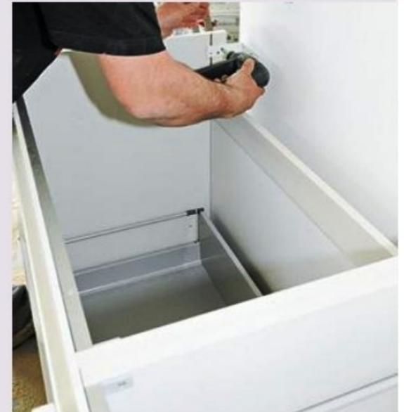
**9** Chevillez et vissez les équerres de fixation des caissons sur leur mur d'appui, puis à l'intérieur des structures.
