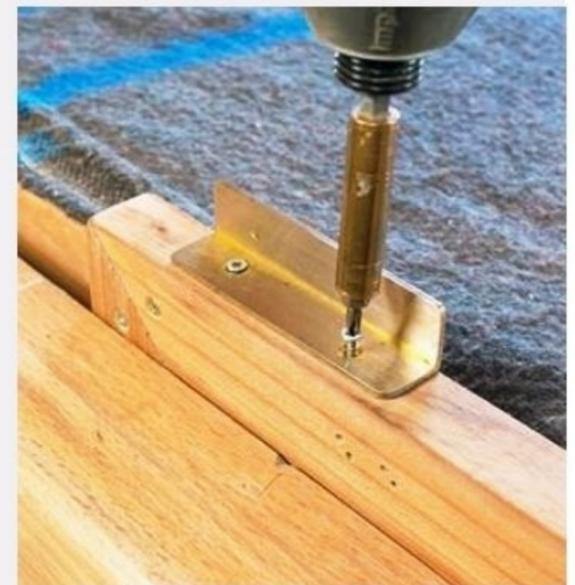
**14** Des cornières en laiton de 20 x 20 mm permettent de réaliser des poignées originales et bon marché. Vissez-les sous les traverses inférieures.
