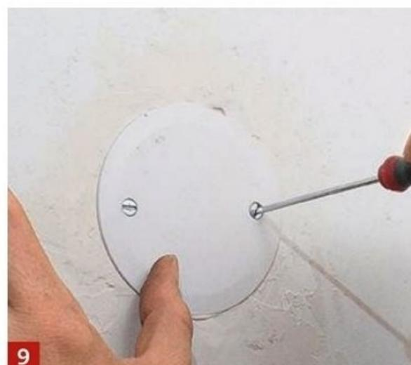
**9** Lorsque l'enduit est bien sec, vous pouvez faire une petite reprise de peinture, puis visser le cache sur le pot. Le raccord électrique doit rester visible.
