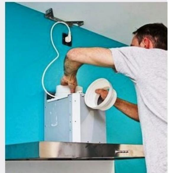
**17** Branchez le câble de la hotte sur la prise dédiée, puis placez les obturateurs en sortie de conduit pour terminer son fonctionnement en mode recyclage (filtres à charbon).
