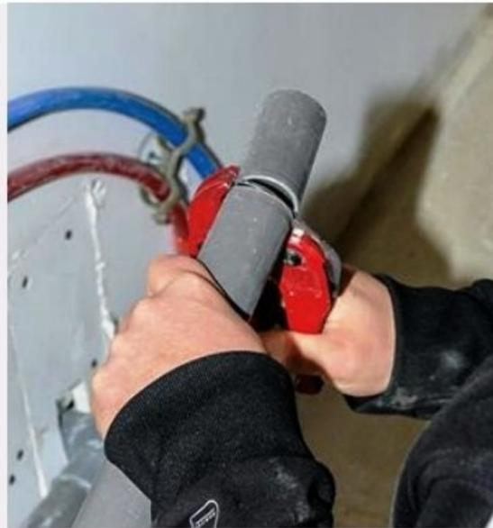
**2** Coupez à dimension les tubes à l'aide d'une pince coupe-tube ou d'une scie à métaux. Ébarbez la coupe et griffez l'extrémité du tube avec un papier abrasif.
