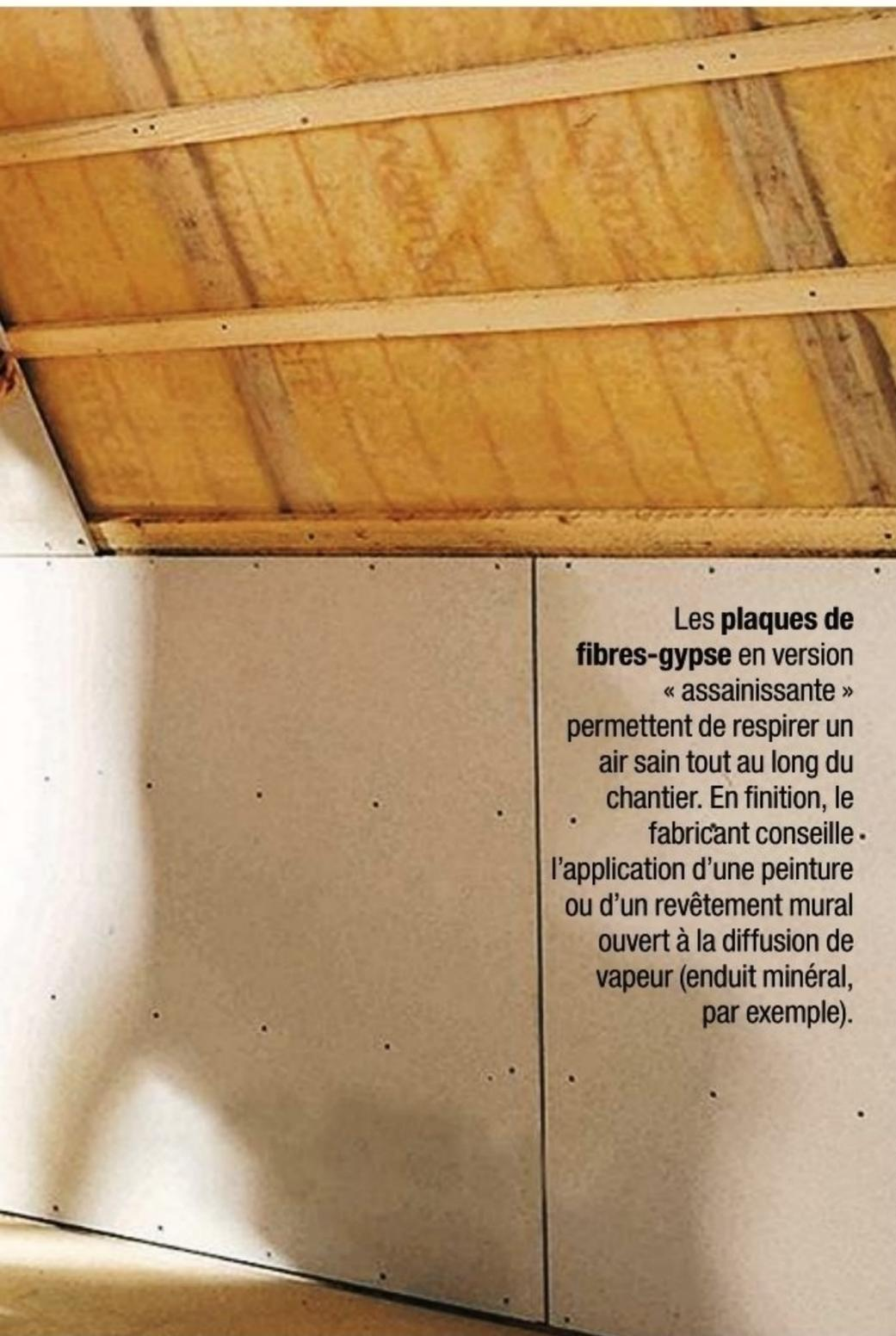
Les **plaques de fibres-gypse** en version « assainissante » permettent de respirer un air sain tout au long du chantier. En finition, le fabricant conseille l'application d'une peinture ou d'un revêtement mural ouvert à la diffusion de vapeur (enduit minéral, par exemple).
