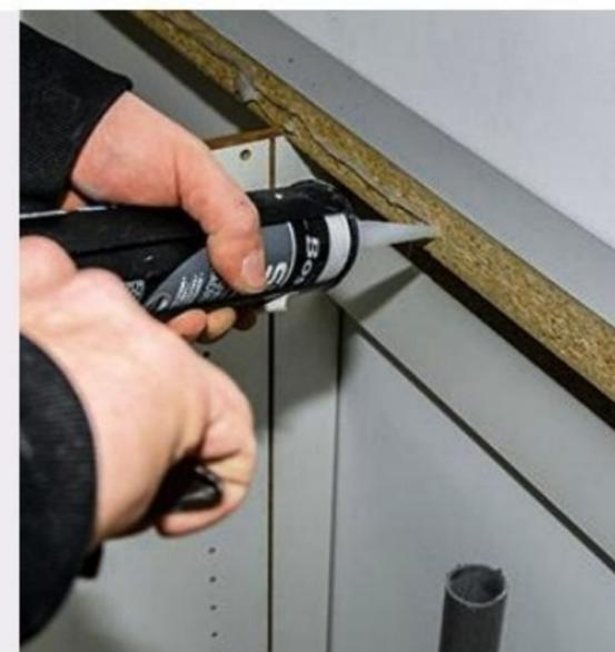
**11** Appliquez un cordon continu et régulier de mastic silicone sur le chant intérieur de la découpe prévue pour la mise en place de l'évier.
