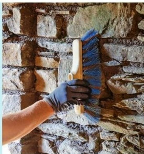
**2** Retirez les résidus du grattage avec un vieux balai à poils longs. Ou plus expéditif : à l'air comprimé (compresseur et soufflette). Portez alors des lunettes de protection.
