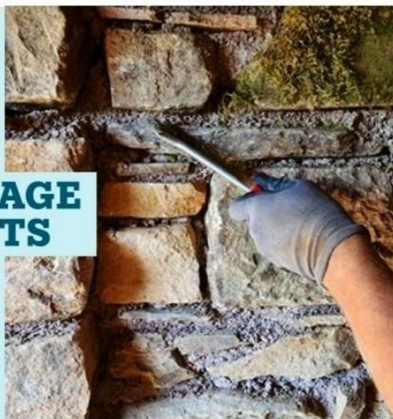
**1** Dégarnissez les joints à la brosse métallique sur 2 à 3 cm : autant pour en retirer les parties friables que pour permettre d'appliquer l'enduit sur une épaisseur équivalente.
