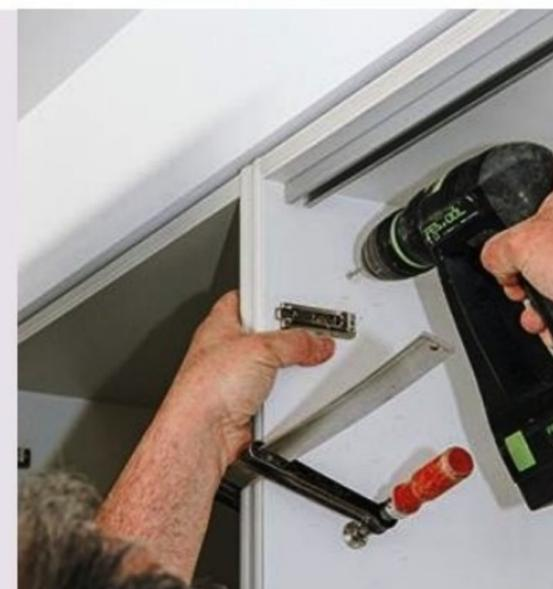
**14** Bridez les caissons avec des serre-joints. Percez quatre avant-trous (deux en haut et deux en bas) et vissez les deux caissons (fours et armoire).
