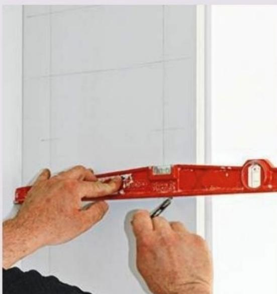
**18** Sur le premier axe, divisez la hauteur en un nombre entier d'intervalles (de 150 mm minimum). Puis, reportez les repères sur le second axe à l'aide d'un niveau à bulle.
