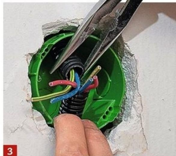
**3** Creusez le trou jusqu'à pouvoir insérer un pot d'encastrement. Positionnez-le et insérez les deux extrémités de la gaine dans les orifices, en bas et en haut.
