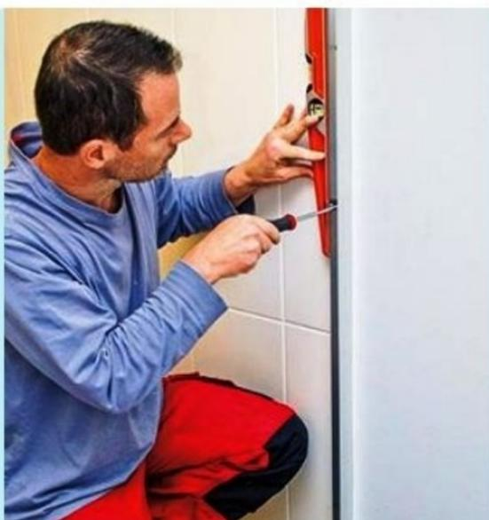
**10** Procédez de la même façon pour le deuxième montant à fixer directement sur la contre-cloison à la limite du carrelage et aligné face au premier montant.
