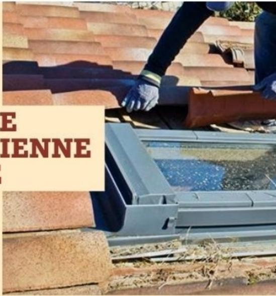
**1** Débutez la dépose en retirant un à deux rangs de tuiles en périphérie de la fenêtre de toit. Stockez-les en pile à proximité pour y avoir facilement accès lors de leur pose.
