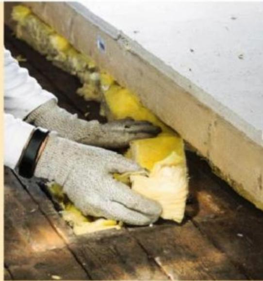
**14** Sous la passerelle, les moindres vides sont remplis avec des chutes d'isolant. Il est parfois impossible d'éviter le tassement. Il n'est pas grave tant qu'il reste ponctuel.
