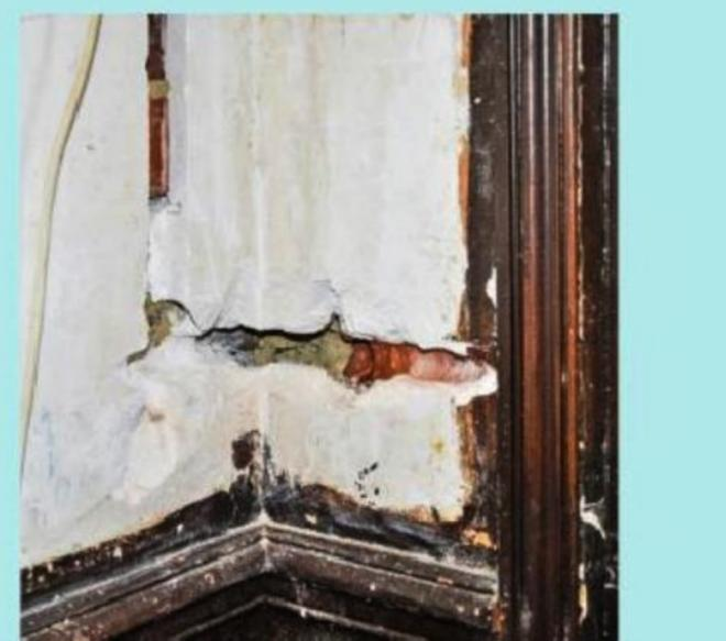
**6** Sur de courtes longueurs, comme ici près de la porte d'entrée, il est impossible d'utiliser la rainureuse. La saignée est donc creusée directement avec le perforateur et le burin.
