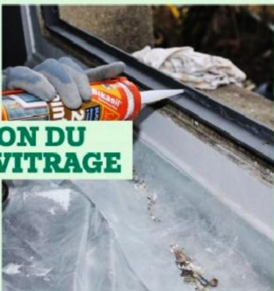
**16** Déposez un cordon de mastic-silicone sur l'aile interne des profilés du châssis. Un cordon assez fin est suffisant, mais il doit être continu pour faire barrage à l'eau ruisselant sur le vitrage.
