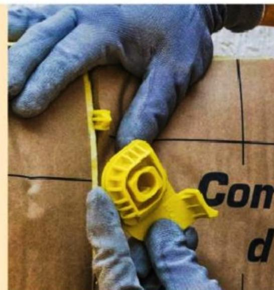
**12** Au fur et à mesure de l'avancée, placez des clés de verrouillage sur les appuis intermédiaires pour maintenir l'isolant contre le mur.
