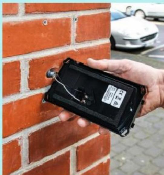
**19** Repérez l'emplacement des fixations de la platine de rue. Percez et chevillez. Raccordez les conducteurs noir et blanc au dos de la platine à l'aide des vis présentes.
