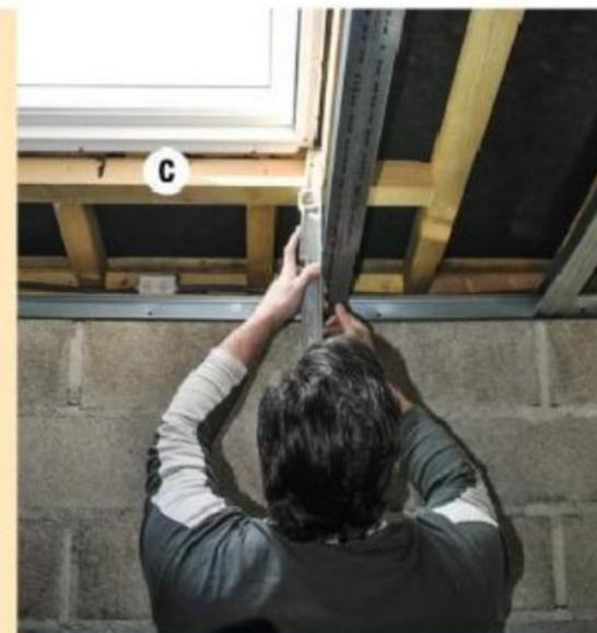
**8** L'ossature s'aligne aussi sur les chevrons qui délimitent le chevêtre (C) de la fenêtre de toit. À chaque étape, utilisez un niveau à bulle pour vérifier l'aplomb.
