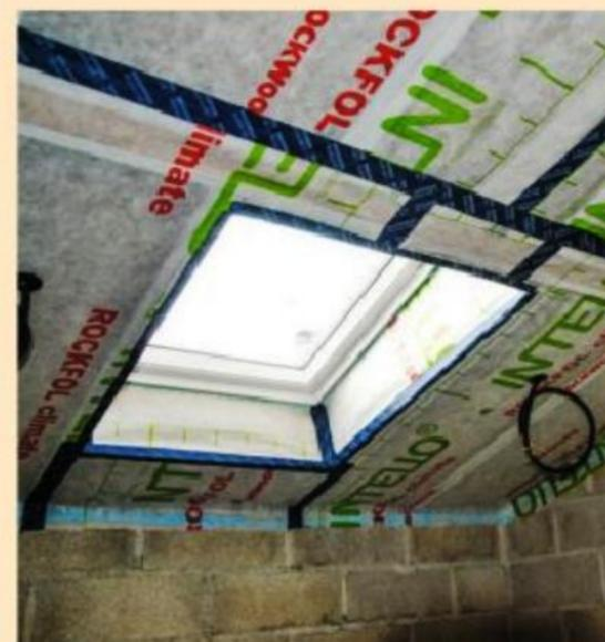
**24** Terminez l'étanchéité à l'air en appliquant aux angles sortants et rentrants de la fenêtre de toit l'adhésif d'étanchéité à l'air.
