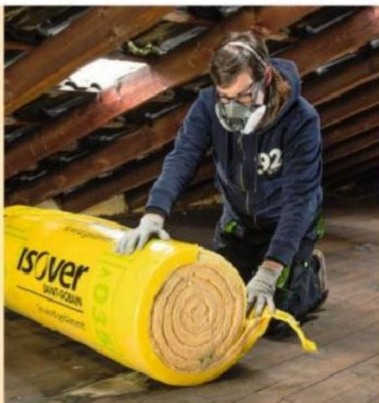
**5** Équipé d'un masque spécial fibres, déroulez l'isolant. Coupez des tronçons représentant la largeur entre solives, augmentée de 3 cm. Utilisez un couteau adapté ou « déclassé ».
