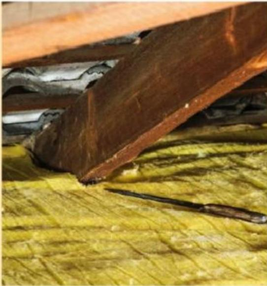
**13** La découpe des points singuliers n'est pas toujours aisée à réaliser. Ici, la partie basse d'un chevron porteur est encastrée dans la laine, tranchée in situ au couteau ou au cutter.
