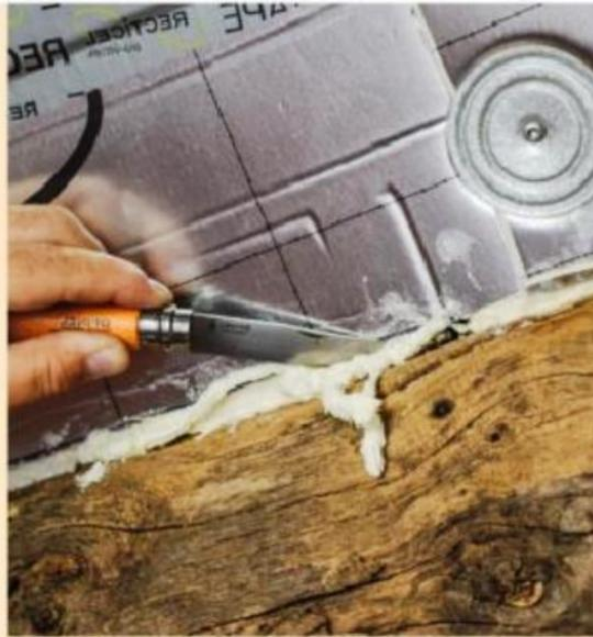
**12** Après séchage, il n'y a plus qu'à couper les débords de mousse avec un couteau ou un cutter. Si besoin, les manques peuvent être rattrapés avec une nouvelle injection.
