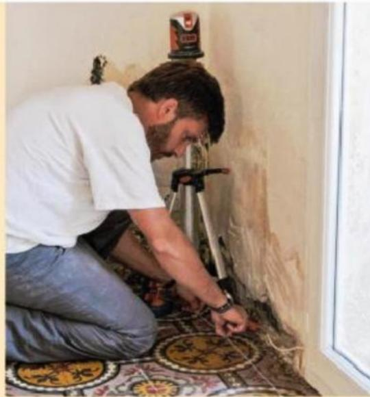
**2** Suivant l'épaisseur de l'isolant, placez un niveau laser à une extrémité de la contre-cloison à réaliser. Au cordeau à tracer, marquez le repère de pose des lisses (sol et plafond).
