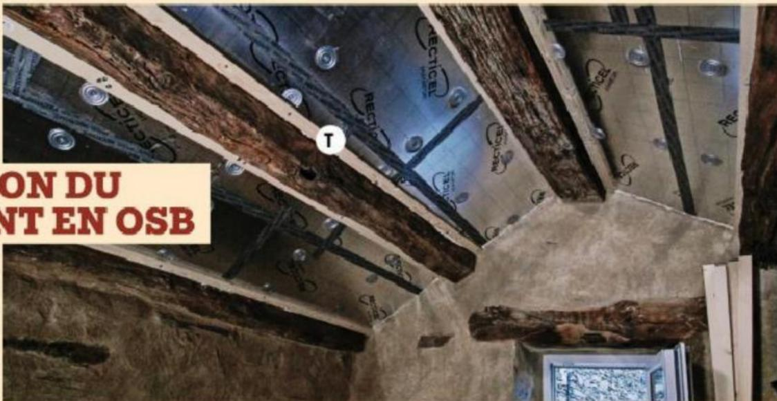
**13** Découpez des tasseaux (T) de 30 mm d'épaisseur et fixez-les de part et d'autre des pannes avec des vis traversantes suffisamment longues (150 mm) pour atteindre les chevrons. Pour éviter tout risque d'erreur, repérez-vous sur les fixations des panneaux d'isolant, eux-mêmes vissés sur les chevrons (voir photo 8).
