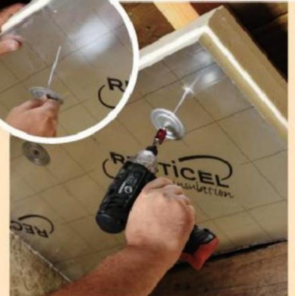
**3** Présentez un premier panneau parallèlement à la pente et fixez-le de façon provisoire avec une vis préalablement montée sur une rondelle.
