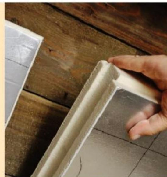
**7** Les panneaux sont rainurés bouvetés sur les quatre côtés. Il suffit donc de les enclencher soigneusement pour obtenir une étanchéité presque parfaite.
