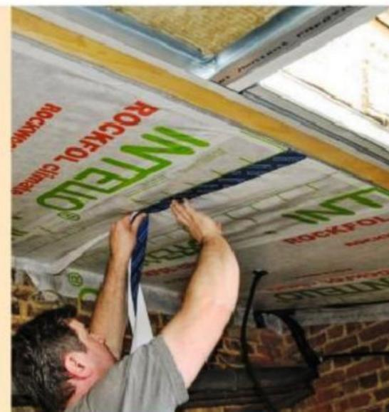
**19** Pour qu'une membrane soit efficace, elle doit être étanche à l'air... Collez la jonction entre les lés à l'aide d'un adhésif spécifique aux membranes d'étanchéité à l'air.
