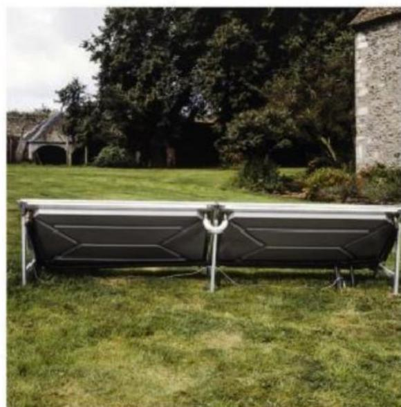
**6/** Les capteurs reposent ici au sol sur des supports en acier galvanisé qui leur donnent une inclinaison de 45°. Il faut les lester ou les sceller pour éviter tout risque de déplacement.
