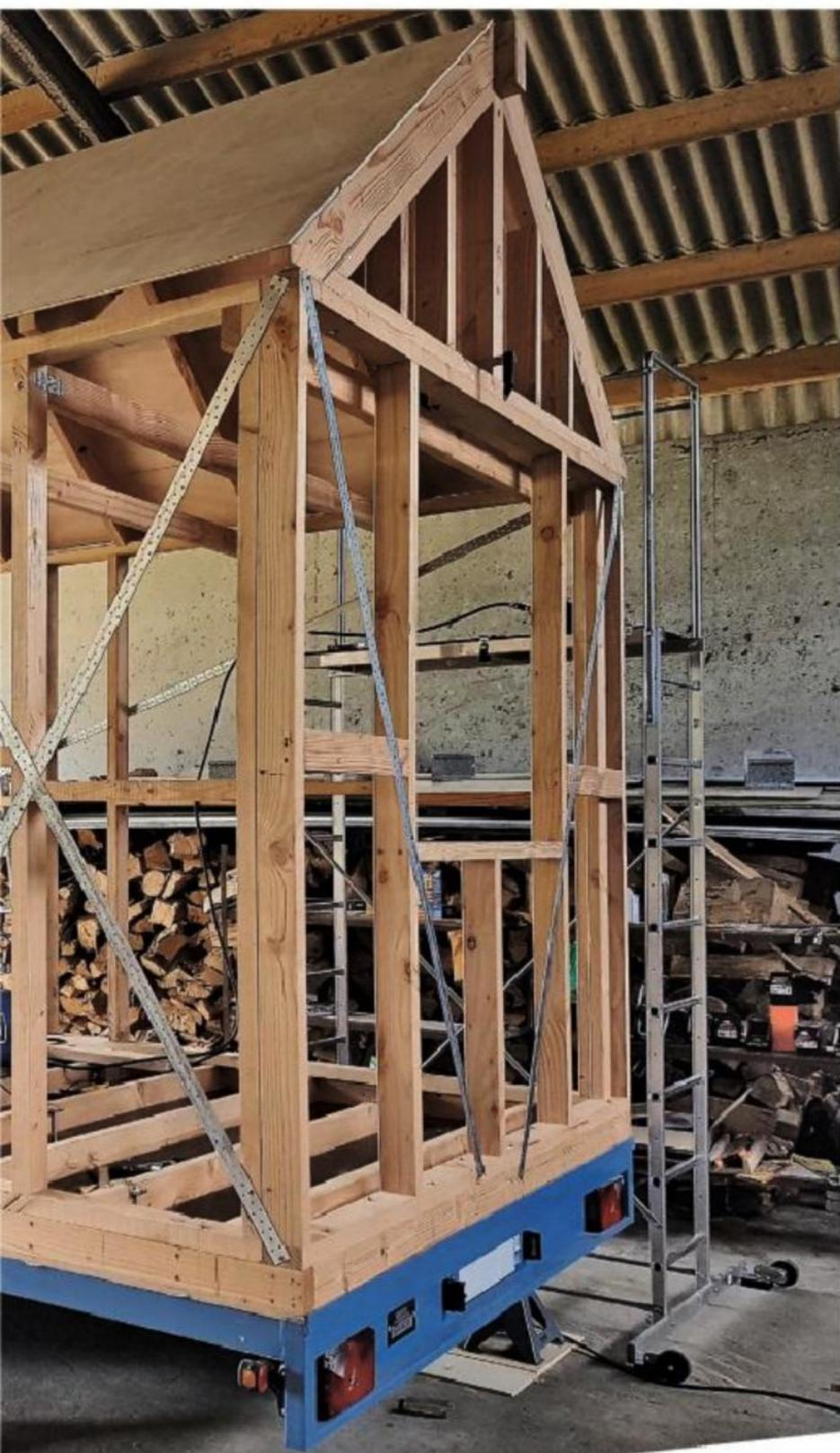
La fabrication des murs à ossatures bois et de la charpente est achevée. Les feuillards métalliques (contreventement des parois) y ont été solidarisés avec des petits tirefonds, puis tendus à l'aide de cliquets.
