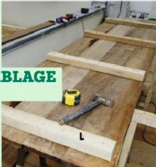
**1** Vissez quatre lambourdes (L) en Badi de 60 cm de façon à lier quatre lames de terrasse avec des vis inox 4,5 x 55. Laissez 7 cm entre le bord des lames et les lambourdes d'extrémité.
