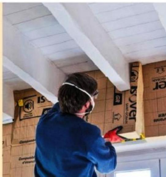
**11** Poursuivez la pose en empilant les panneaux les uns sur les autres sans croiser les joints jusqu'à atteindre le plafond. Découpez au ras des poutres et des tableaux de fenêtres.
