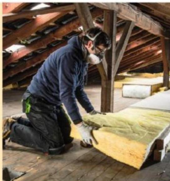
**6** Insérez les panneaux entre les chevrons en tassant pour empêcher les ponts thermiques. Les fuites de calories génèrent des zones de condensation en sous-face.
