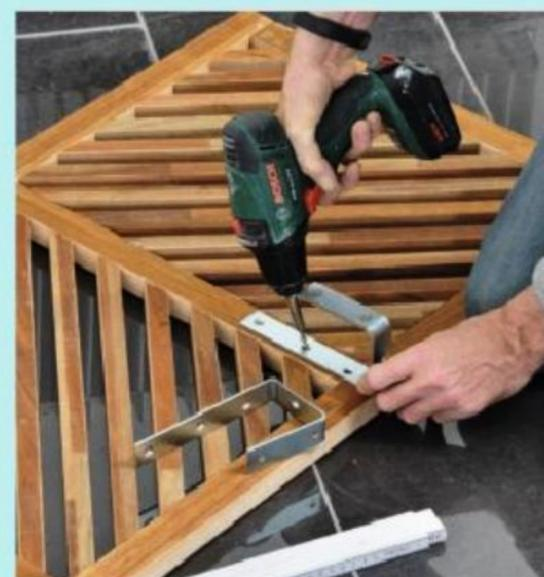
**6** Une autre solution consiste à acheter des équerres adaptées. Fixez les équerres reconverties en crochets sur les montants intermédiaires (trois vis de 4 x 20 mm).
