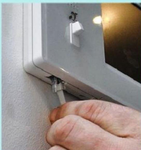
**16** Le poste installé, il ne vous reste plus qu'à raccorder le câble du combiné au moniteur. La prise (ou connecteur) RJ 11 se trouve en dessous, dans l'épaisseur du moniteur.
