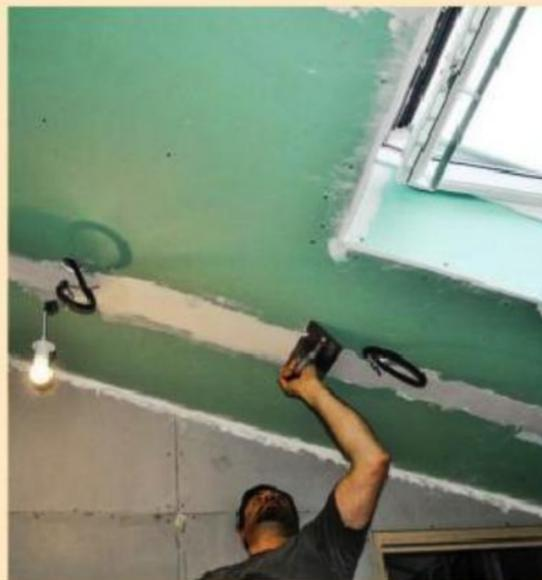
**30** Après séchage, appliquez une seconde passe plus large. Laissez sécher et poncez (grain 120). Enduisez les têtes des vis et les joints des plaques.
