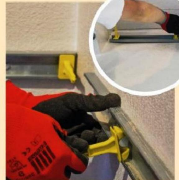
**6** Insérez les appuis intermédiaires dans les fourrures au mur en respectant un entraxe de 60 cm entre chaque appui. Installez-en entre les poutres du plafond si besoin.
