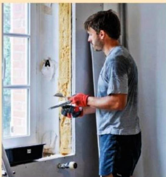
**15** Autour de la fenêtre, déposez des plots de mortier adhésif (A) sur la maçonnerie, puis pressez une plaque de plâtre dans le frais. Vissez-la dans la tranche de la fourrure contiguë.
