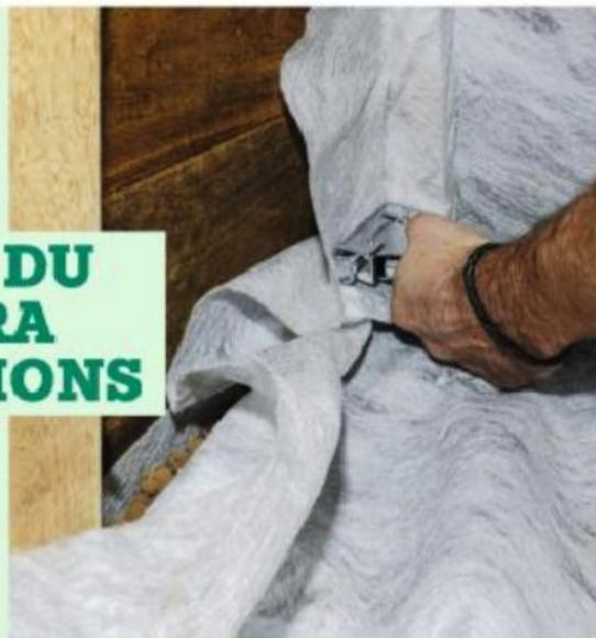
**15** Déroulez un film géotextile à l'intérieur de la jardinière : enveloppez tous les éléments de façon à ce que le film ne soit pas tendu dans les angles. Fixez avec des agrafes de 10 mm.
