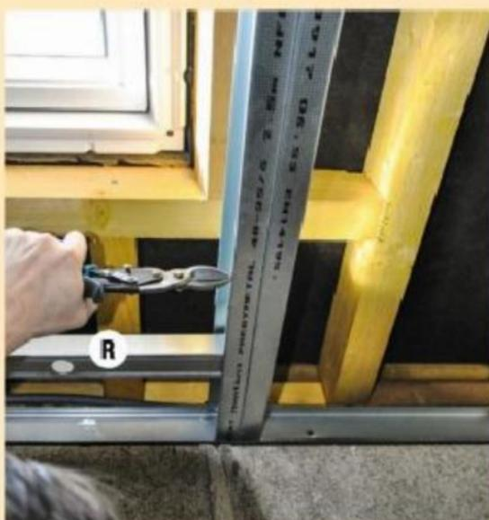
**9** À certains endroits, comme ici autour du chevêtre, il est nécessaire d'ajouter des renforts (R) transversaux. Ces chutes de montants obligent à tricher un peu pour les emboîter dans les montants (de même section). Entaillez l'aile des montants à la cisaille et aplatissez sa lèvre à la pince pour enfiler les renforts à l'intérieur.
