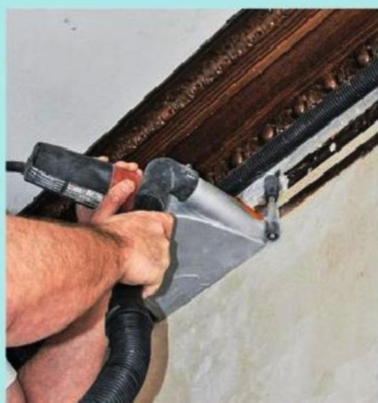
**4** Tracez les trajectoires des câbles et utilisez de préférence une rainureuse pour creuser la saignée. Raccordez l'outil à un aspirateur de chantier pour limiter les poussières.
