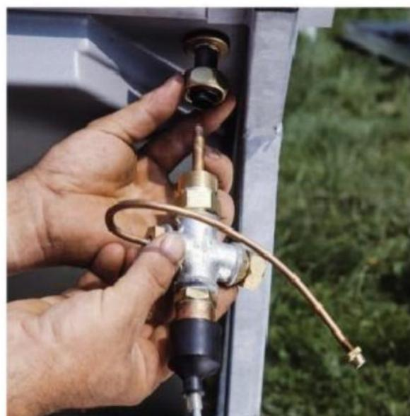
**4/** Entre les deux canalisations de cuivre (séparées par 20 cm) se trouve celle de la sonde de régulation, raccordée à la tubulure de sortie du capteur. Ce dernier comporte un purgeur dégazeur.
