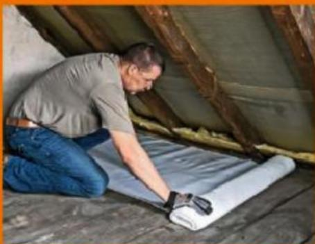
Étalez un film microporeux à même le sol d'origine pour réguler les transferts d'humidité. La couche finale risque de créer des zones humides en concentrant la condensation.
