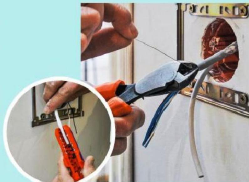
**12** Dégainez sur 10 à 15 cm les câbles parvenant à l'un des postes intérieurs. Supprimez à la pince coupante l'écran métallique (et le fil de masse) que contient le câble.
