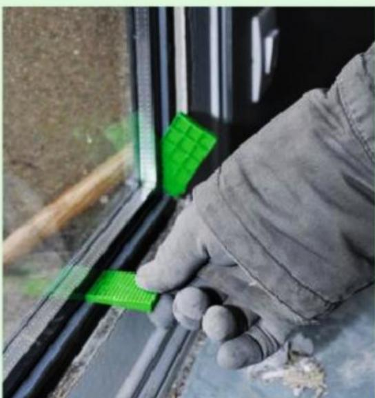
**18** Après 24 h, retirez les cales. Taillez de nouvelles parcloses dans des moulures assez larges pour recouvrir les feuillures du châssis et le pourtour du double vitrage.
