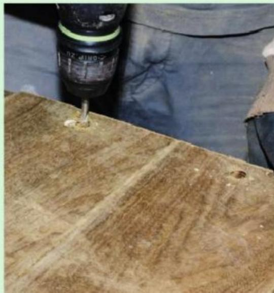
**5** Les côtés de la jardinière assemblés, prépercez chaque lame avec une mèche à bois  $\varnothing$  3 mm à 25 mm du bord après un fraisage  $\varnothing$  10 mm pour enfoncer la tête de vis.
