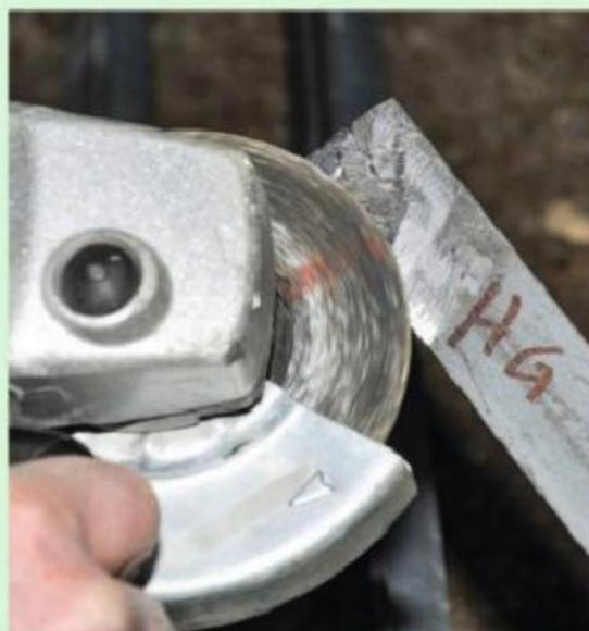
**10** Côté extérieur du châssis, le meulage des cordons de soudure n'a qu'une finalité esthétique. Côté intérieur en revanche, cette opération doit permettre aux profilés de plaquer correctement contre le cadre en bois. Mais vu la difficulté de rectifier des cordons à l'intérieur du cadre à la meuleuse, aucune soudure n'est prévue à cet endroit.
