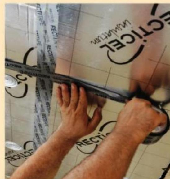
**10** Bien que les panneaux soient rainurés bouvetés, une bande d'adhésif vient parfaire l'étanchéité.
