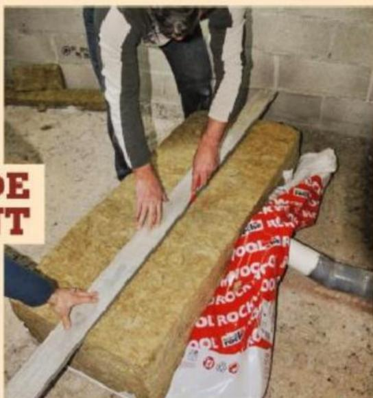
**12** Les panneaux de la première couche devant être légèrement comprimés entre les chevrons, majorez-les de quelques millimètres.
