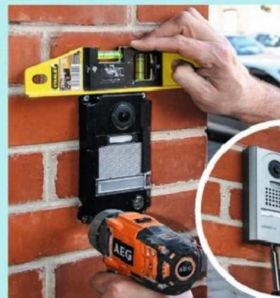
**20** Vérifiez l'horizontalité au niveau à bulle. Emboîtez ensuite la façade de la platine, sans oublier de serrer la vis de retenue par-dessous.
