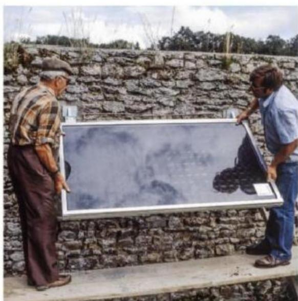
**7/** Sur une paroi verticale (mur ou façade), après fixation des supports en acier, un échafaudage permet une pose du panneau à bonne hauteur. Il faut se faire aider pour cette opération.
