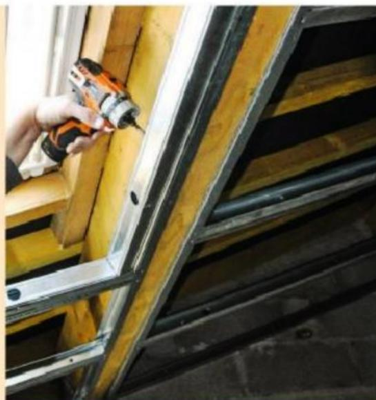
**11** Au-dessus de la fenêtre, un M48 est vissé dans le rail présent (dos du montant dans le fond du rail), puis « fermé » avec un second M48. Cela peut suffire, mais ici, l'opération est répétée une seconde fois afin de pouvoir s'aligner sur la traverse haute du chevêtre (voir schéma p. 32).
