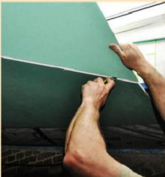
**27** Autour de la fenêtre de toit, recoupez la plaque grossièrement au cutter (pour faire un peu de place), puis plus finement à la scie en suivant le contour du chevêtre.
