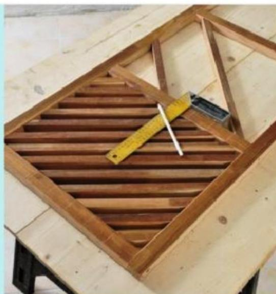
**2** Préparez les tasseaux recoupés à dimensions et d'onglet (angle 45°) à la scie radiale. Posez-les à blanc. L'écart entre les tasseaux de 20 x 26 mm doit être régulier.
