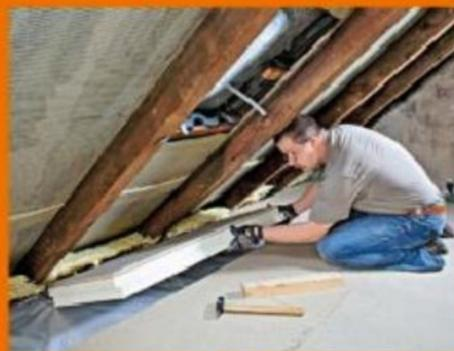
Les panneaux s'assemblent grâce à des feuillures. Les chants des plaques de surface sont encollés ou scotchés pour lier l'ensemble, sans vissage ni clouage.
