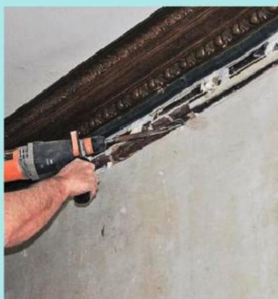
**5** La rainureuse ne découpe que les bords de la saignée. Utilisez un perforateur (en mode percussion) équipé d'un burin gouge pour ouvrir la saignée et la creuser plus profondément.
