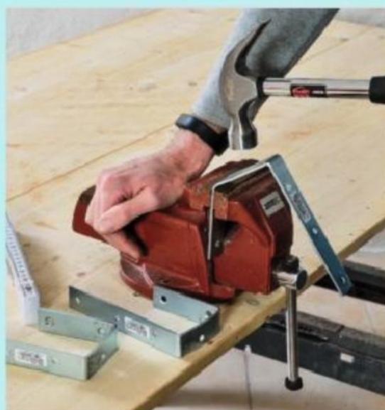
**5** Pour fixer le cache, pliez des équerres de 30 x 150 x 150 mm de façon à former des crochets à ajuster à l'épaisseur du radiateur. Utilisez un étau et un marteau.
