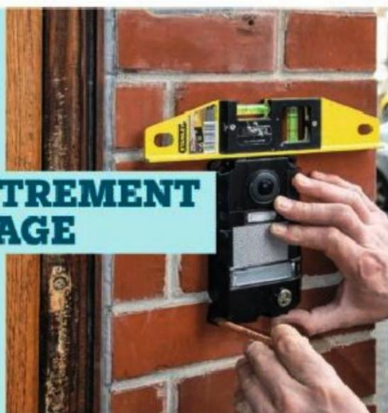
**1** Repérez l'emplacement de la platine de rue à 1,50 m du sol. Percez en biais (Ø 10 mm), puis au diamètre définitif (25 mm). Contrôlez au niveau à bulle.
