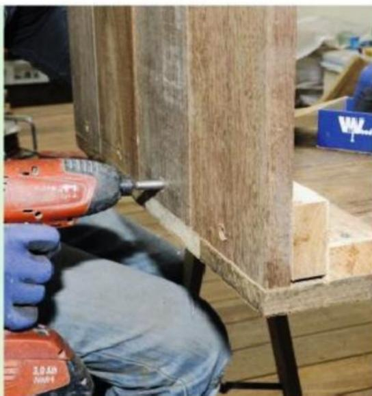
**7** Vissez le côté avec des vis inox 4,5 x 90. Pour l'ajustement des lames à l'angle, décalez la lambourde de 3 mm par rapport au bout des lames. N'enfonchez pas trop les vis.
