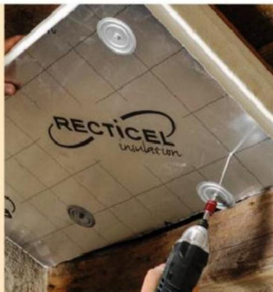
**6** Après avoir réalisé les découpes, présentez le panneau d'isolant et fixez-le dans les chevrons à l'aide de quatre vis préalablement équipées de rondelles métalliques.
