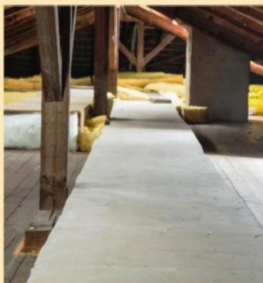
**9** La passerelle est solide, et permettra de circuler sans endommager l'isolant. Ne serait-ce que pour le contrôle annuel de la charpente et de la couverture.
