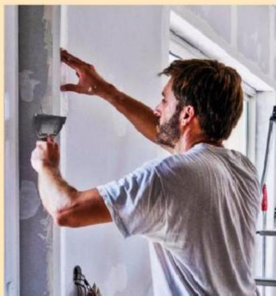
**16** Préparez l'enduit de jointoiment. Déposez des bandes à joint dans le frais de l'enduit, puis ôtez l'excédent. Posez des bandes armées dans les angles sortants pour les protéger.
