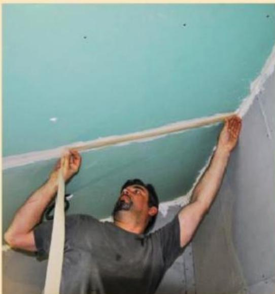
**29** Déposez de l'enduit à joint entre les plaques et appliquez la bande à joint sur l'enduit frais. Marouffez sans attendre les bandes à joints dans la première passe d'enduit.
