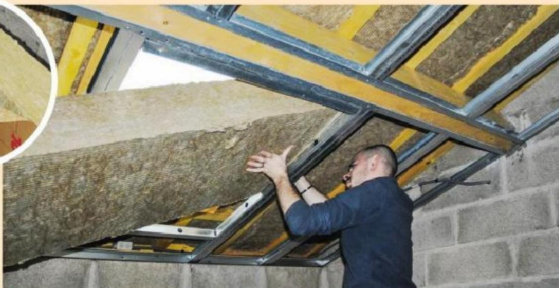
**15** Nettement plus épaisse, la seconde couche (même type d'isolant) se met en place perpendiculairement à la première. Retirez au préalable le kraft des panneaux. Celui-ci n'est pas nécessaire avec une membrane rapportée d'étanchéité à l'air.
