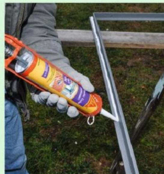
**13** Passez un l'antirouille, puis après séchage, déposez un cordon de mastic PU (polyuréthane) sur le pourtour intérieur du châssis.
