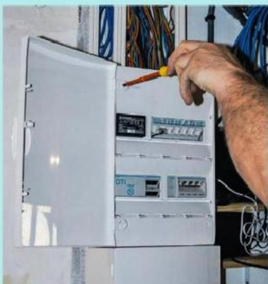
**23** Les branchements effectués, refermez le coffret du tableau électrique. Bloquez-le à l'aide des vis de fixation présentes aux quatre coins du coffret.
