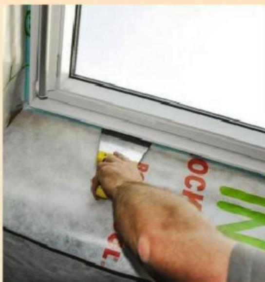
**22** Même exigence d'étanchéité autour d'une fenêtre de toit : le bord du pare-vapeur est collé au mastic dans la rainure du dormant. Aidez-vous d'un couteau à enduire large.
