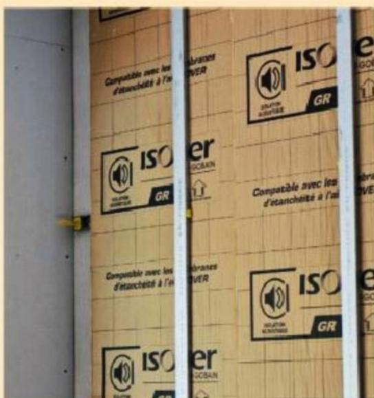
**13** Découpez et placez une fourrure dans la lisse basse et haute et clipsez-la dans les clés de verrouillage des appuis intermédiaires. Jouez sur la profondeur de vissage des clés.
