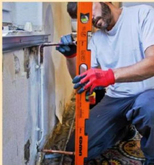
**8** Procédez de la même façon pour le tuyau de retour du chauffage. Montez les tubes et les raccords à blanc, puis vérifiez au niveau à bulle l'alignement et l'aplomb avant de braser.
