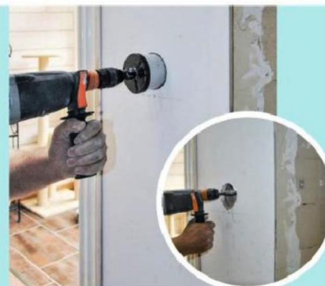
**3** Percez le logement du boîtier d'encastrement avec une scie cloche diamantée (Ø 68 mm). Puis percez en biais (foret Ø 25 mm) pour ressortir (dans la continuité de la saignée).
