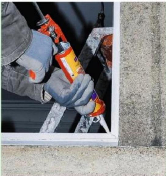
**14** Déposez un second cordon du même mastic sur le bâti d'origine, au-dessus de sa feuillure périphérique. On n'est jamais trop prévoyant vis-à-vis des infiltrations...
