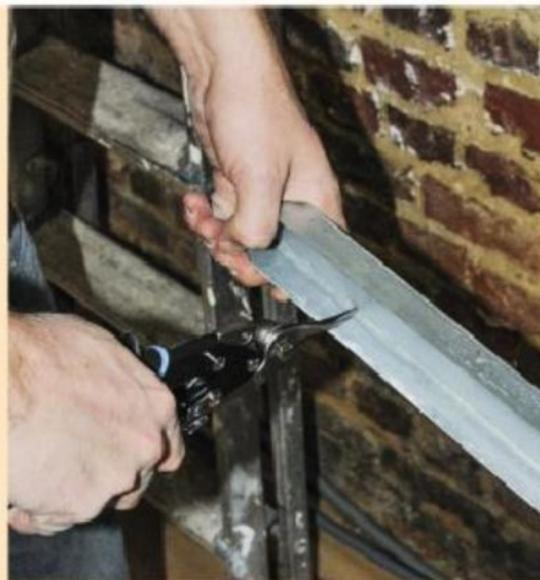
**2** Utilisez une cisaille à tôle pour raccourcir rails et montants. C'est l'outil de coupe par excellence pour une ossature. Et il ne fait pas de bruit, contrairement à une meuleuse.
