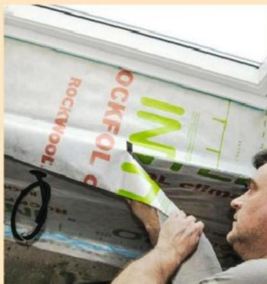
**23** Tendez la membrane, puis collez sa partie basse sur l'adhésif double face préalablement déposé sur l'ossature. Utilisez un cutter pour couper le surplus.
