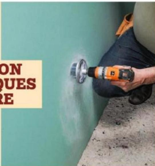
**25** Découpez les emplacements des spots à la scie cloche (Ø 75 mm) et créez les encoches nécessaires sur les côtés pour permettre le passage des gaines électriques.
