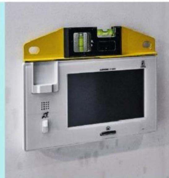
**15** Raccordez le câble Ethernet au dos du poste intérieur, puis emboîtez ce dernier sur son cadre de fixation. En cas de défaut d'horizontalité, modifiez la position du cadre.
