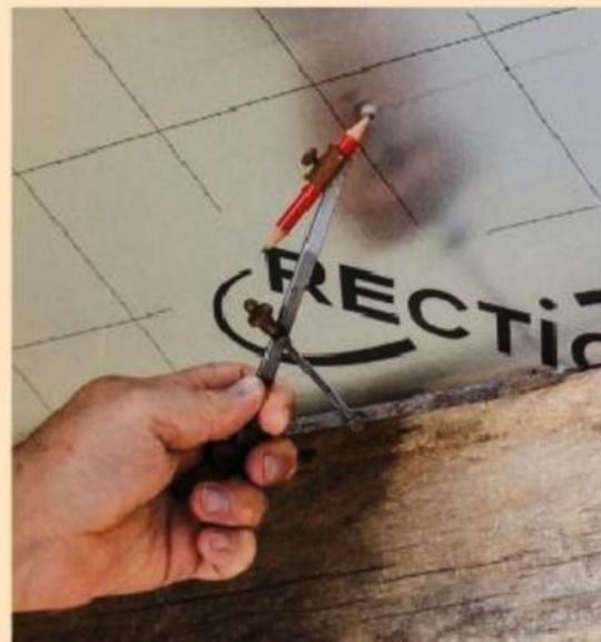
**4** Repérez les découpes à réaliser le long des pannes et des murs, en vous aidant d'un compas tenu bien perpendiculaire au panneau.
