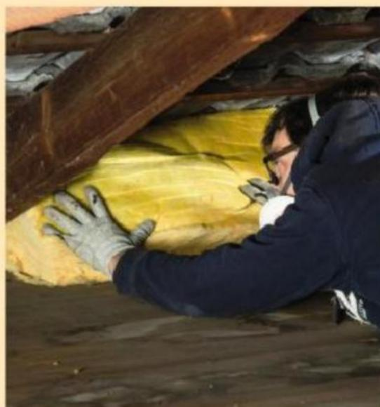
**11** Remplissez les cavités en veillant à ne pas comprimer la laine de plus d'un quart de son épaisseur. Elle ne doit pas venir au contact des éléments de couverture.
