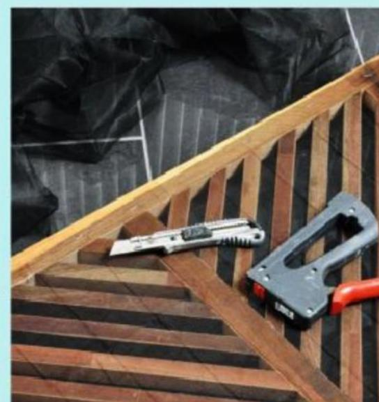
**9** La pose d'une moustiquaire sur la face intérieure du cache-radiateur permet d'éviter l'accumulation de poussières. Elle est simplement tendue et agrafée.
