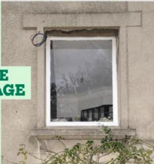
**1** Vu du sol, le bâti d'origine présente encore assez bien. Mais de près, il affiche des signes de vieillissement qui ne trompent pas : sa peinture a tendance à se craqueler, le mastic a disparu à certains endroits. Le bâti d'origine, en bois, restera en place, des pièces d'ouvrage sont fragilisées...
