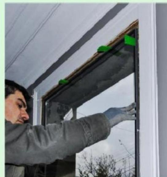
**17** Disposez deux cales biseautées sur la traverse basse du châssis. Centrez le vitrage par rapport au châssis. Ajoutez d'autres cales latéralement et terminez par la partie haute.
