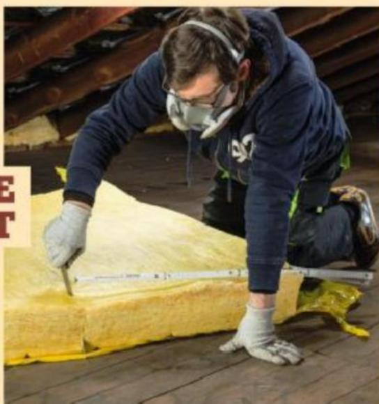
**10** Difficiles d'accès, les extrémités des soupentes doivent être traitées avec soin pour garantir la continuité de l'isolation. Découpez les morceaux sur-mesure pour chaque creux.
