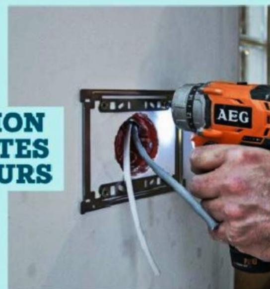
**11** Après séchage, repérez les points de fixation du poste intérieur. Percez ( $\varnothing$  6 mm), chevillez et vissez le cadre. Ajustez l'horizontalité avant de bloquer les vis.
