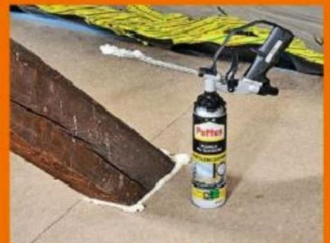
Les manques sont comblés à la mousse polyuréthane. Utilisez ce produit avec raison. En s'expansant, une trop grande quantité peut soulever les panneaux.
