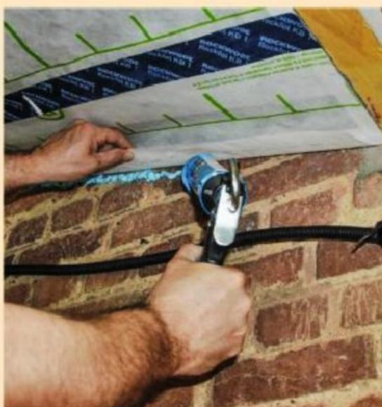
**20** En périphérie, le pare-vapeur doit déborder de 5 cm environ sur les surfaces environnantes (ici un mur pignon). Prévoyez un rabat et collez-le avec un cordon de mastic spécifique pour créer le joint d'étanchéité. Rabattez la membrane sur le joint mastic et exercez une petite pression sur toute la longueur du lé afin de le faire adhérer.
