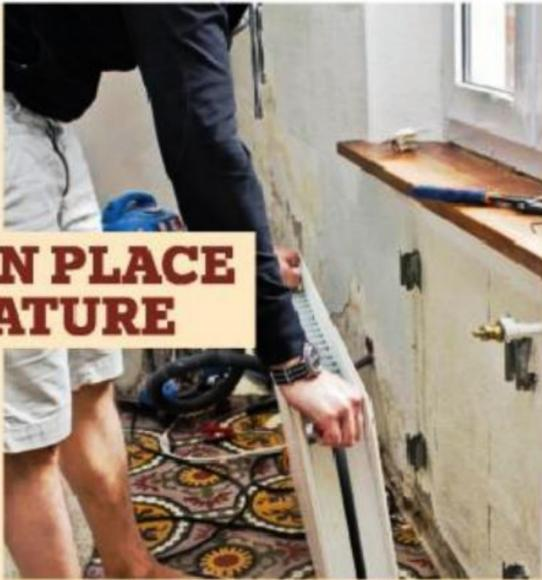
**1** Pour commencer, déposez les plinthes existantes puis vidangez le circuit de chauffage avant de démonter les radiateurs. Nettoyez le sol à l'aspirateur de chantier.
