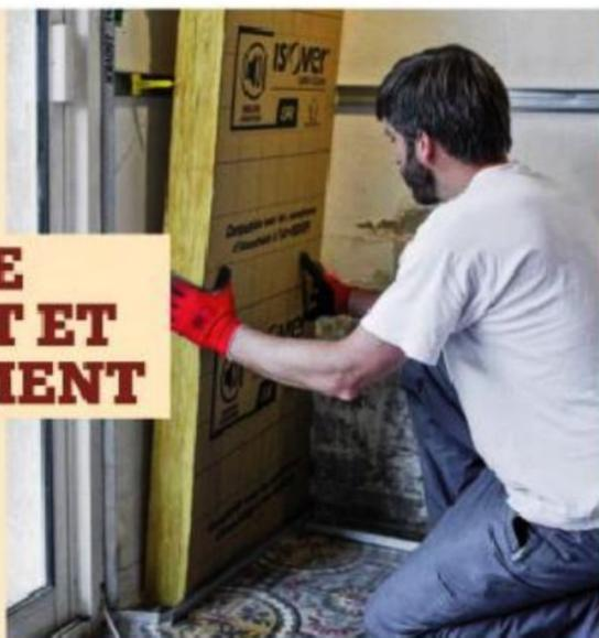
**10** Placez les premiers panneaux isolants semi-rigides, derrière la lisse au sol en les embochant dans les appuis intermédiaires. Veillez à bien les coller l'un contre l'autre.
