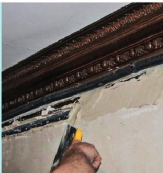
**7** Les câbles passés dans leur fourreau (gaine ICTA), déposez du plâtre (ou du mortier-colle) au fond de la saignée pour « coller » la gaine, puis recouvrez-la totalement.
