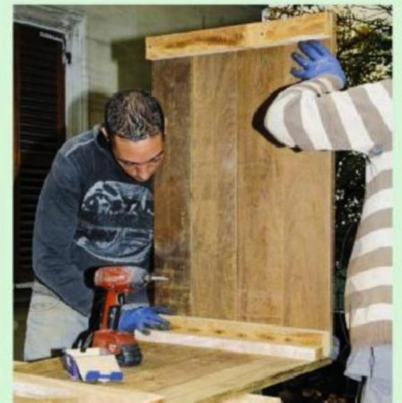
**6** Réalisez l'assemblage, lambourde contre lambourde: faites-vous aider ou utilisez un serre-joint d'angle. Ajustez les coupes pour obtenir un angle et contrôlez les équerrages.
