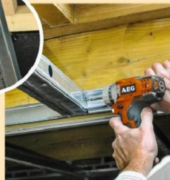
**10** De chaque côté de la fenêtre de toit, emboîtez des montants à l'intérieur des montants verticaux en place pour les « fermer ». Vissez-les par le dessus.
