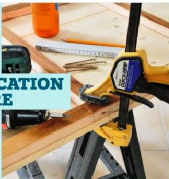
**1** Découpez les deux traverses et les montants selon les dimensions du radiateur. Bidez les pièces, puis percez les traverses Ø 5 mm pour assembler le cadre (vis 5 x 80 mm).
