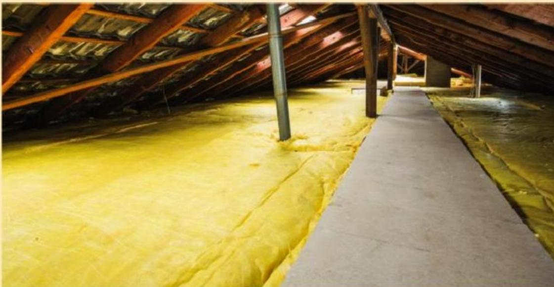
**16** L'ensemble du sol est désormais couvert d'une couche homogène (bandes jointives) qui fera réaliser de très substantielles économies de chauffage. La bande de circulation, sous le faitage, permettra de se déplacer aisément dans le comble.
