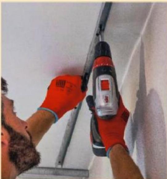
**4** Procédez de la même façon au plafond. Au niveau des poutres apparentes, fixez des sections de lisses directement dans le bois avec des vis à bois.
