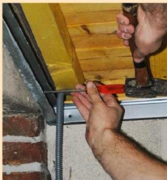
**5** Avec des chevilles à frapper, pas besoin de retirer le profilé. Équipées de leur vis, ces chevilles s'enfoncent à travers le profilé en frappant sur les têtes de vis.
