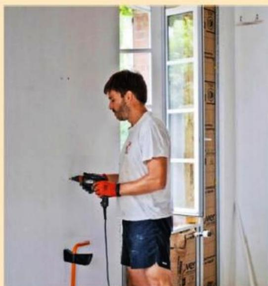
**14** Après avoir contrôlé l'alignement et l'aplomb, découpez et placez une plaque de plâtre contre les fourrures, maintenue par un cale-plaque. Vissez-la dans les fourrures.
