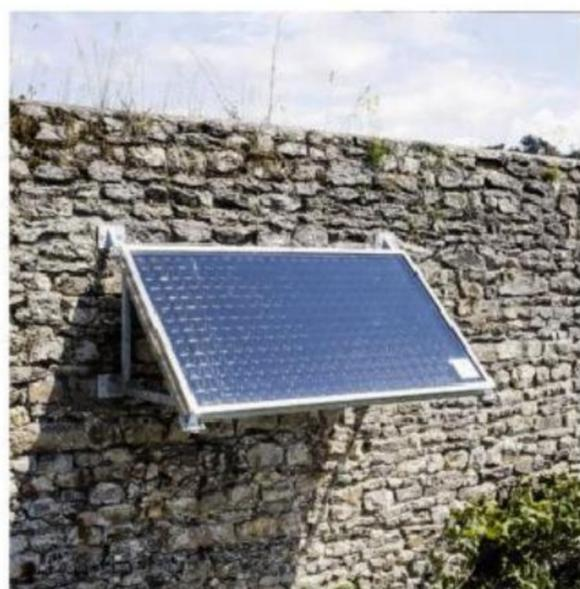
**8/** Des chevilles à expansion ou une fixation chimique sont nécessaires pour supporter le poids de l'appareil et résister aux tractions exercées par le vent.
