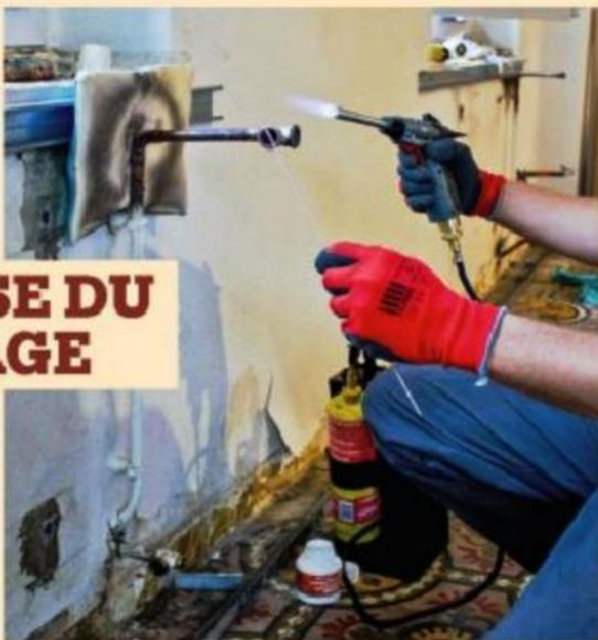
**7** Préparez un raccord et une section de tube en cuivre de même section, coupée suivant l'épaisseur de l'isolant. Brasez le raccord sur l'alimentation existante puis la prolongation.
