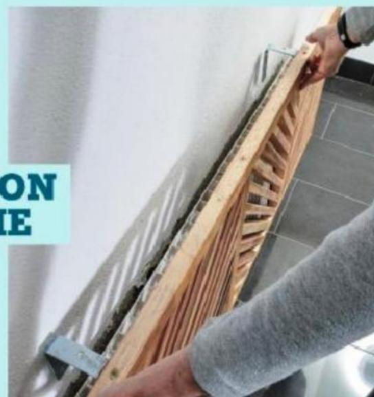
**7** Posez le cache sur le radiateur pour contrôler l'horizontalité. Ajustez les crochets au besoin. Le poids du cache suffit à stabiliser l'ensemble.
