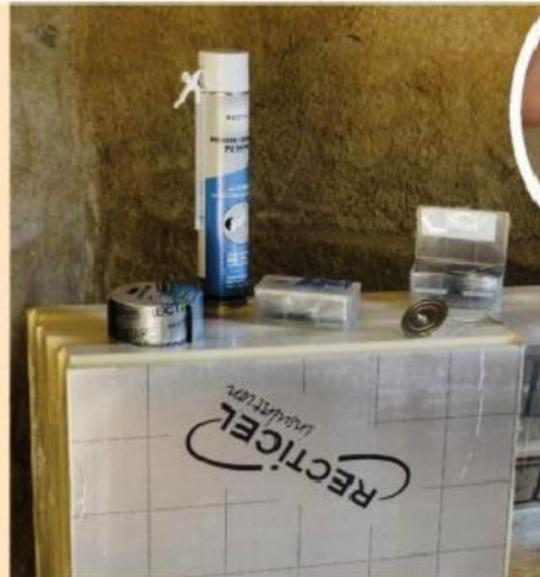
**2** Il est possible de commander chez le fabricant les accessoires de pose : mousse PU expansive en bombe, vis avec rondelles et adhésif pour jointoyer les panneaux.
