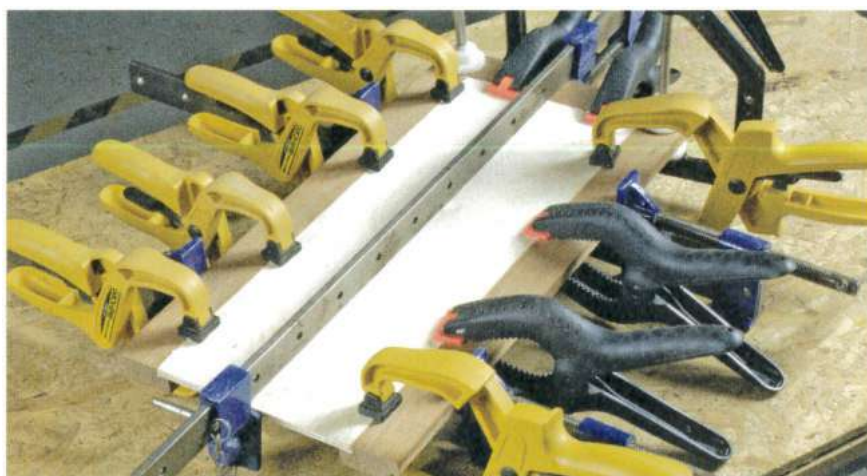
Serrage des éléments d'une des faces de la « table-boîte ». Il faudra vérifier que l'ensemble est bien plan à l'aide d'une règle droite.
