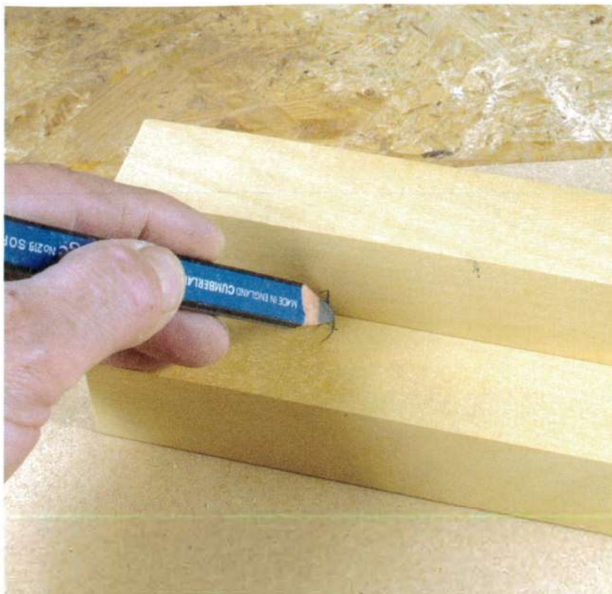
Tracez vos repères de position de rainure de lamelle.
