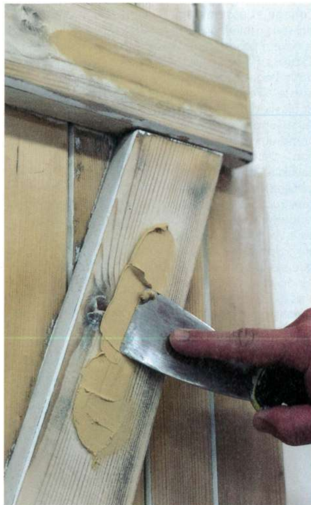
L'enduit de réparation peut être recouvert trois heures après application.
