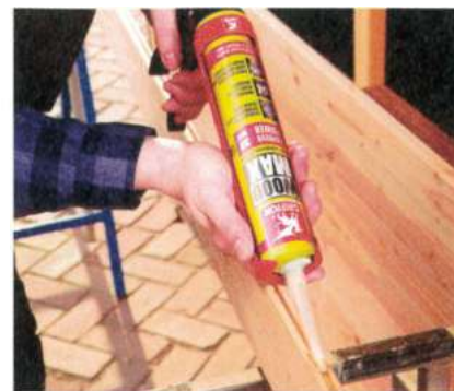
La colle s'applique au pistolet. Le temps d'ouverture est de 5 minutes et le temps de séchage de 30 minutes.
