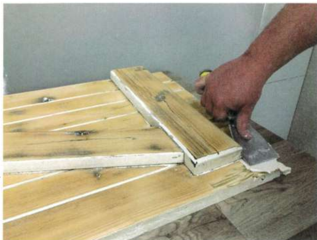
L'enduit de réparation Prestonett de Beissier permet de reprendre des surfaces bois quelle que soit l'épaisseur du trou.
