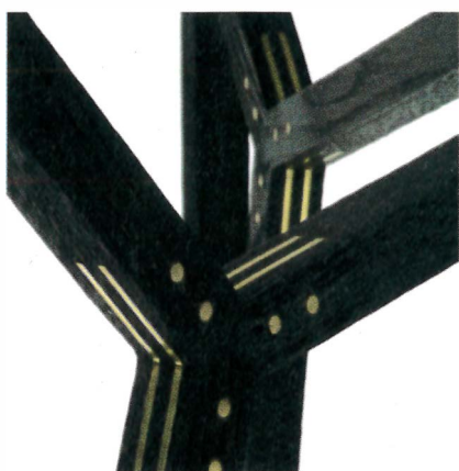
Gros plan sur « l'assemblage à enfourchement triple » une fois terminé.
