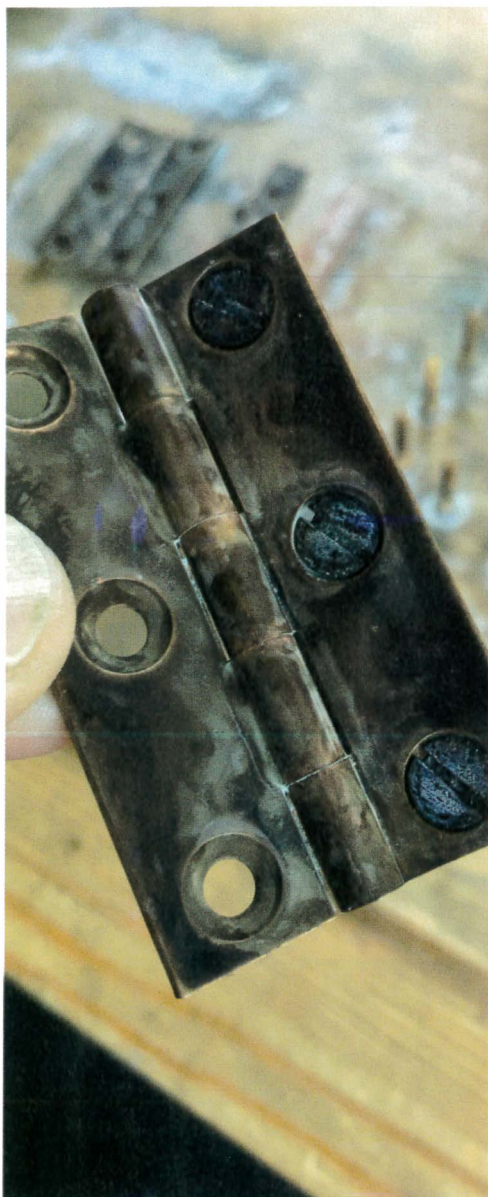
Une deuxième pulvérisation de produit offrira une patine avec des teintes hétérogènes.
