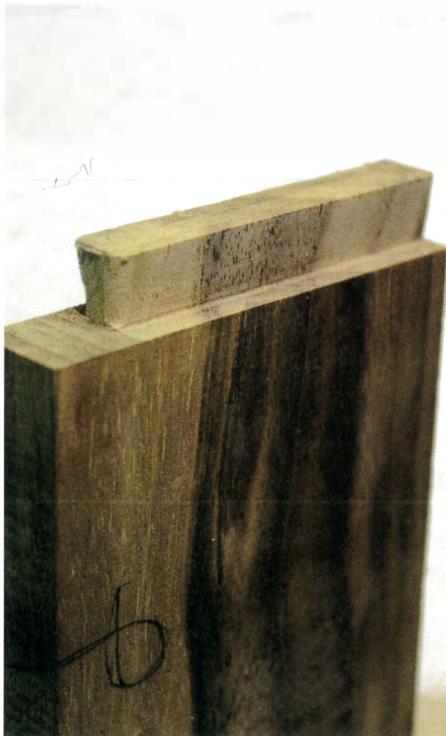
Le tenon en queue-d'aronde pour le montage coulissant.
