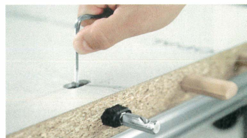
On commence par fixer l'élément traversant...
